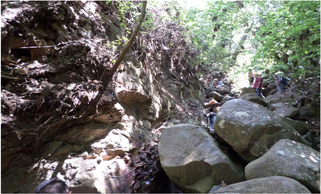
Foto. 1 Cubierta vegetal de la zona baja.
