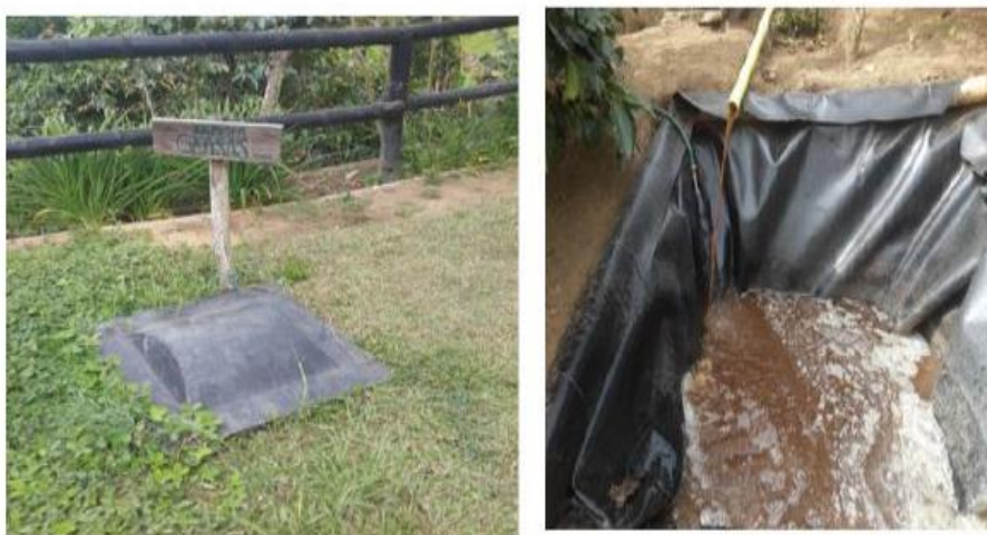
Fotografía 8. Tratamiento preliminar (trampa de grasas) y primario (laguna acidogénica) del beneficio húmedo del café. Fuente: Solarte & Urrea, 2015
