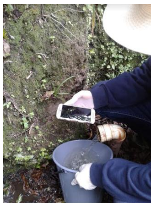
Fotografía 17. Medición del caudal a la salida del humedal mediante el método volumétrico. Fuente: elaboración propia.
