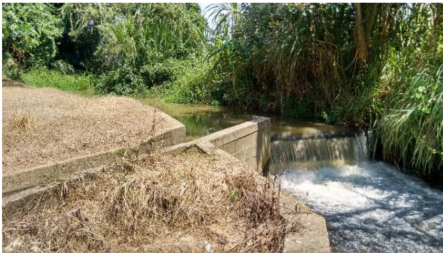
Fotografía No: 1 Lugar: Bocatoma, Zanjón Taula Observación: Derivación del Zanjón Taula para la captación del recurso hídrico.
