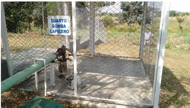
Fotografía No: 1 Lugar: PTAP FAREVA S.A.S Observación: Ubicación de la perforación del pozo Ccs-83, se evidencia la construcción de una caseta con cerramiento perimetral en malla, la cual se encontró en buen estado.
