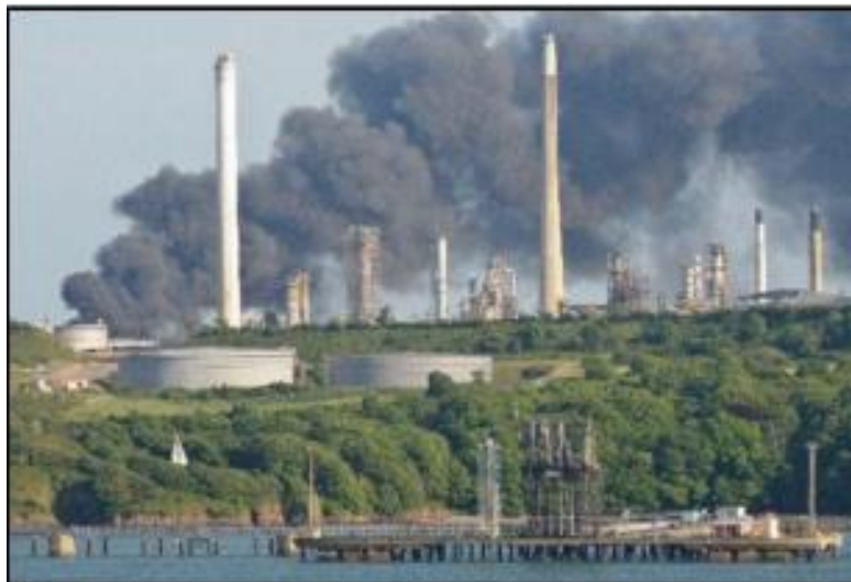
Figura 3: Refinería Texaco en Milford Heaven con combustión incontrolada. (Año 1994) [28]
