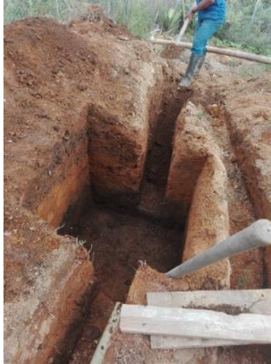
Figura 13. Excavación donde va ubicada la caja sanitaria junto con el ramal
