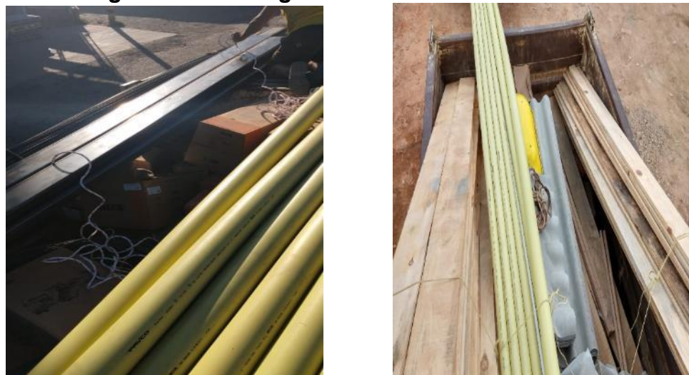
Figura 10. Descargue de materiales de obra
