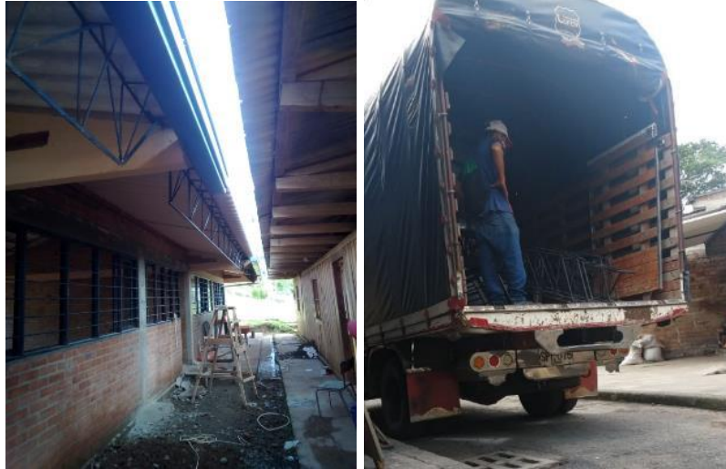
Figura 34. Estructura de las correas metálicas y cargue de correas
