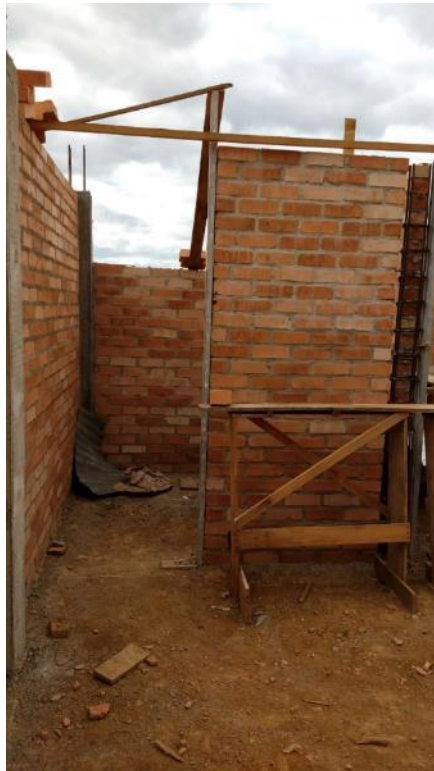
Figura 18. Mampostería confinada a la vista y se observa el espacio dejado para la luceta.
