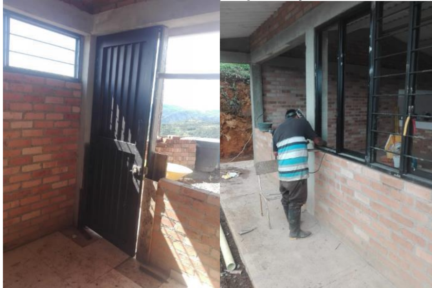
Figura 22. Instalación de puerta y ventanas
