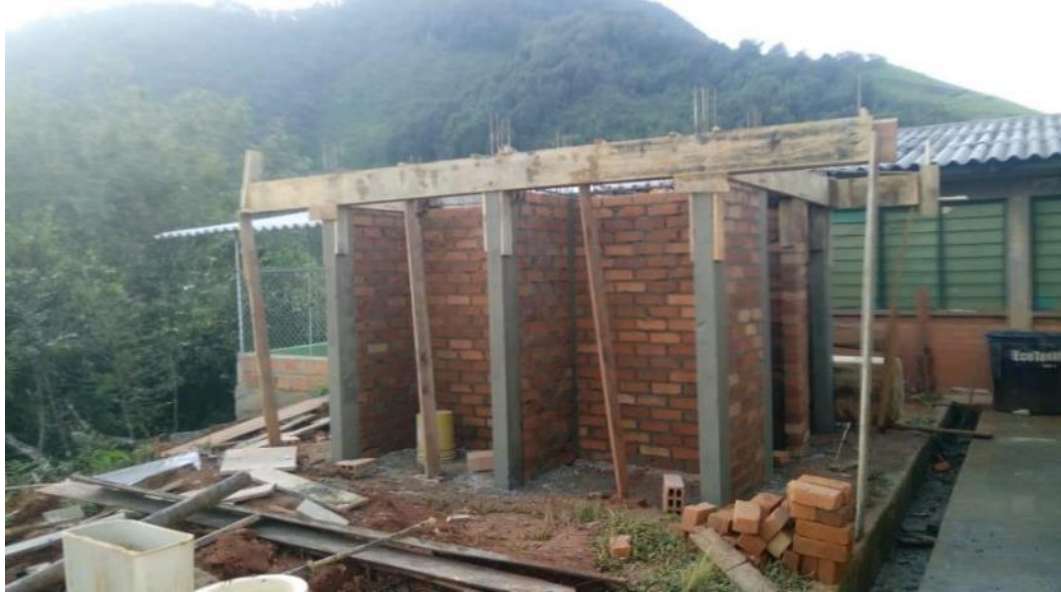
Figura 29. Vigas corona con formaleta
