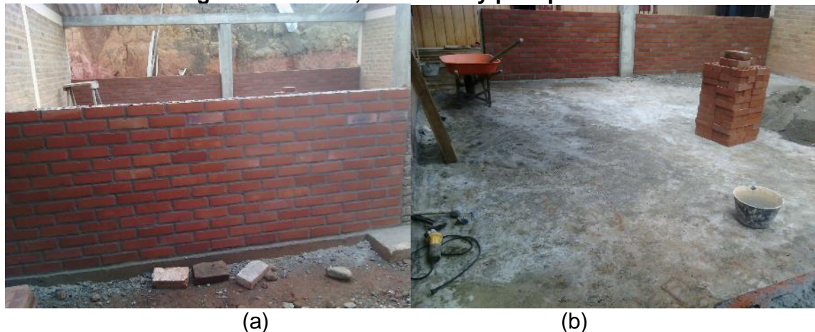
Figura 33. Muros, columnas y piso primario
