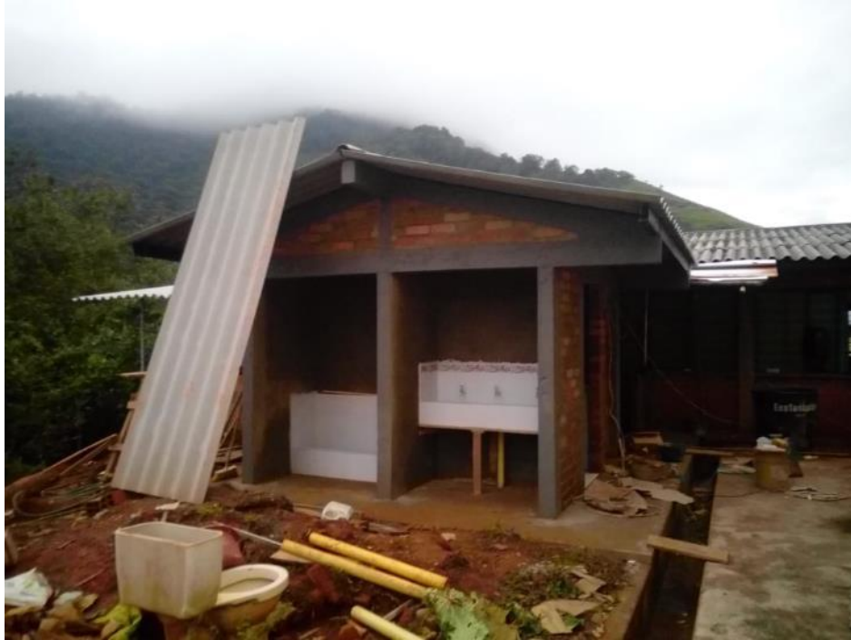
Figura 31. Batería sanitaria con la cubierta.
