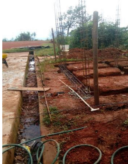
Figura 27. Vigas de cimentación y columnetas
