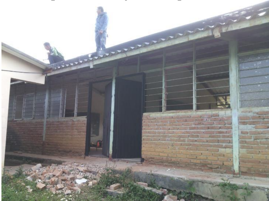
Figura 43. Puertas y canal de aguas lluvias
