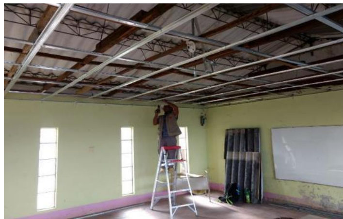
Figura 38. Montaje de estructura para cielo raso en board
