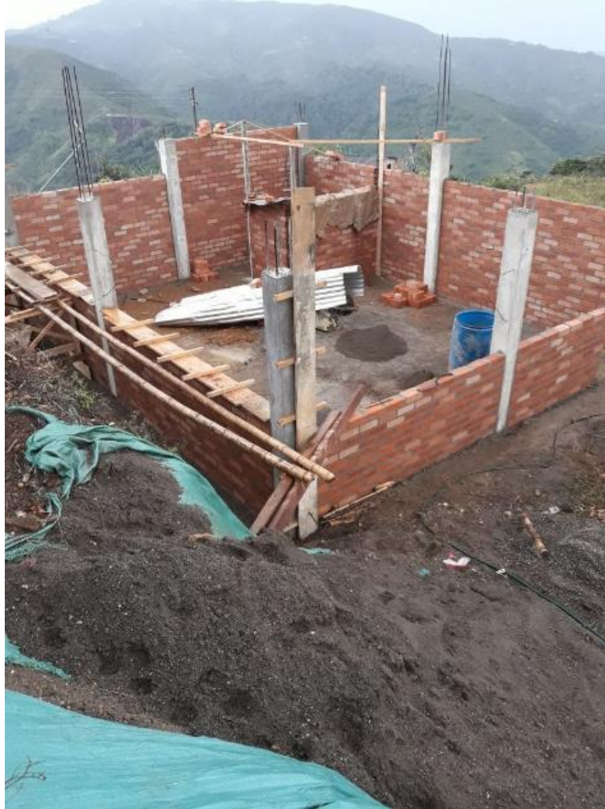
Figura 17. Muros de mampostería confinada.
