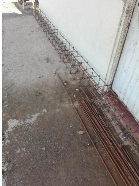
Figura 47. Acero de refuerzo.
