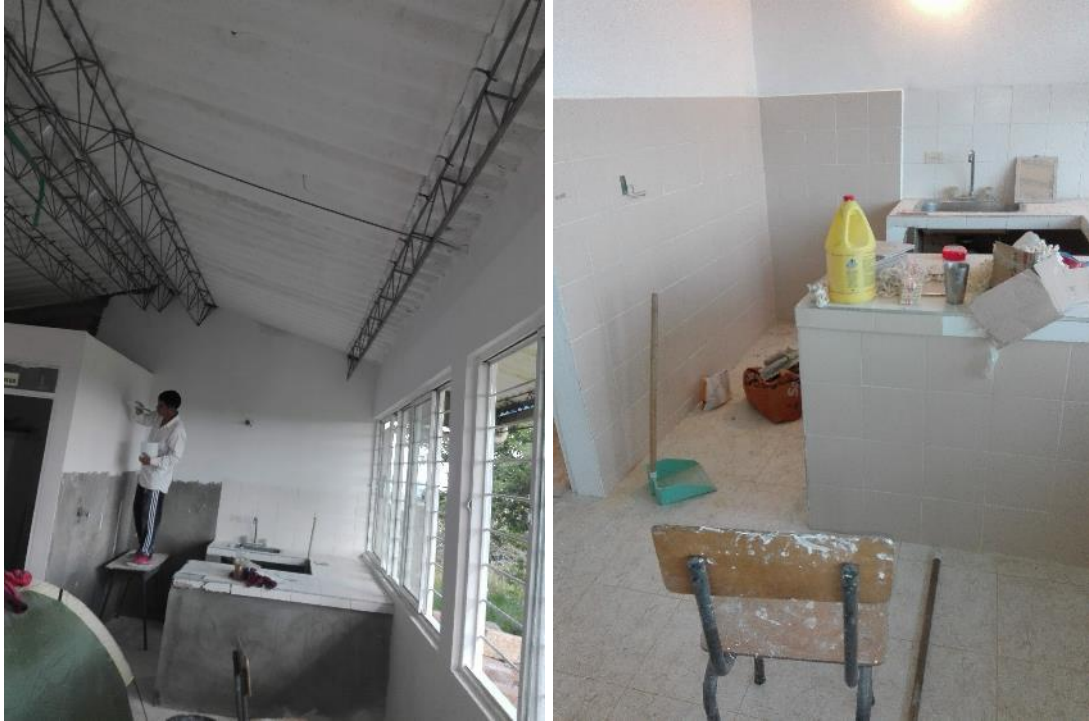
Figura 41. Estuco, pintura y enchape en restaurante.
