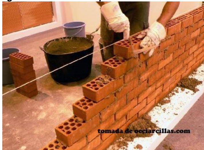
Figura 7. Muro de mampostería no reforzada.
