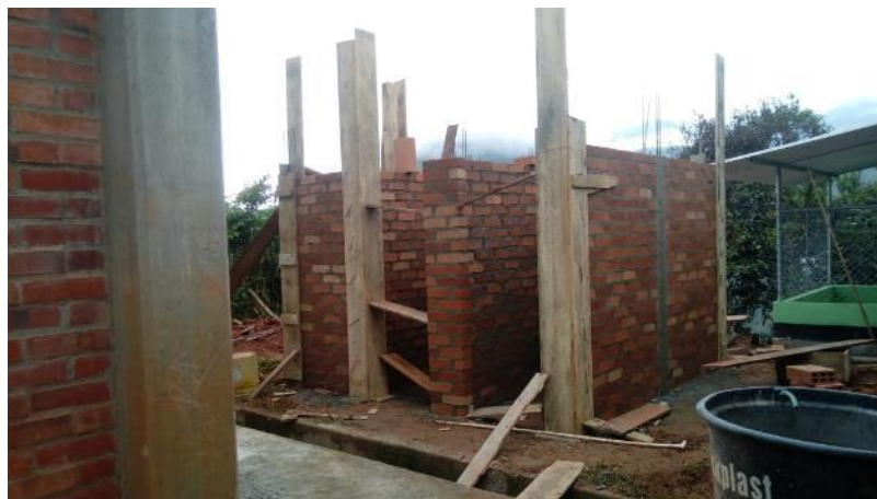
Figura 28. Columnetas y muros de mampostería.
