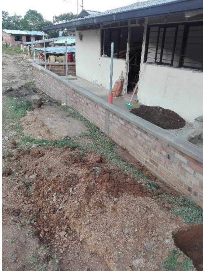
Figura 48. Muro de cerramiento, columnetas y alfajía.
