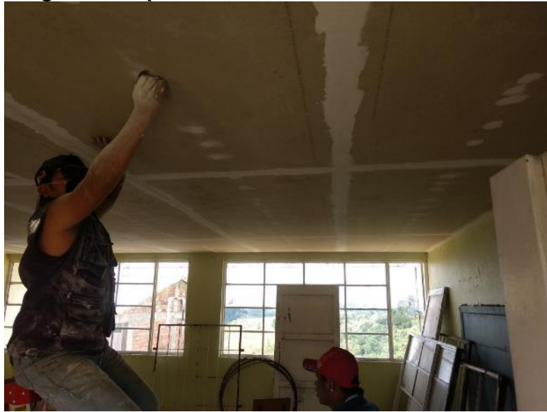
Figura 39. Aplicación de SIKA JOINT a cielo falso
