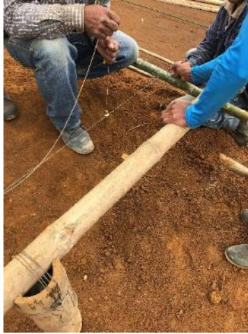
Figura 8. Marcación de ejes, sobre las guaduas
