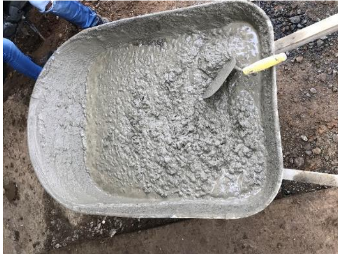
Figura 11. Mezcla fresca de concreto, separada para realizar prueba de slump y fundir cilindros muestra.
