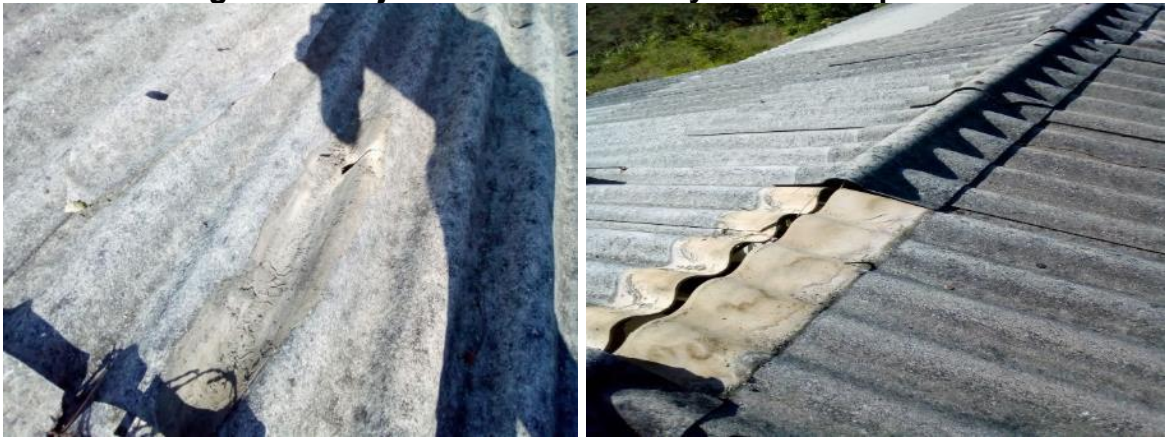
Figura 37. Tejas en fibrocemento y caballetes partidos
