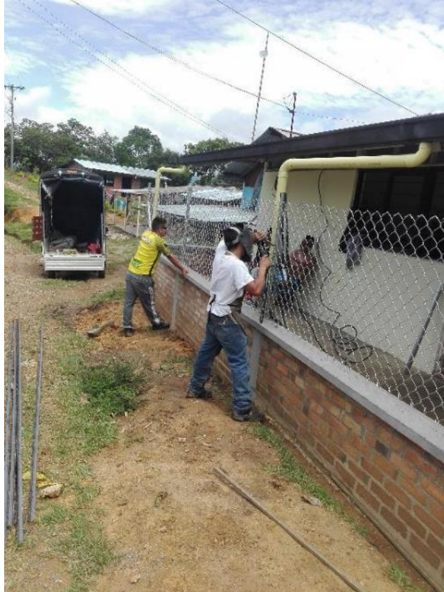
Fuente: fotos tomadas en obra por el pasante
