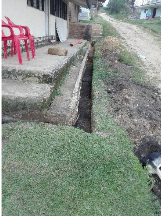
Figura 46. Excavación para la viga de cimentación
