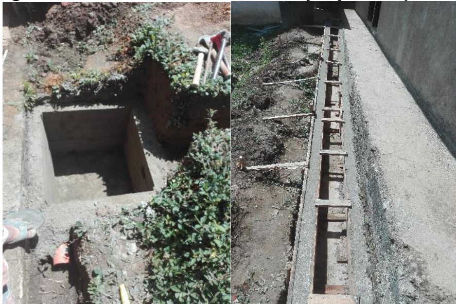
Fuente: fotos tomadas en obra por el pasante
