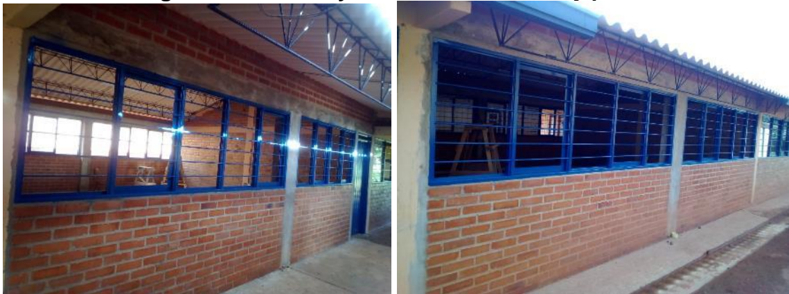
Figura 36. Puertas y ventanas instaladas y pintadas
