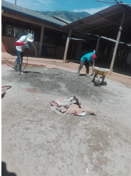
Figura 14. Trabajadores preparando mezcla de concreto.
