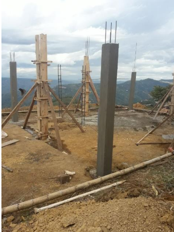
Figura 16. Columnas algunas con su formaleta
