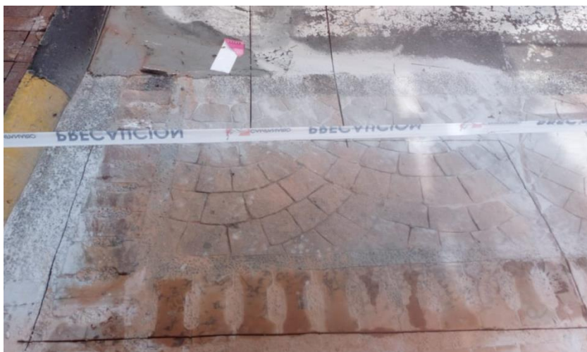
Figura N° 18 (Rojas C, 2018) Corte en pavimento y concreto. Foto tomada en sitio
