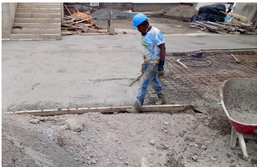
Figura N° 26 (Rojas C, 2019) Fundición de contrapiso y vibrado de concreto. Foto tomada en sitio
