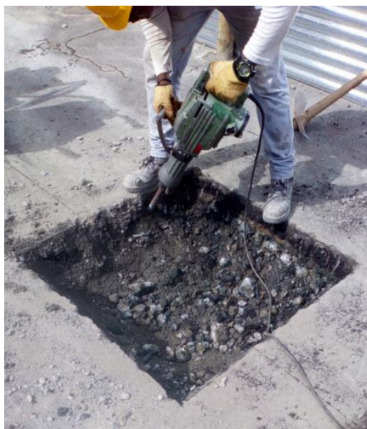
Figura N° 19 (Rojas C, 2018) Demolición y excavación de zapatas. Foto tomada en sitio
