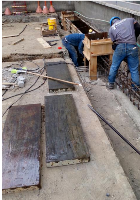
Figura N° 10. (Rojas C, 2018) Formaleta para vigas y zapatas. Foto tomada en sitio
