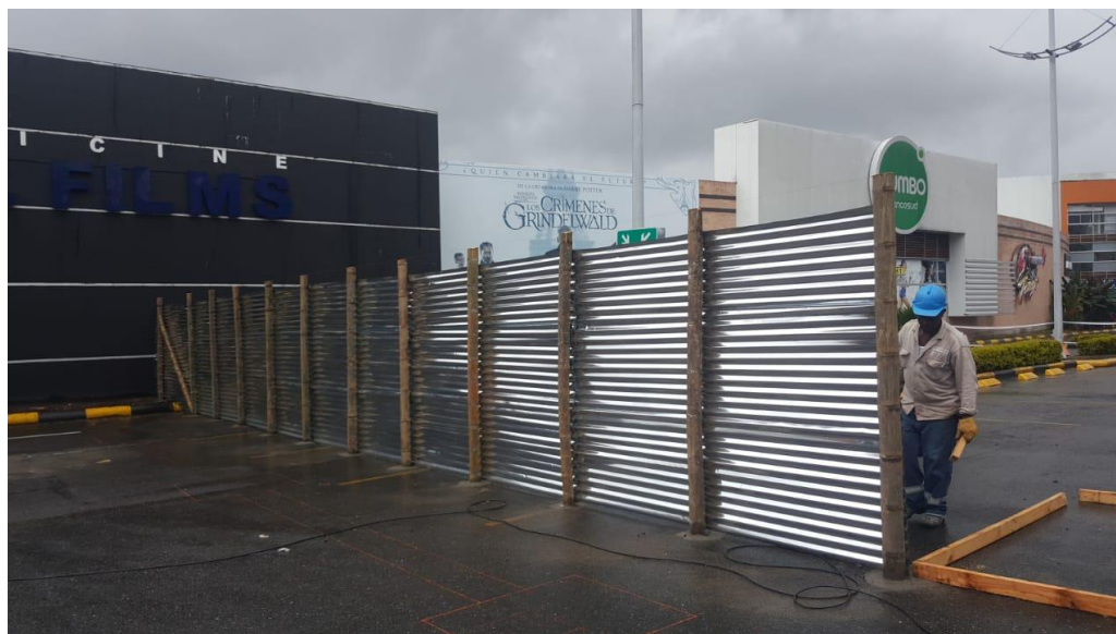
Figura N° 21 (Rojas C, 2018) Cerramiento de obra con ayuda del personal de MEISA. Foto tomada en sitio
