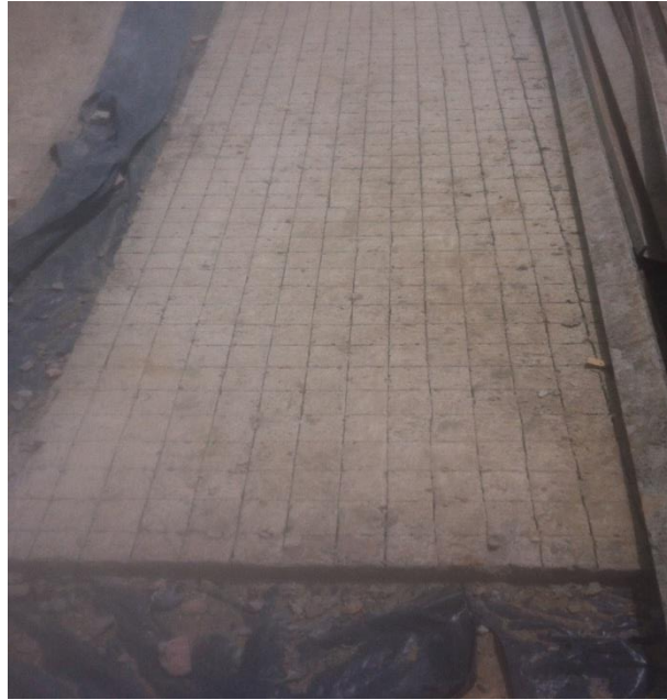
Figura N° 9. (Rojas C, 2018) Separadores hechos con mortero para garantizar recubrimientos. Foto tomada en sitio
