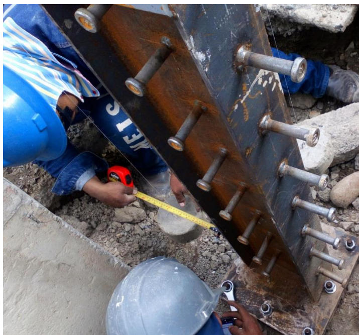
Figura N° 13. (Rojas C, 2019) Chequeo de plomos para verificar verticalidad de la columna metálica. Foto tomada en sitio
