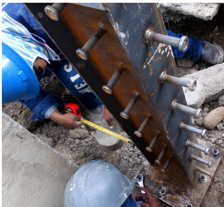
Figura N° 30. (Rojas C, 2019) Chequeo de verticalidad en columna metálica. Foto tomada en sitio
