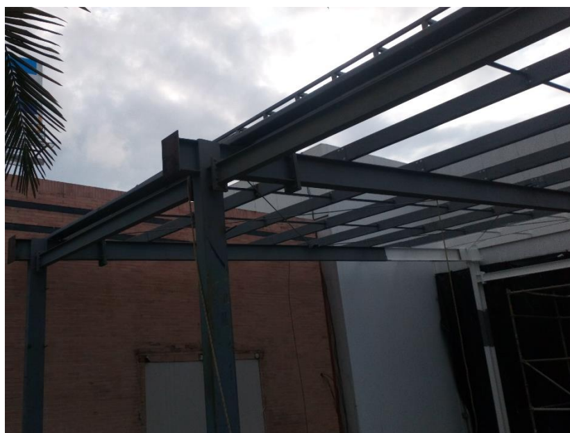
Figura N° 31. (Rojas C, 2019) Estructura metálica aporcada. Foto tomada en sitio
