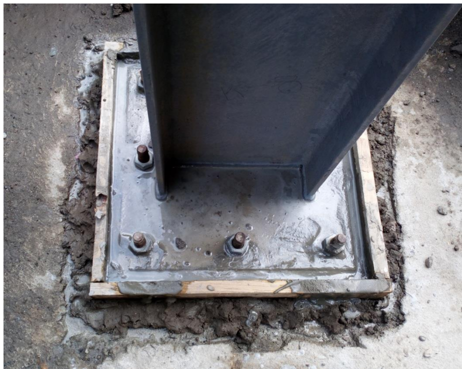
Figura N° 16. (Rojas C, 2019) Pata de columna metálica sobre base en Sika grout. Foto tomada en sitio
