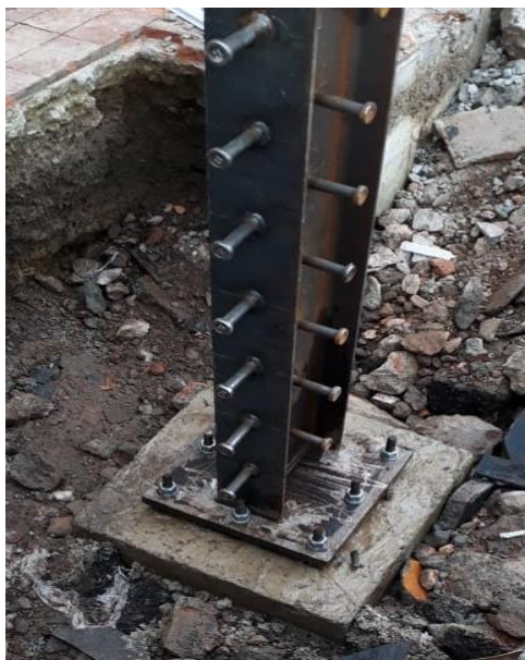
Figura N° 29. (Rojas C, 2019) Conexión de Columna metálica y pedestal empotrado en zapata. Foto tomada en sitio
