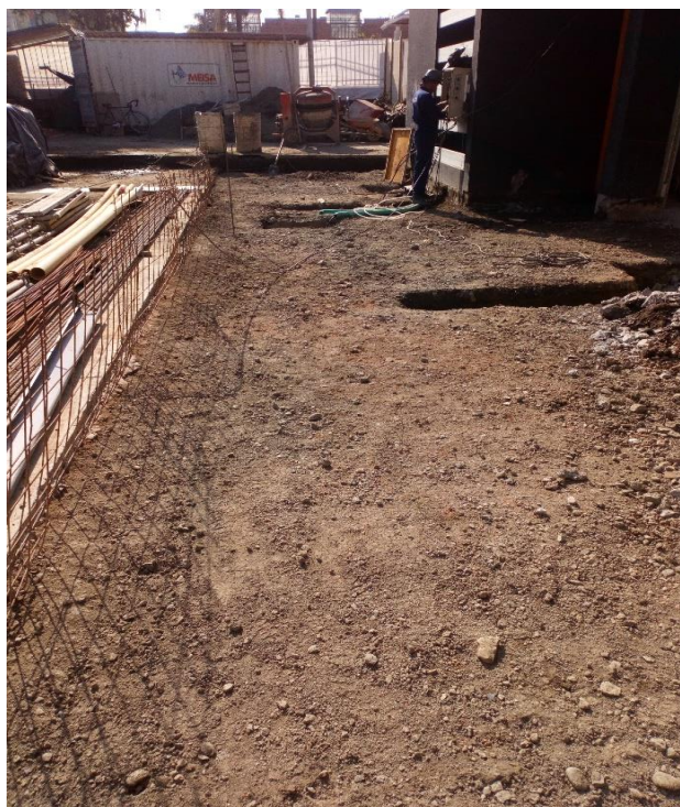
Figura N° 25 (Rojas C, 2018) Terreno limpio y listo para compactación. Foto tomada en sitio
