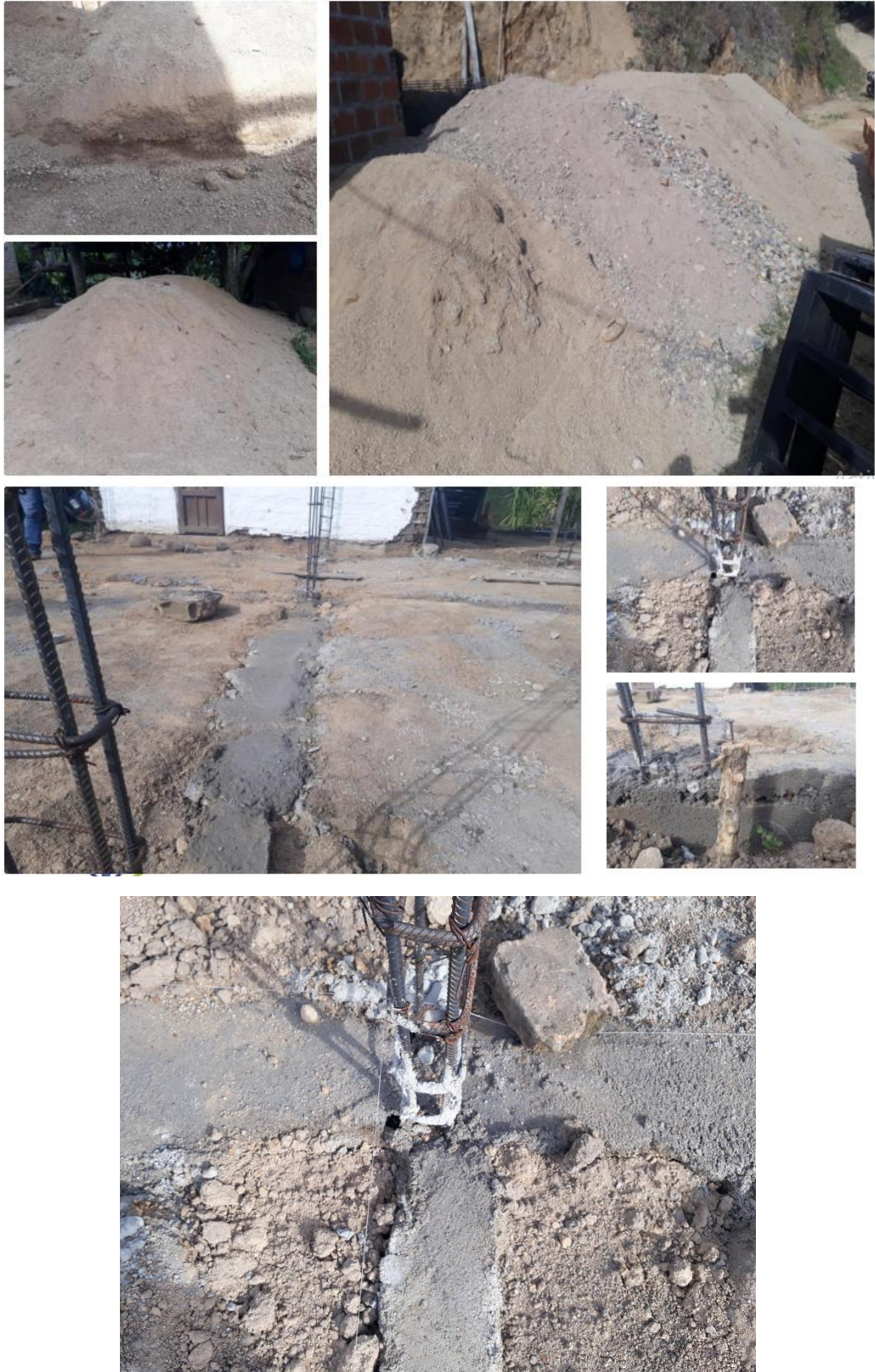
Ilustración 21. Registro fotográfico viga cimentación vereda los Alpes
