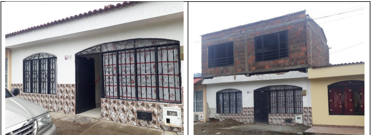
Ilustración 2. Registro fotográfico Cra. 5E # 12ª-59 Br. Libertadores 3ra etapa.
