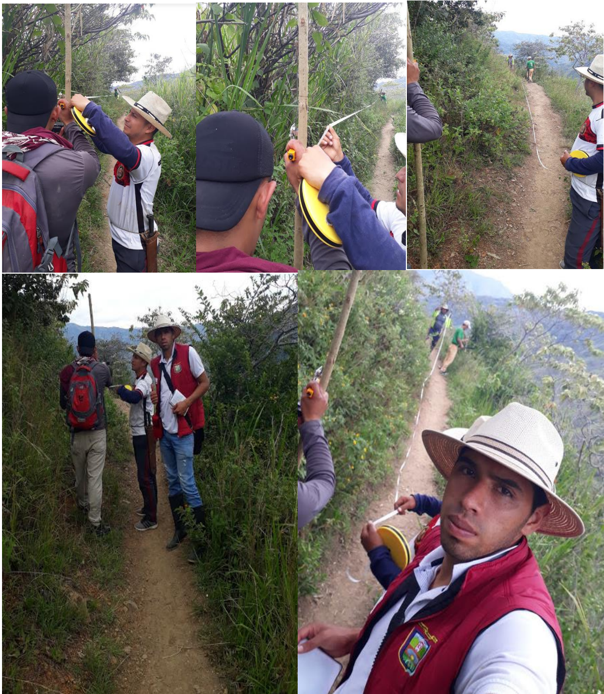
Ilustración 42 Trazado de línea de pendiente 2.0 km para el mejoramiento de caminos en la vereda higuerones corregimiento del Rosal
