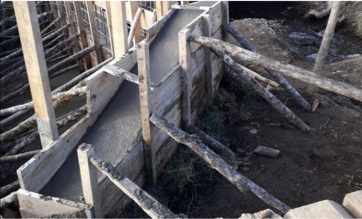
Ilustración 22 Concreto 21 mpa para aletas h=4.5 metros l=2 metros
