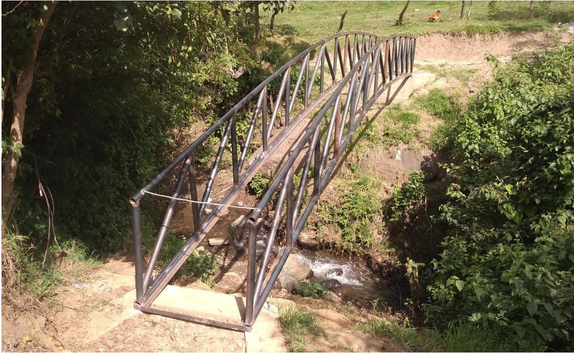
Ilustración 32 Colocación de la estructura metálica en tubo estructural diámetro 2"
