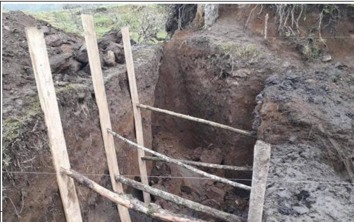
Ilustración 18 Localización y replanteo, excavación en material común
