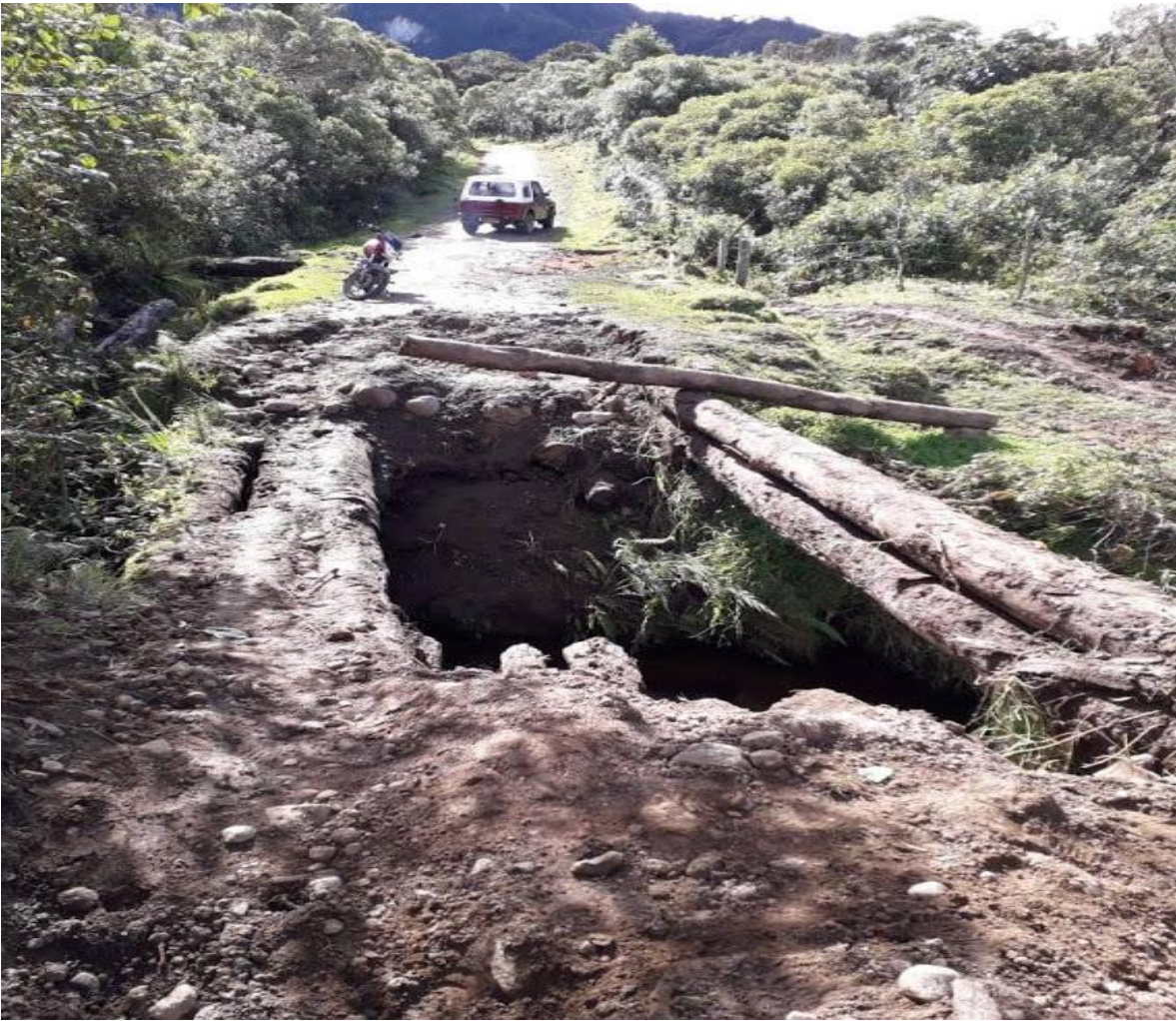
Ilustración 17 Desmante de estructura en madera
