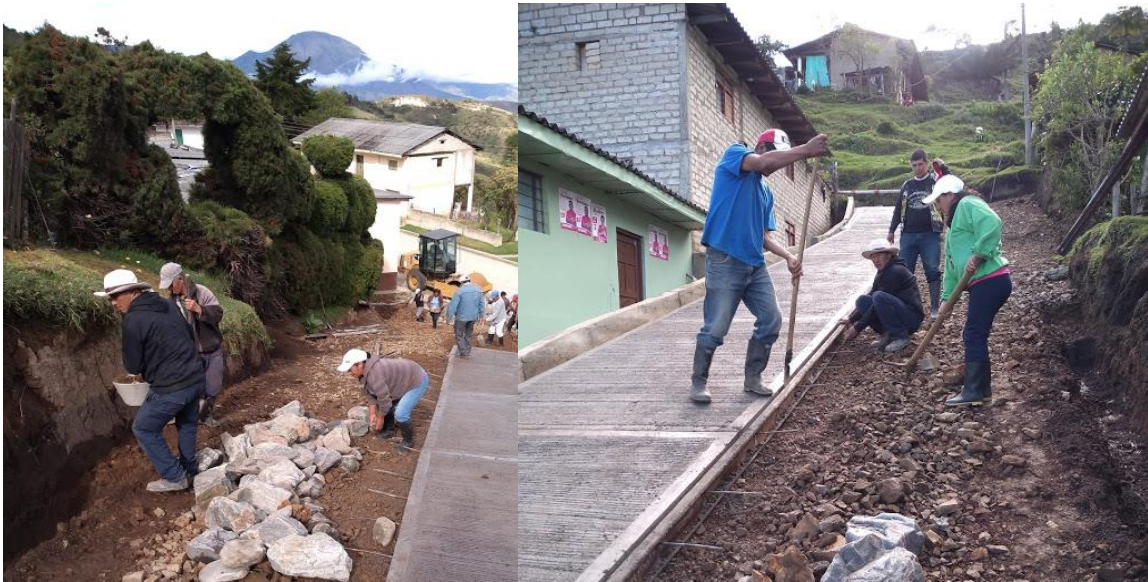
Ilustración 40 Acompañamiento técnico a la junta de acción comunal de belén corregimiento de Santiago en la construcción de la obra comunitaria pavimento rígido hacia Belén.
