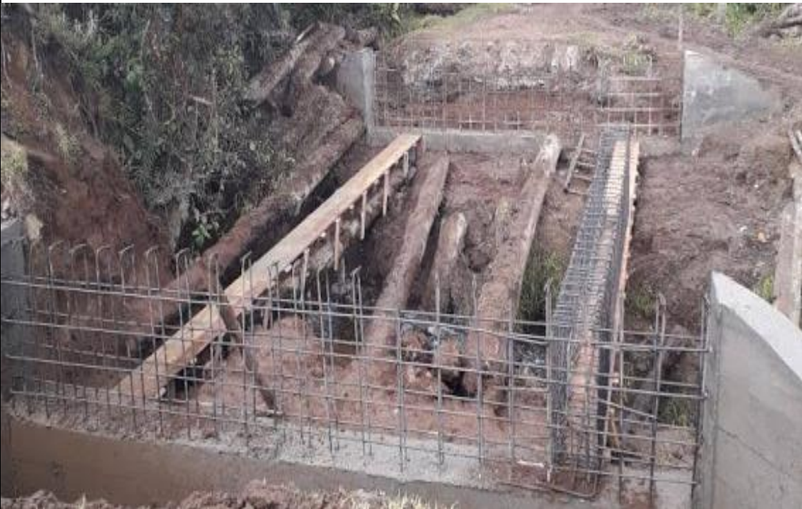
Ilustración 20 Acero de refuerzo vigas principales y estribos
