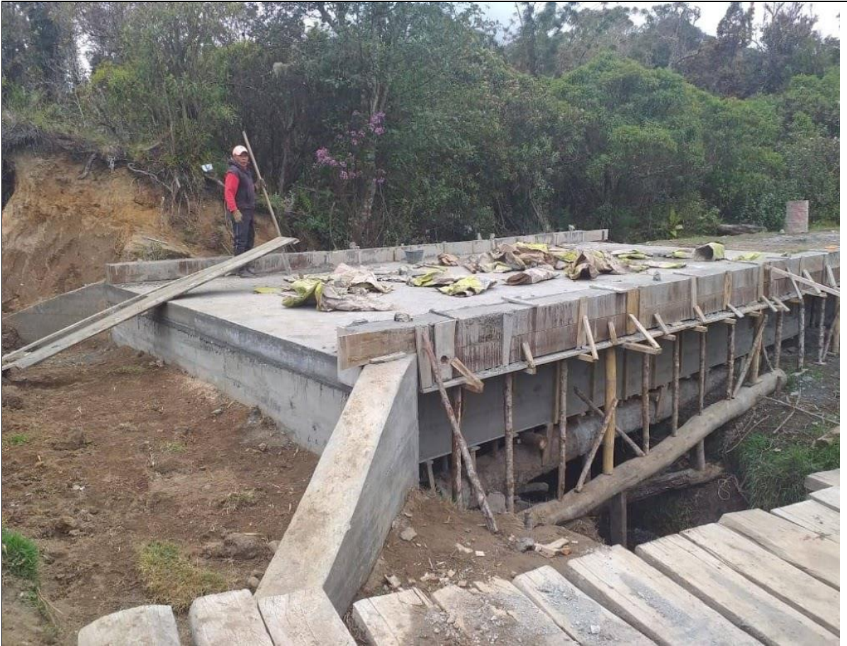
Ilustración 24 vista general del puente
