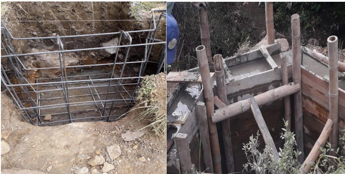
Ilustración 31 Armado del refuerzo
