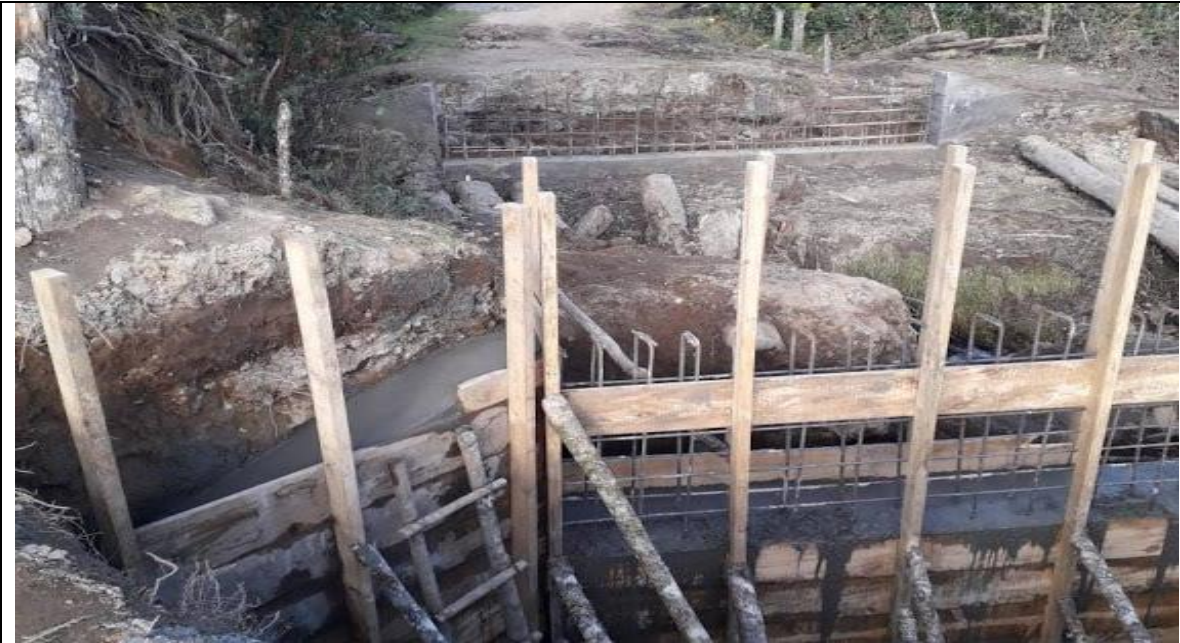
Ilustración 21 . Concreto 21 mpa para estribos principales h=4,50 metros y acero
