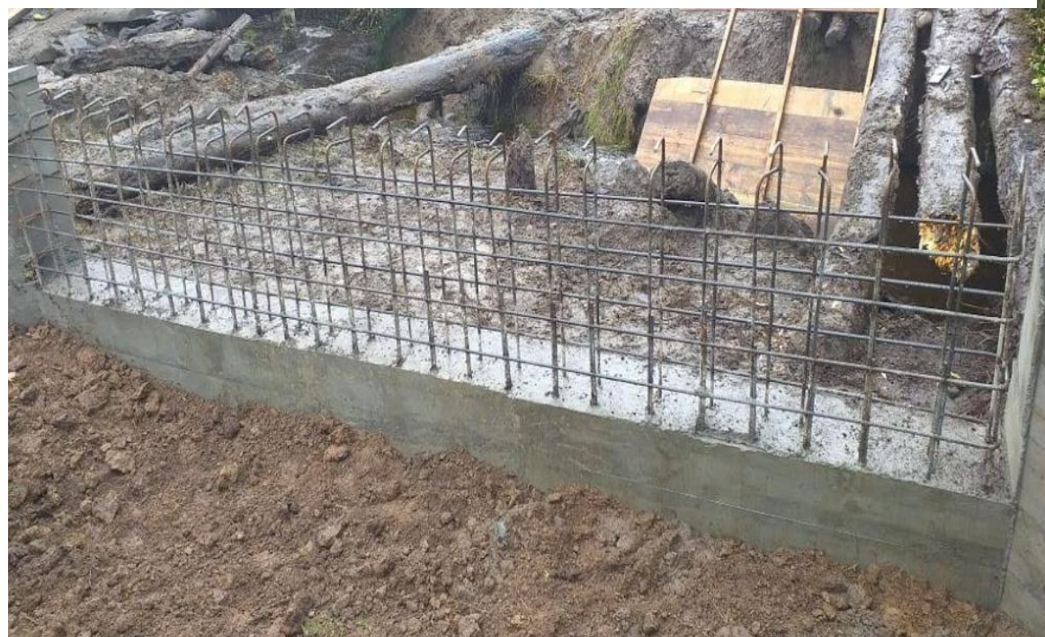
Ilustración 19 Estribos en concreto reforzado y acero de refuerzo
