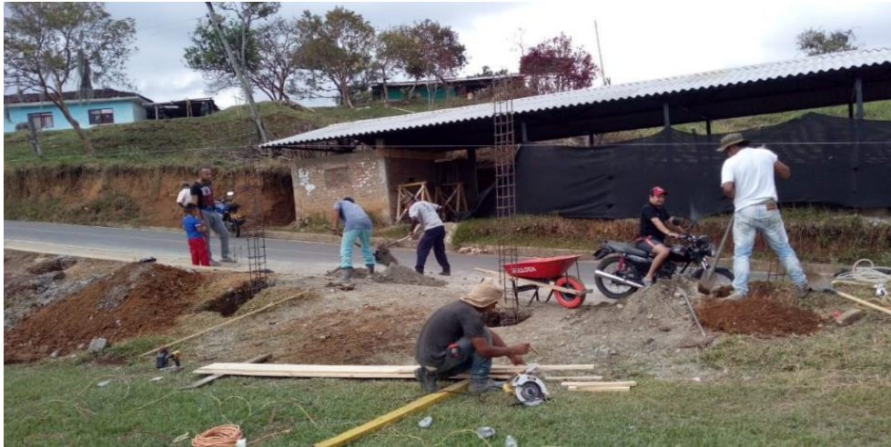
Figura 3. Excavación a mano de zapatas y muertos.
