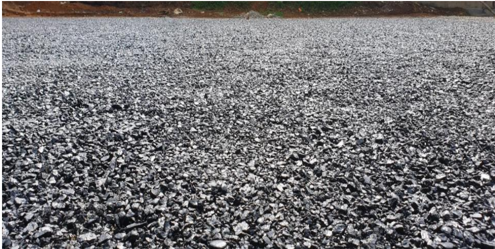
Figura 15. Riego de la emulsión asfáltica.
