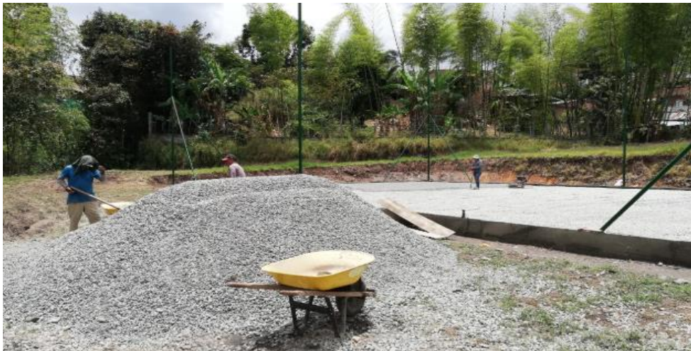
Figura 14. Compactación del material granular.
