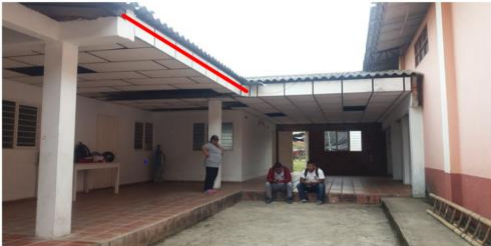
Figura 20. Sector del techo a mejorar.
