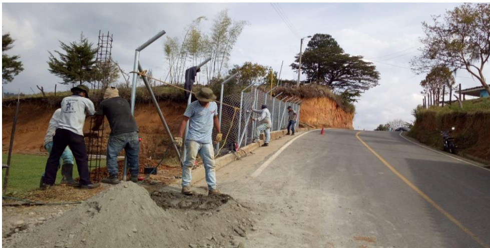
Figura 8. Ubicación del acero de refuerzo de las columnas y mezclado del concreto.
