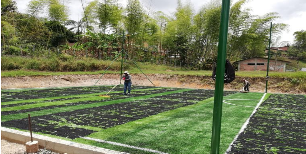
Figura 16. Rego uniforme del caucho granular sintético.
