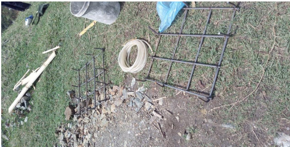
Figura 5. Armado del acero de refuerzo de zapatas y muertos.
