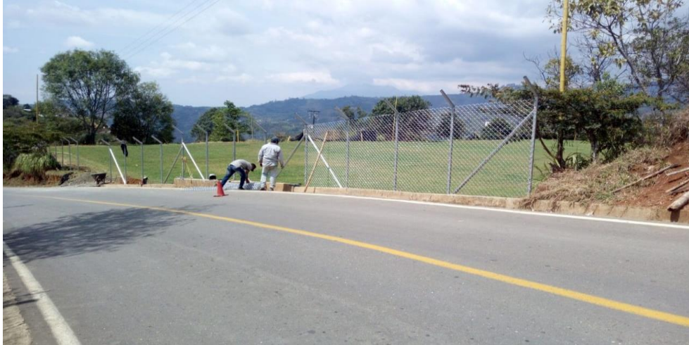
Figura 9. Instalación de la malla galvanizada.
