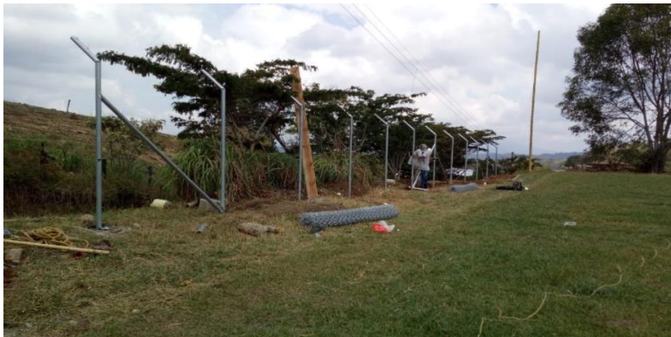
Figura 7. Fundición de todos los muertos y ubicación de los tubos galvanizados.
