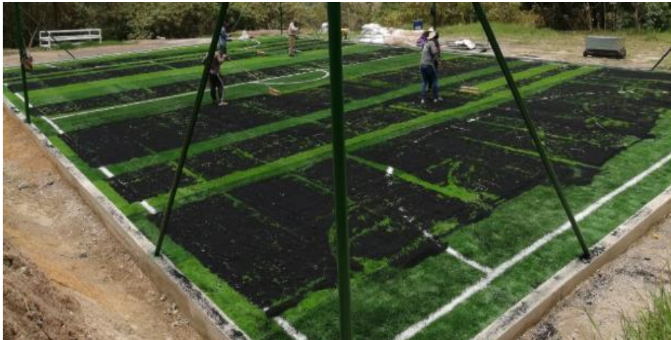
Figura 17. Distribución del caucho granular sobre el campo.
