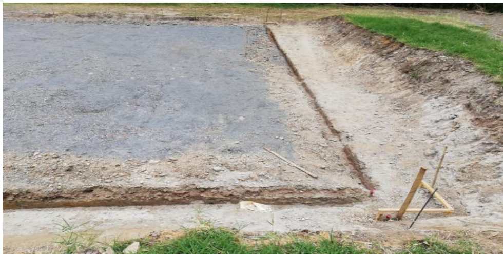
Figura 13. Excavación manual de los bordillos.
