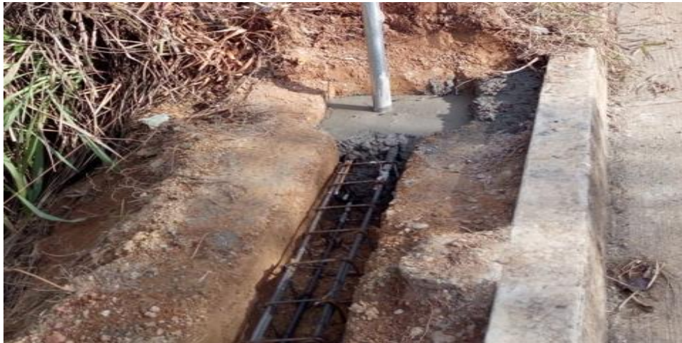
Figura 4. Instalación del acero de refuerzo de las vigas de enlace.
