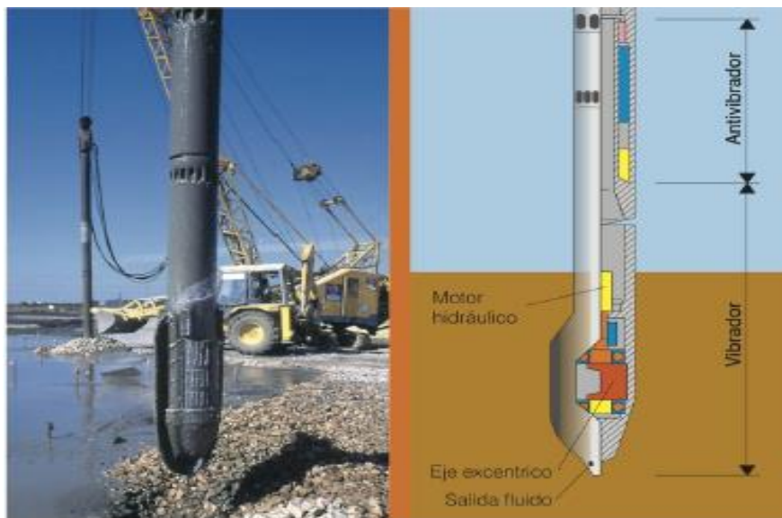
Figura 6- Vibrador para retirar el material nativo por vía húmeda (Mora & Carvajal, 2014)
