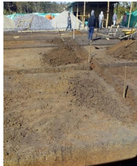
Imagen 72. Excavación de zanjas de cimentación.
