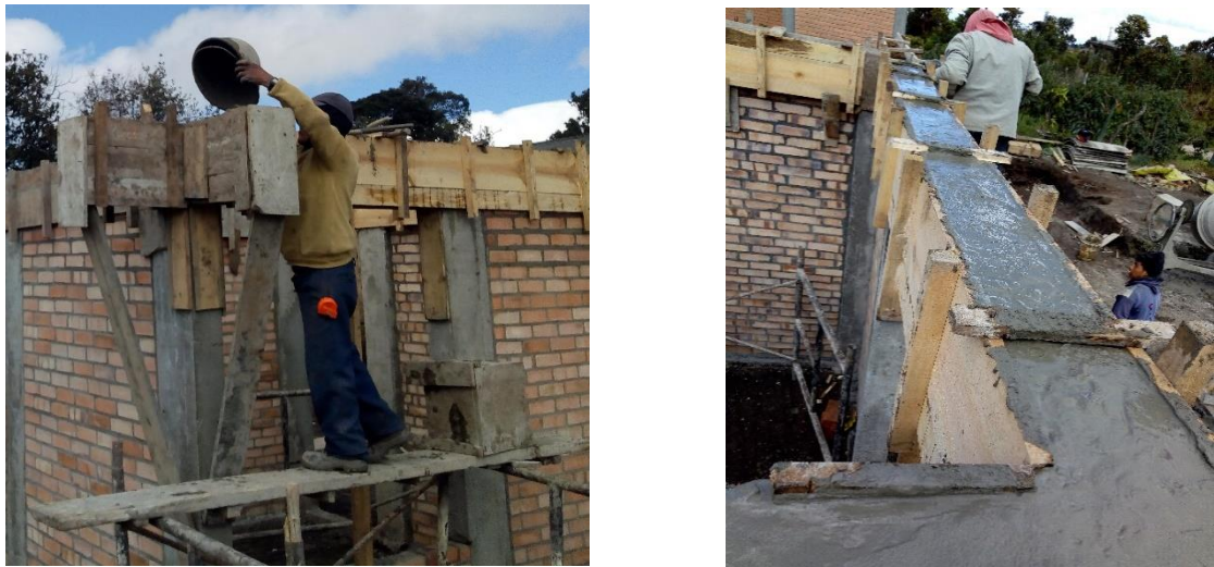
Imagen 68. Fundición vigas de cubierta.
