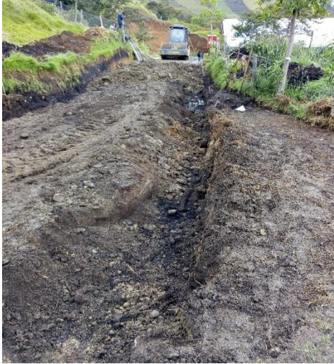
Imagen 20. Descapote y cajeo realizado por la retroexcavadora.
