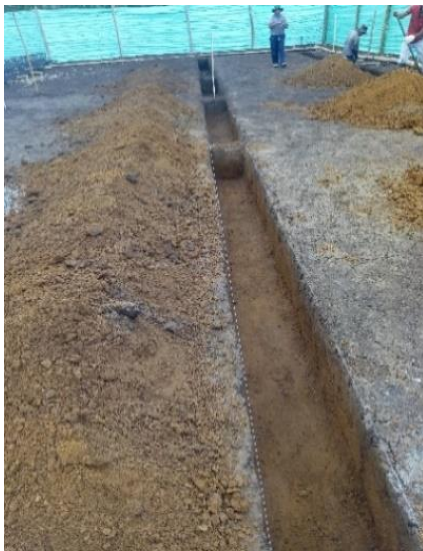
Imagen 72. Excavación de zanjas de cimentación.
