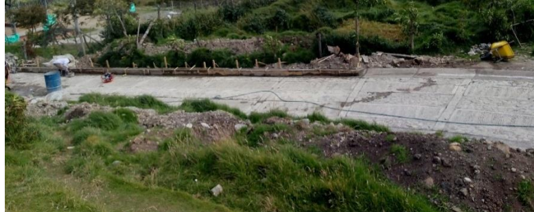
Imagen 50. Primer tramo de la placa huella, terminado.
