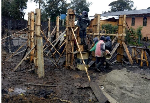
Imagen 58. Fundición de columnas fachada principal.
