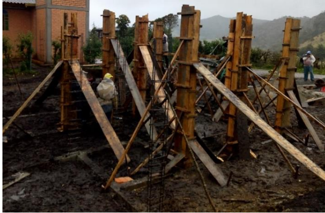
Imagen 57. Armado de formaletas de columnas.
