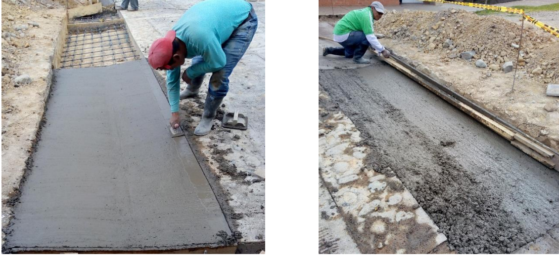
Imagen 44. Fundición cuneta de ingreso al parqueadero.
