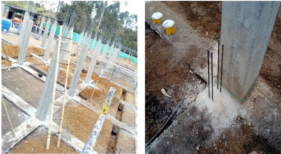
Imagen 79. Columnas fundidas/Anclaje de barras para columnetas.
