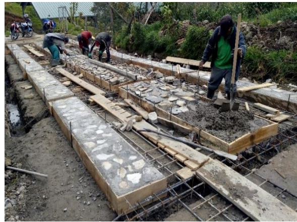
Imagen 29. Fundición cajones en piedra pegada, primer tramo recto de la placa huella.
