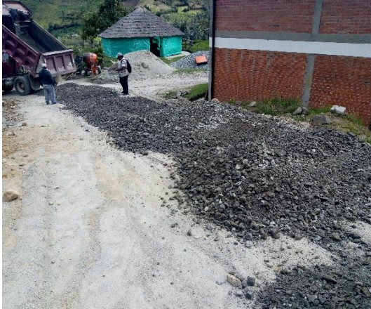
Imagen 24. Nuevo material para compactar la sub-base.
