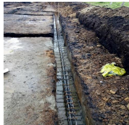
Imagen 55. Zanjas para cimentación y detalle del acero para cimentación.
