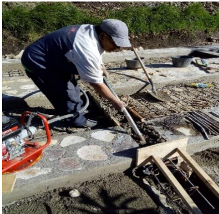
Imagen 30. Fundición y vibrado de riostras y resultado final.
