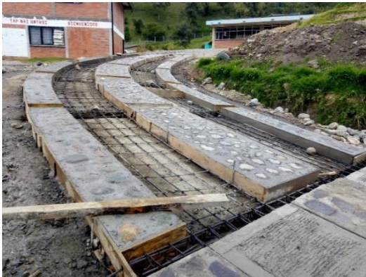
Imagen 34. Tramos de la curva terminados en piedra pegada.
