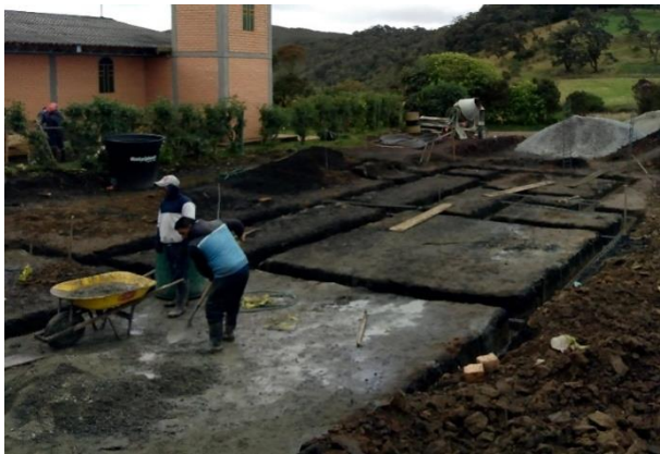
Imagen 55. Zanjas para cimentación y detalle del acero para cimentación.
