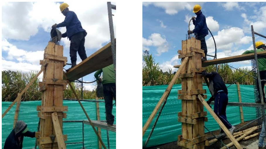
Imagen 78. Fundición de columnas y vibrado de la mezcla.
