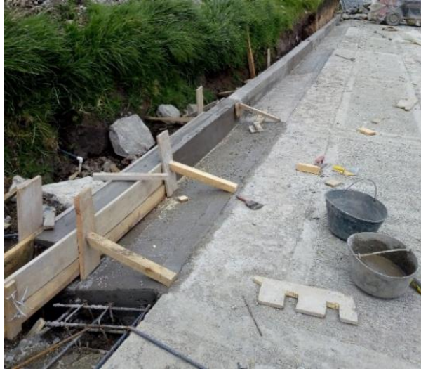
Imagen 40. Cuneta y bordillo terminados, lado derecho de la placa.
