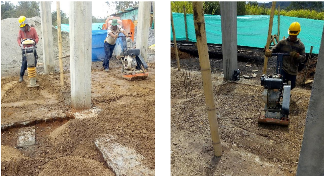
Imagen 82. Compactación y relleno de terreno.
