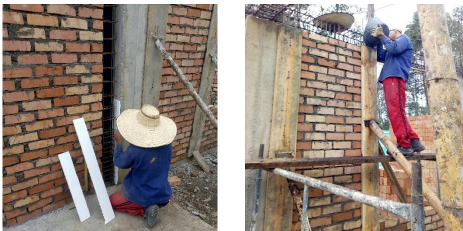
Imagen 86. Detalle icopor para dilatación/Fundición columnetas.
