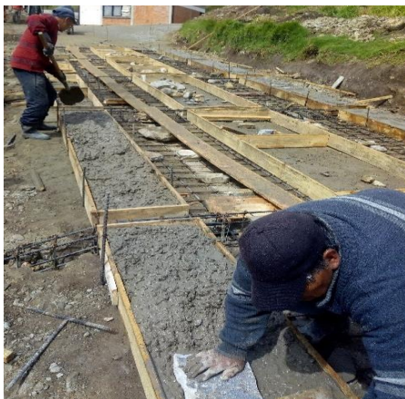
Imagen 29. Fundición cajones en piedra pegada, primer tramo recto de la placa huella.
