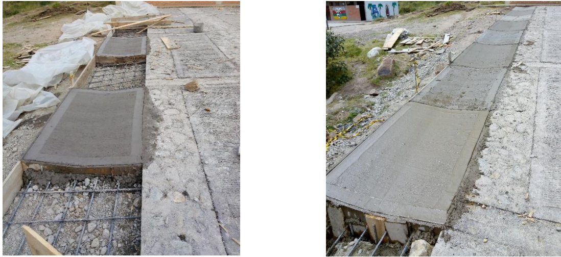
Imagen 45. Fundición cuneta lado izquierdo.
