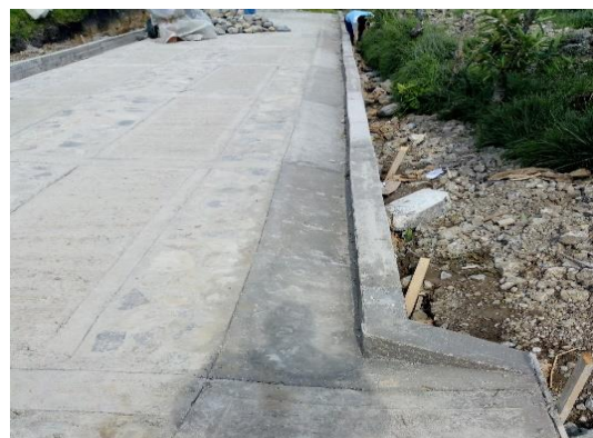
Imagen 49. Cuneta y bordillo del último tramo, terminados.
