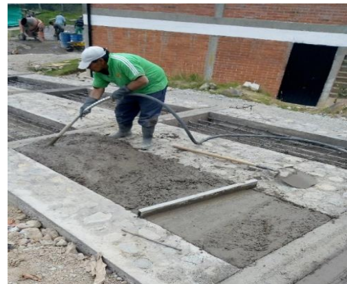
Imagen 36. Fundición placa huella último tramo.
