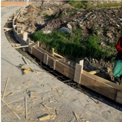
Imagen 41. Formaleta continua del bordillo, en el lado derecho.
