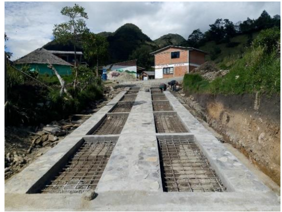
Imagen 30. Fundición y vibrado de riostras y resultado final.
