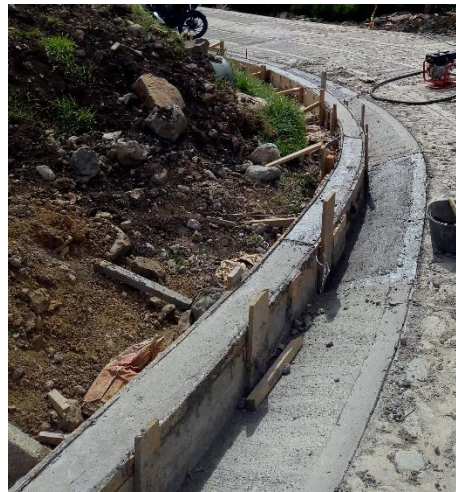
Imagen 43. Cuneta y bordillo en la curva.
