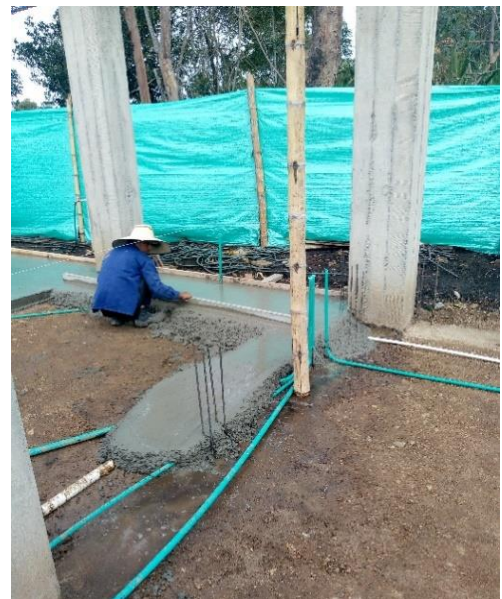
Imagen 83. Fundición placa piso primario.
