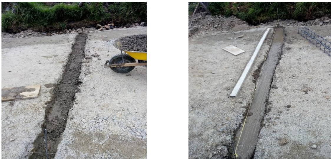
Imagen 27. Fundición solado en las riostras.
