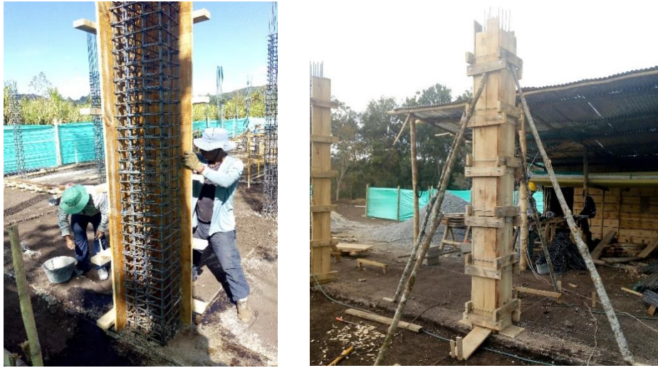
Imagen 77. Armado de formaletas/formaleta lista para fundir.
