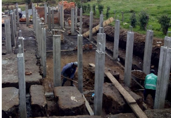
Imagen 61. Excavación y nivelación manual del terreno.
