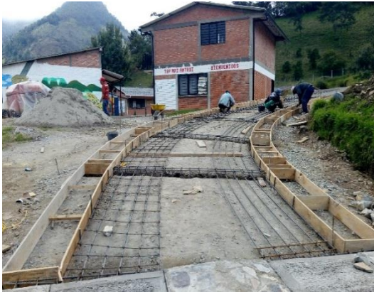
Imagen 33. Armado de formaletas para la curva.
