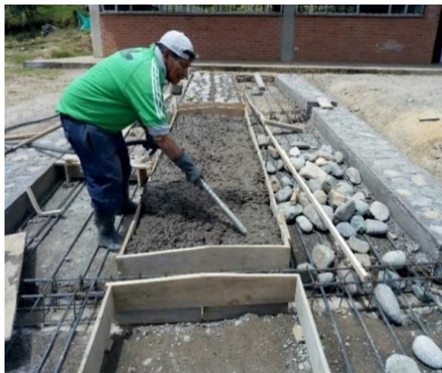
Imagen 36. Fundición placa huella último tramo.
