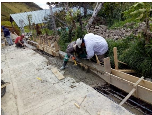
Imagen 48. Fundición cuneta y bordillo último tramo.
