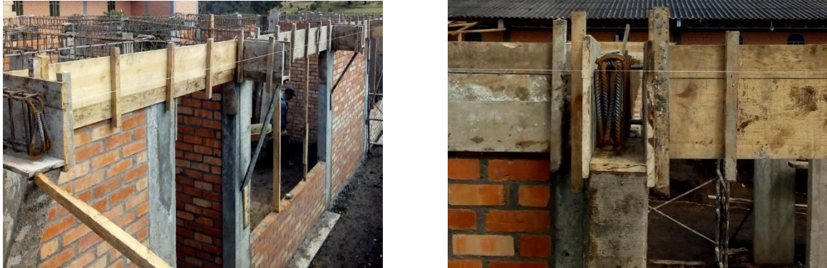
Imagen 67. Vista de las formaletas para vigas.
