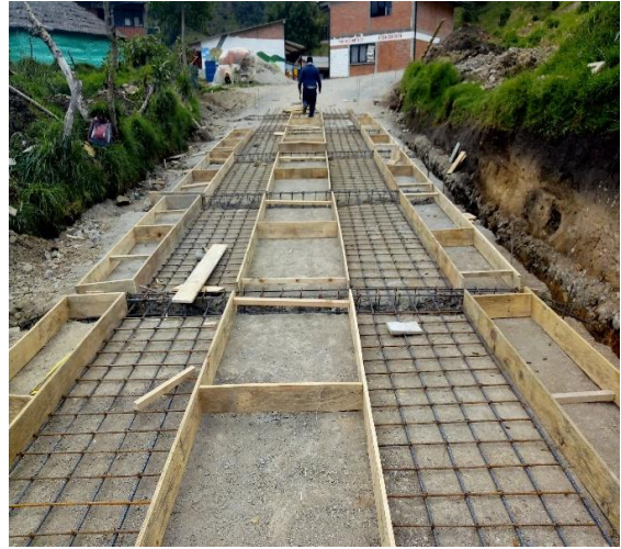
Imagen 28. Armado cero de refuerzo y formaletas en el primer tramo recto de la placa.
