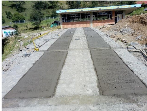
Imagen 37. Último tramo de la placa huella terminado.
