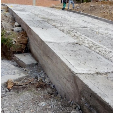
Imagen 46. Muro de soporte cuneta.
