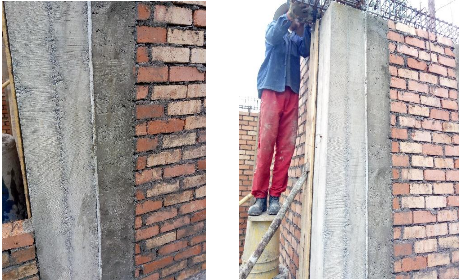
Imagen 87. Columneta desencofrada/Fundición columneta.
