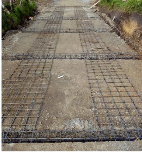
Imagen 28. Armado cero de refuerzo y formaletas en el primer tramo recto de la placa.
