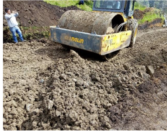
Imagen 23. Compactación de la sub-base con cilindro vibro compactador.
