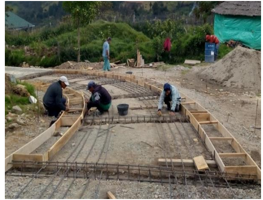
Imagen 33. Armado de formaletas para la curva.
