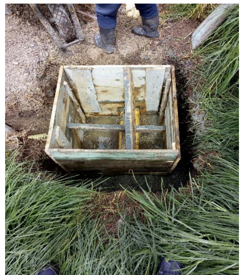
Imagen 18. Instalación tubería 6" y fundición de caja de inspección.
