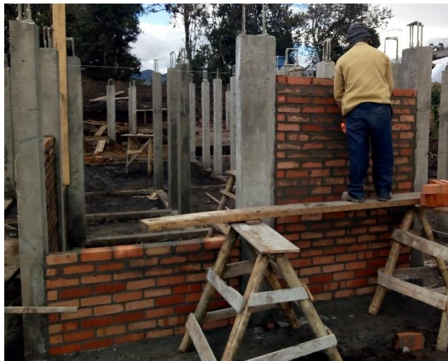
Imagen 60. Mampostería de la fachada principal.
