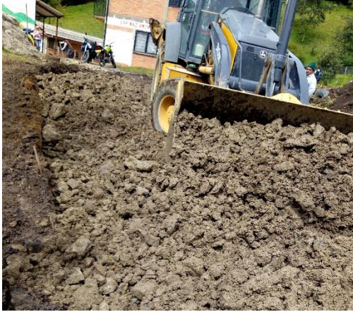
Imagen 22. Regado de material de sub-base.
