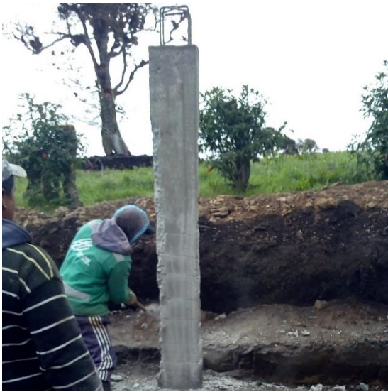
Imagen 62. Demolición columna.
