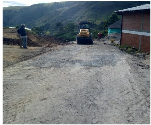
Imagen 25. Estado del terreno luego del compactado.
