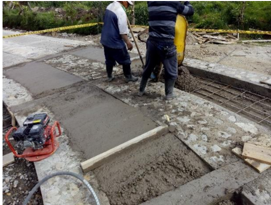
Imagen 35. Fundición de las huellas de la curva.
