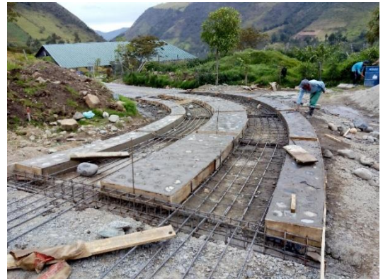
Imagen 34. Tramos de la curva terminados en piedra pegada.
