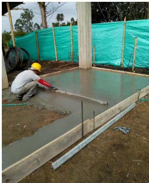
Imagen 83. Fundición placa piso primario.
