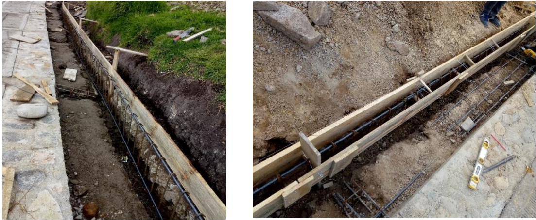
Imagen 38. Acero de refuerzo y formaleta del bordillo.
