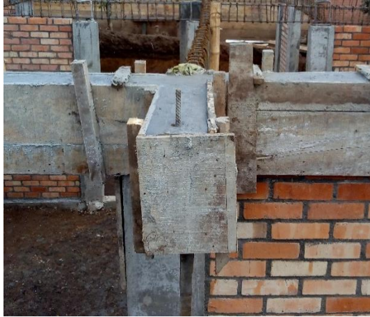
Imagen 69. Detalle proyección de pelos de acero.
