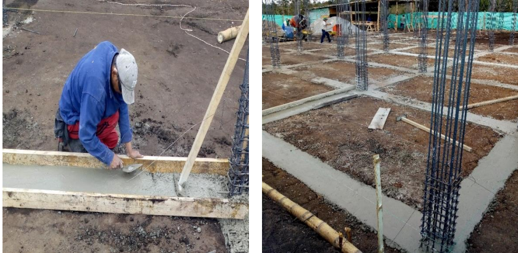
Imagen 76. Acabado de las vigas y fundición finalizada.
