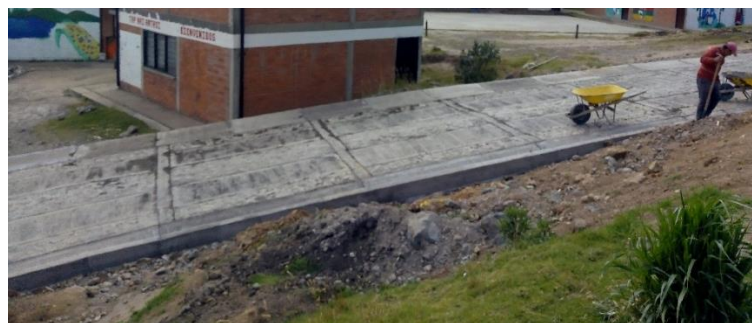
Imagen 52. Último tramo de la placa huella, terminado.
