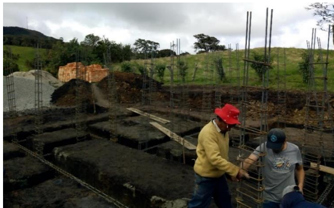
Imagen 56. Posicionamiento de castillos de refuerzo para columnas.
