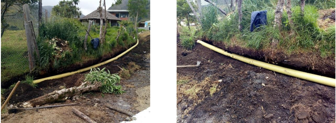
Imagen 19. Instalación tubería 6" final.
