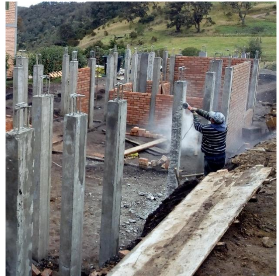
Imagen 62. Demolición columna.
