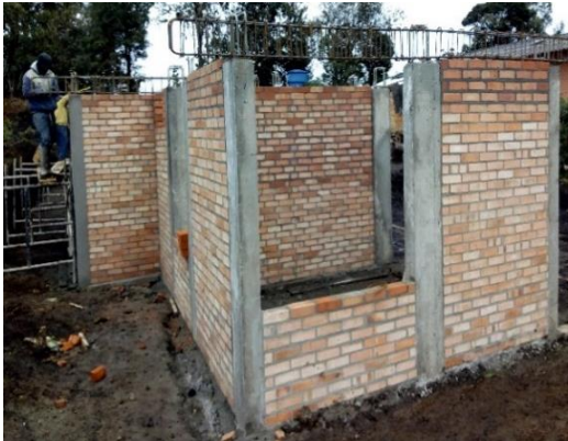
Imagen 65. Posicionamiento castillos de refuerzo vigas transversales.
