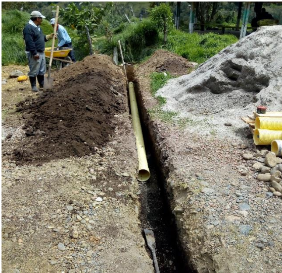
Imagen 18. Instalación tubería 6" y fundición de caja de inspección.
