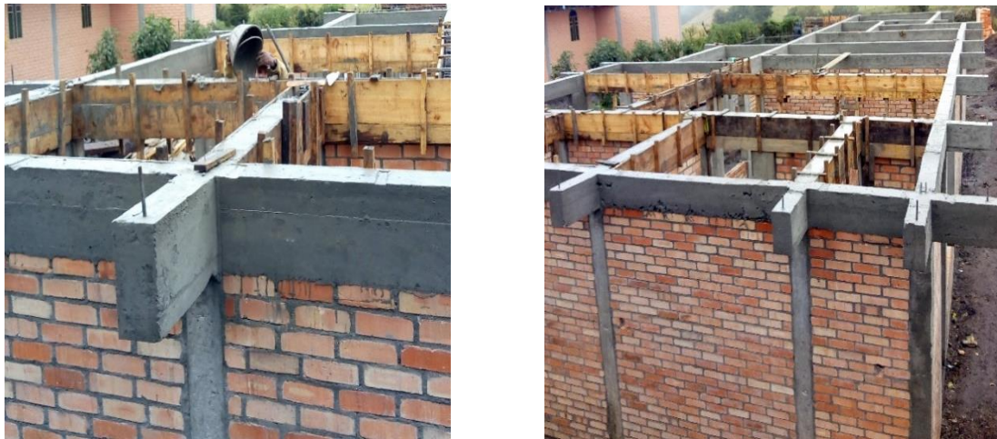
Imagen 70. Fundición vigas de cubierta zona de despensa.
