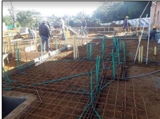
Se deja en la cimentación los hierros de arranque que van por las celdas verticales de los bloques estructurales (ver figura 8) denominados dovelas, así como también se debe garantizar que el acero no esté en contacto con el terreno haciendo uso de las famosas “panelitas” (comodín de concreto realizado en obra).
