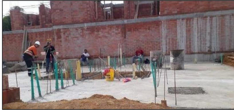
Se debe replantear el plano estructural en la losa (ver figura 43): esto corresponde a tener un hilo y agregarle mineral de color rojo para que se adhiera en la losa, esto lo realiza el maestro a cargo con un ayudante basándose en los puntos de los ejes previamente ubicados.
