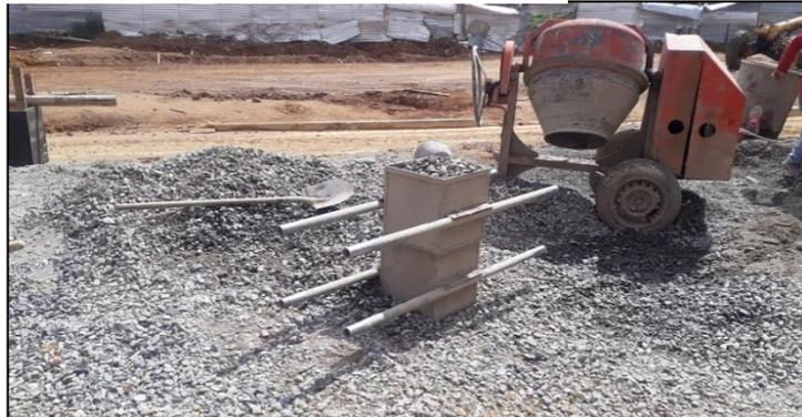
Para la grava de  $\frac{3}{4}$ " se realizó un control frecuente ya que llegaba de tamaño superior (Ver figura 29), lo que dificultaba la fundición de la viga de amarre porque al determinar el asentamiento del concreto (Slump) con un máximo de 6 pulgadas la mezcla quedaba poco manejable.
