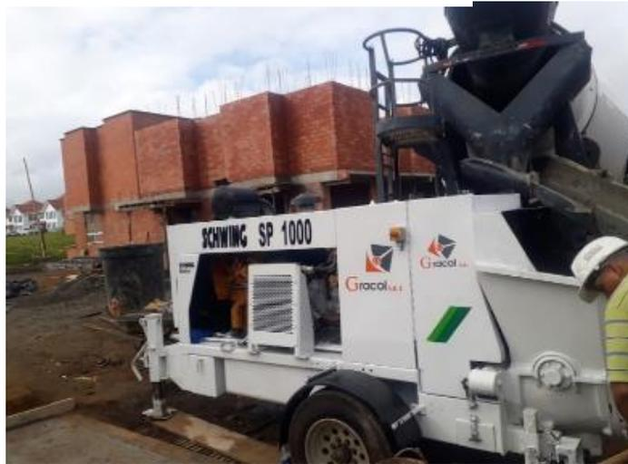
Se debe ubicar la línea de tubería sin afectar la estructura construida de la primera planta donde la tubería no se apoya de la pared si no que se le hace un apoyo extra con tablonos y guadas, en una fundición la tubería quedo apoyada de los muros del primer piso lo que desestabiliza la estructura (ver figura 62) por ende se suspendió la fundición hasta que se solvento ese inconveniente.
