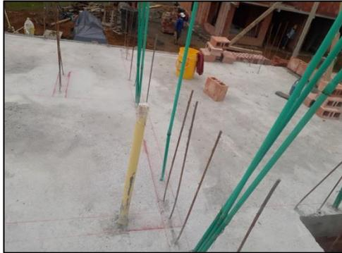
Nuevamente se procede a la fundición de dovelas en segundo piso; en cuanto los muros hayan secado de manera correcta para que la mezcla no afecte el muro (ver figura 67)
