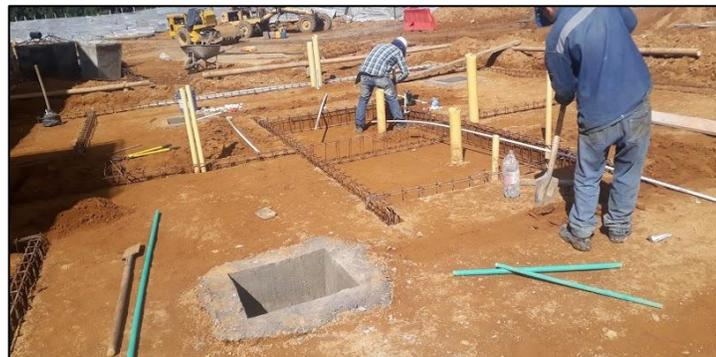
Lo restante en eje 2,3 y B se debe completar con refuerzo (ver figura 37) en donde el corte Z3 muestra que para el refuerzo se deben colocar 2 varillas #4.
