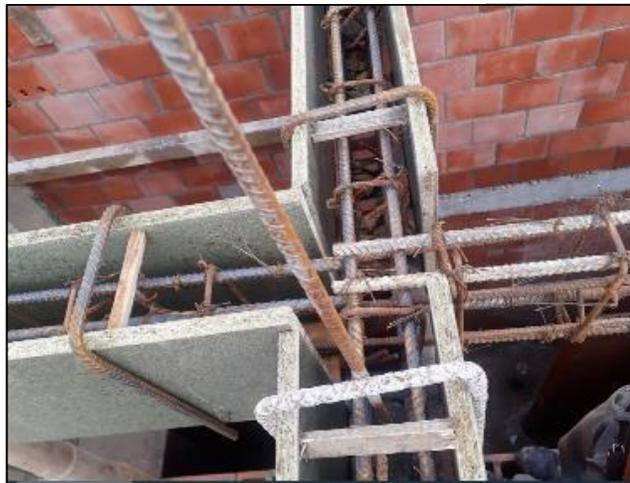
La formaleta de la viga debe quedar bien asegurada ya que al fundir se debe vibrar la mezcla o caso posterior después de que la viga fragüe los esfuerzos que el concreto ejerce sobre la formaleta pueden ser fuertes generando fisuras en la formaleta y que la viga no quede simétrica. El contratista debe resanar la viga ya que la actividad realizada debe quedar bien ejecutada y si es el caso detallada (ver figura 70).
