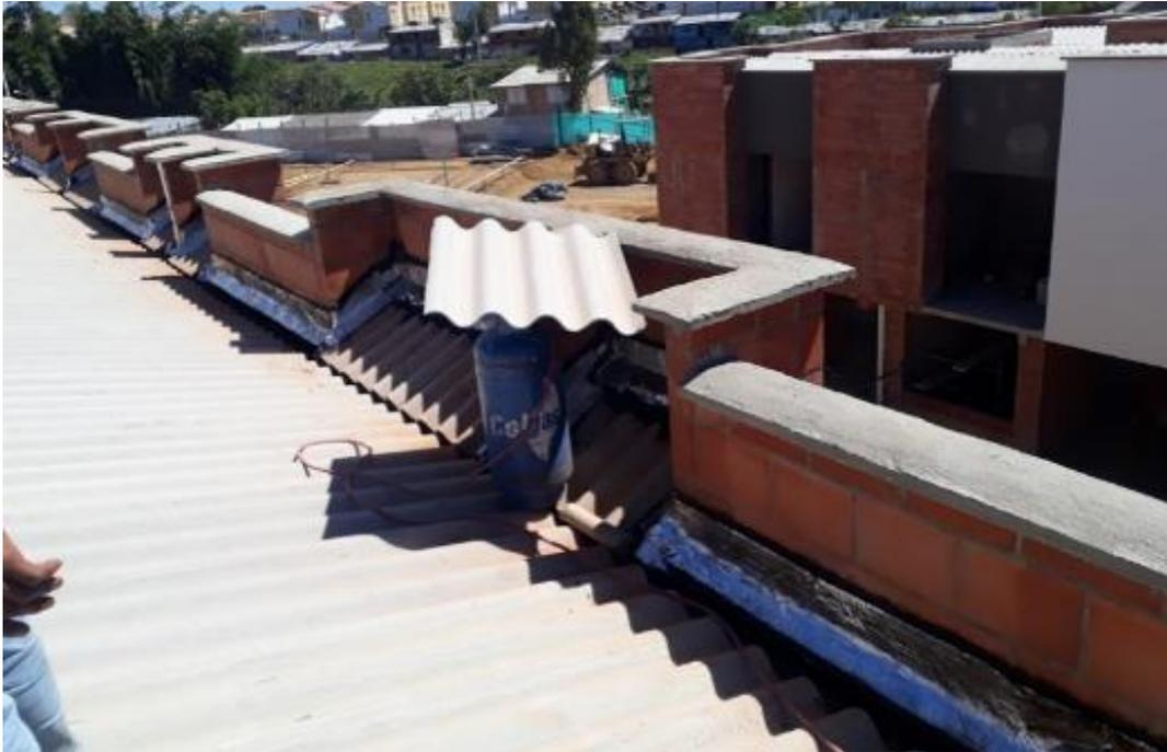
alguna ocasión se pudo observar que la terminación de la culata estaba desfasada, es decir que había quedado salida por lo que al ubicar las tejas se tuvo que cortar la parte inferior de la culata( ver figura 83). Se informo inmediatamente al maestro encargado para que arregle esa parte.
