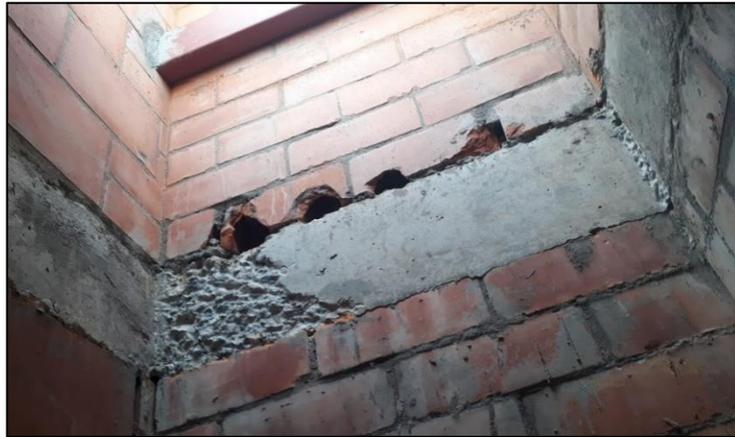
De la planta de segundo piso se deja la continuación de dovelas para la estructura de la culata (ver figura 71).
