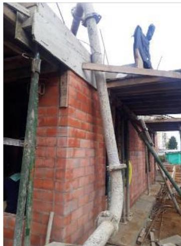
Al igual que la losa de cimentación se ubican los niveles para tener de referencia del espesor haciendo uso de las dovelas existentes de la primera planta, el uso de codal es indispensable y es de gran importancia el vibrado de la losa sobre todo en las vigas.
