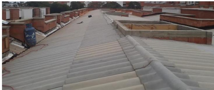
La manera más factible para realizar esta actividad es que conforme se avanza en la ubicación de la teja ondulada se debe caminar sobre un tablón apoyado sobre 2 ondas de teja como mínimo con el fin de no fracturar la hoja de zinc y evitar percances en la obra.
