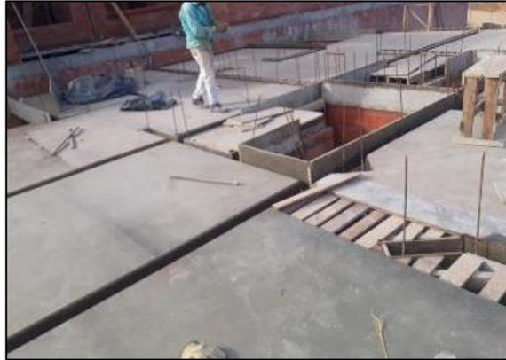
En el plano de la losa de entrepiso se observa la ubicación de vigas de entrepiso, refuerzo y la malla electrosoldada, es de mencionar que los refuerzos estructurales deben estar ubicados de forma tal que queden previamente embebidos en la losa ya que esta tiene un espesor de 10 cm.
