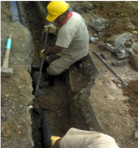
Foto # 3 Excavación para acueducto
