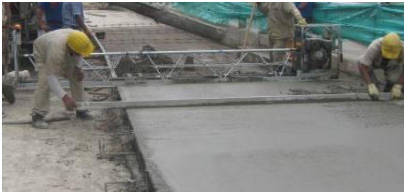
Foto #49 Nivelación del concreto con codal
