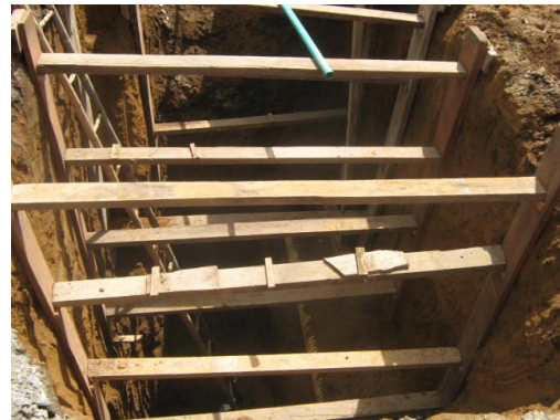
Foto #2 Excavación y entibamiento para alcantarillado entre Calle 4 y 5
