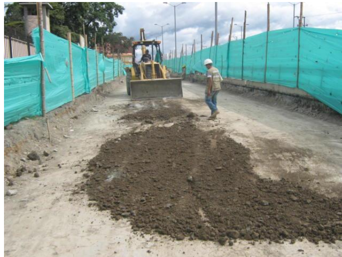
Foto # 15 Corrección de fallo en subrasante
