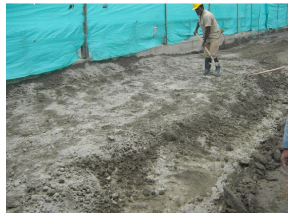
Foto #20 Estabilización del suelo
