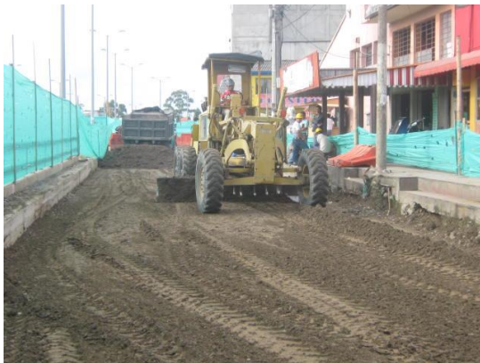
Foto # 8 Extendido de material de mejoramiento en Kikos
