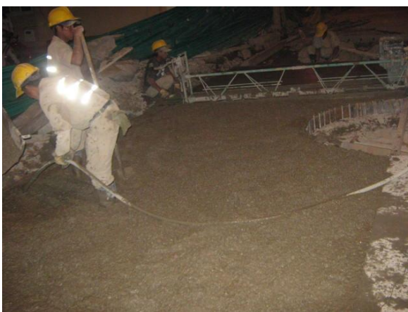
Foto #46 Vibración con Aguja
