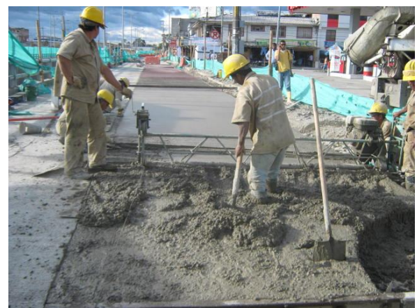
Foto #47 Vibración con aguja y regla
