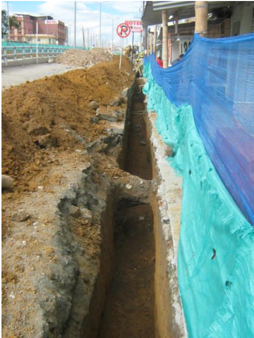
Foto # 5 Excavación para cambio de acueducto
