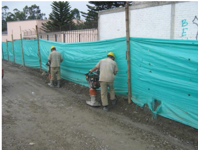
Foto # 24 Compactación de bordes
