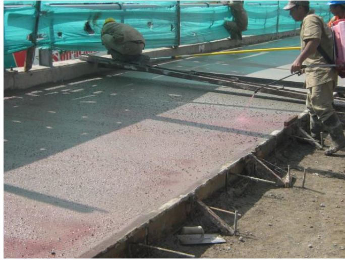
Foto #55 Aplicación de ANTISOL
