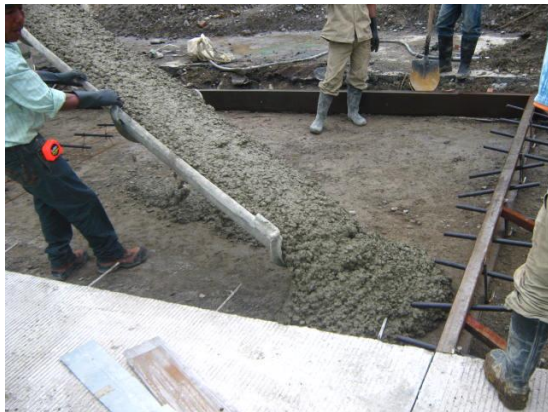
Foto #38 Vaciado de concreto
