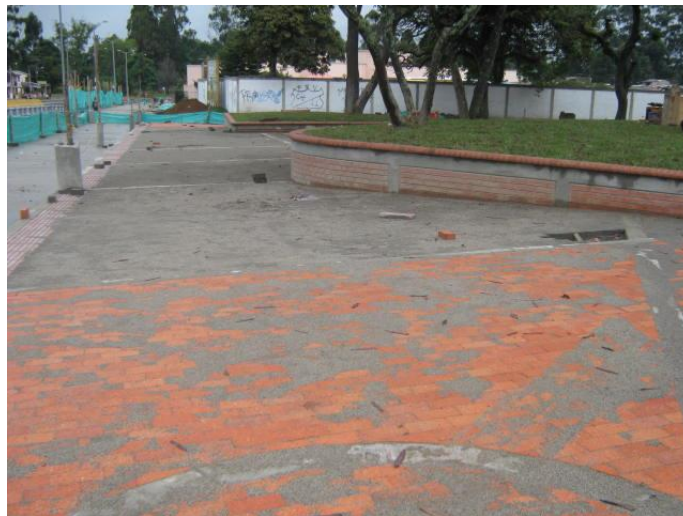
Foto #60 Adoquín de arcilla con arena zarandeada
