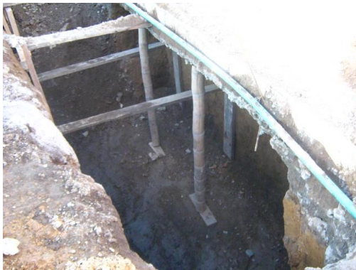
Foto #1 Excavación y entibamiento para alcantarillado en Calle 4
