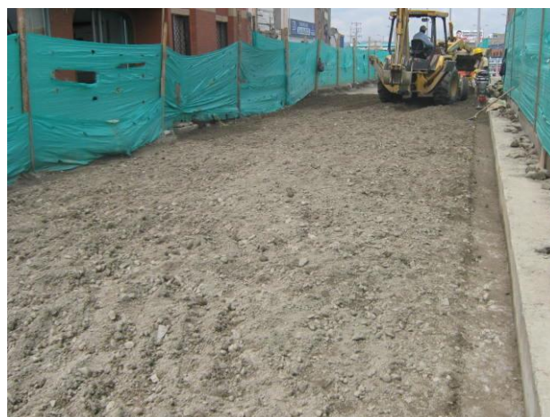
Foto # 7 extendido de material de mejoramiento en Hotel panorama
