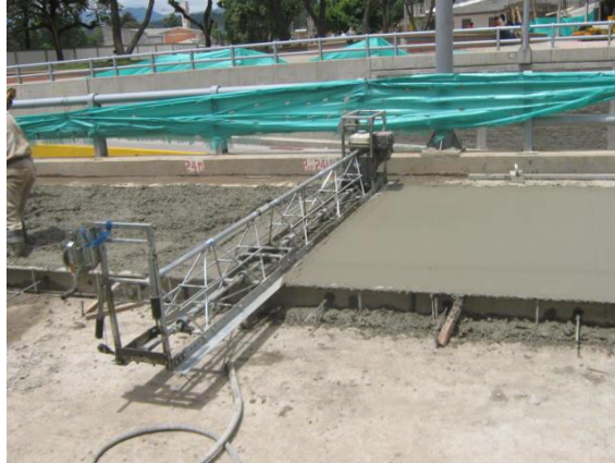
Foto #48 Regla vibratoria usada
