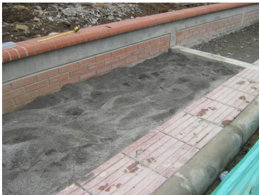
Foto# 65 loseta guiadora instalada
