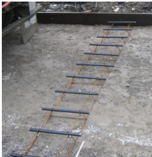
Foto #37 Canastilla engrasada y anclada
