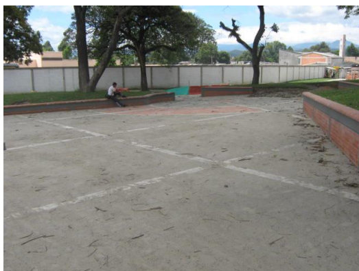
Foto #63 Adoquín instalado en parque cadillal
