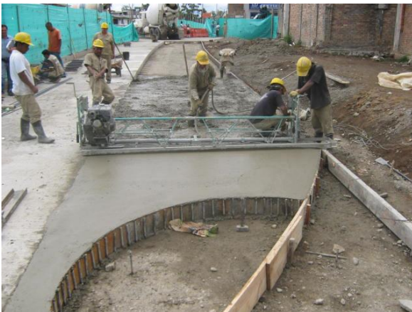
Foto #44 vibración del concreto
