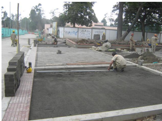
Foto# 61 Preparación de la superficie de apoyo para el adoquín
