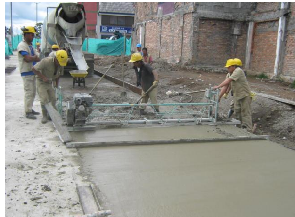
Foto #45 vibración del concreto
