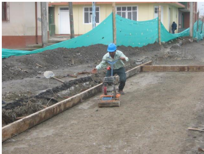
Foto # 23 Compactación en bordes
