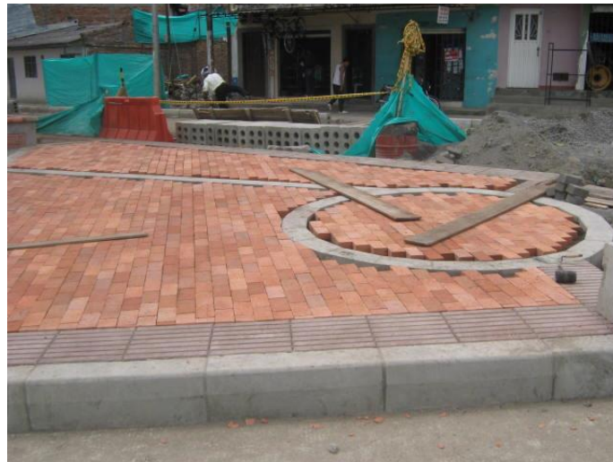
Foto #59 Adoquín de arcilla instalado
