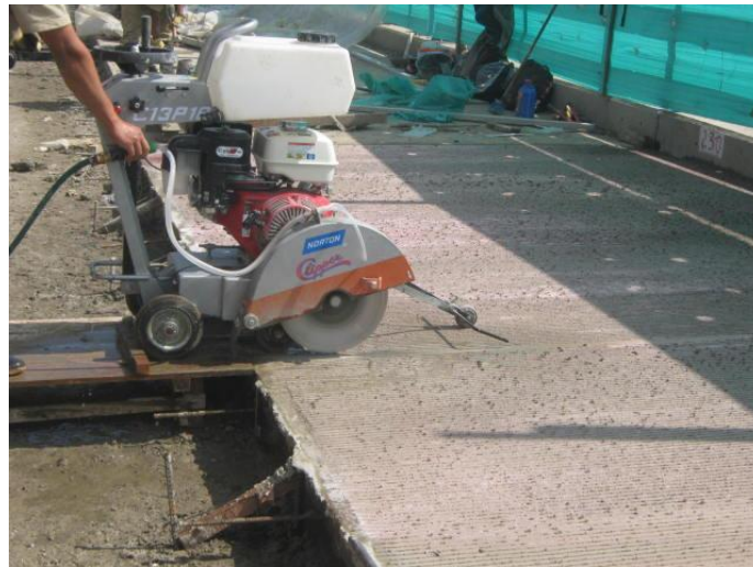
Foto #56 Corte de juntas
