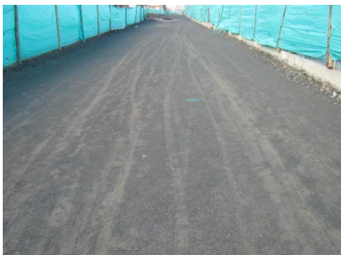
Foto #58 Cerramiento provisional
