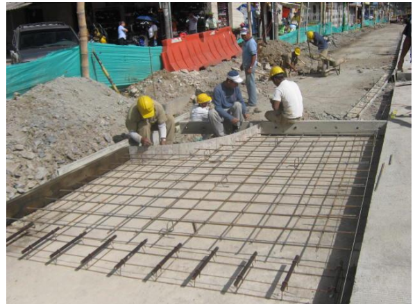
Foto # 32 Colocación de formaleta
