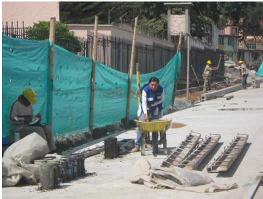
Foto #42 Toma de cilindros
