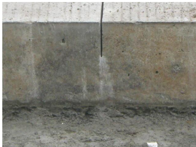
Foto #57 Corte de la losa
