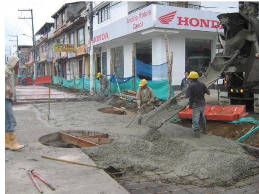
Foto #43 Vaciado y extendido de concreto
