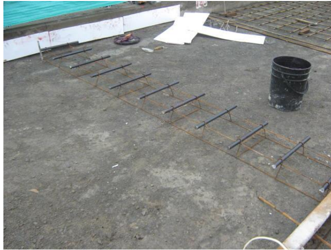
Foto # 30 Canastilla utilizada en obra
