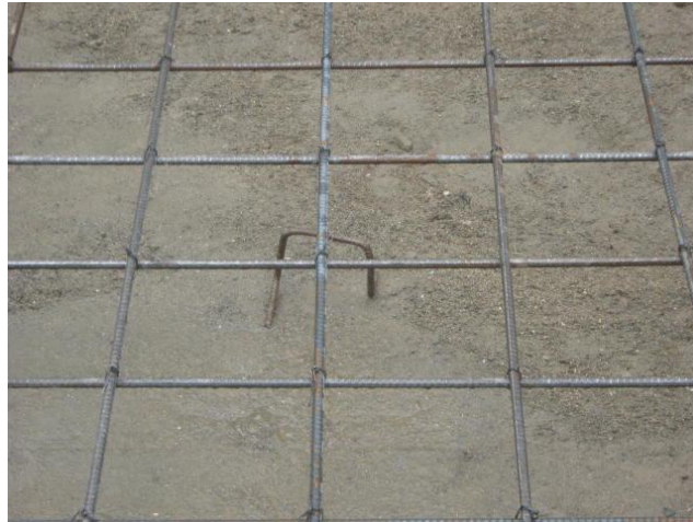
Foto #34 Correcta colocación de parrilla
