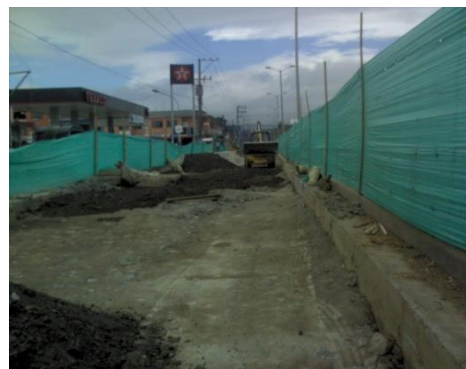
Foto #59 Cerramiento provisional
