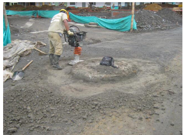
Foto # 28 Compactación en zonas de difícil acceso
