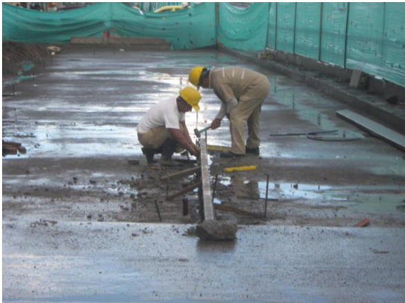
Foto # 31 Colocación de formaleta
