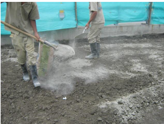
Foto #12 estabilización con cemento
