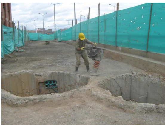
Foto # 27 Compactación en zonas difícil acceso
