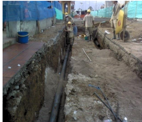
Foto #4 Excavación para acueducto
