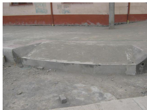
Foto #64 Adoquín usado para rampa peatonal
