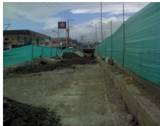
Foto #11 Compactación del material
