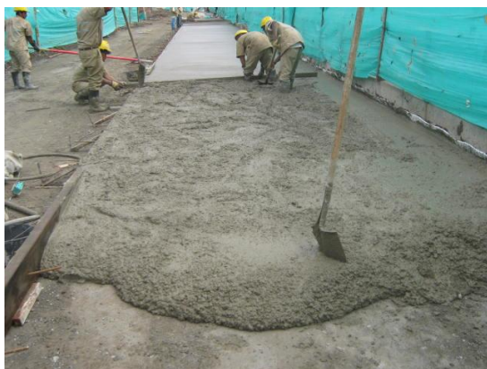
Foto #40 Extendido del concreto
