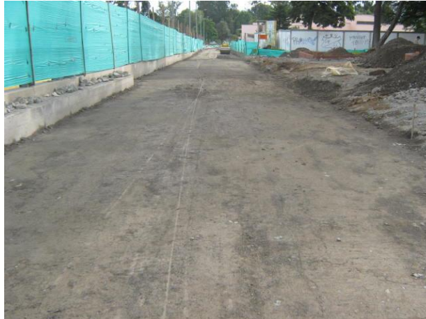
Foto #14 Tramo terminado con material de mejoramiento
