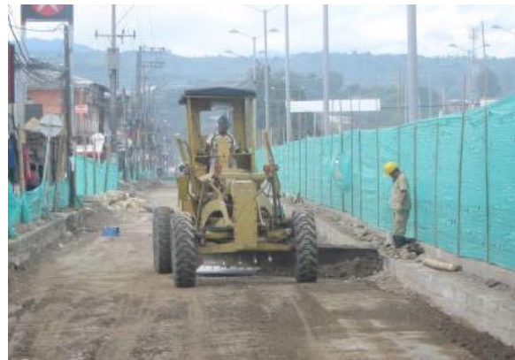
Foto # 9 Extendido de material de bomba Texaco
