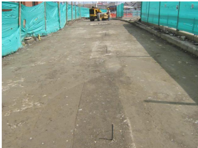
Foto # 25 Capa sereada para extensión de subbase
