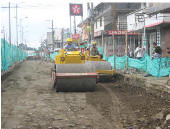
Foto #10 Compactación del material
