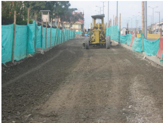
Foto # 26 Conformación de subbase
