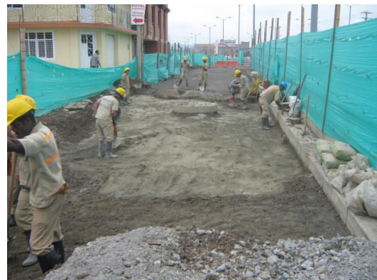
Foto #13 Estabilización con cemento
