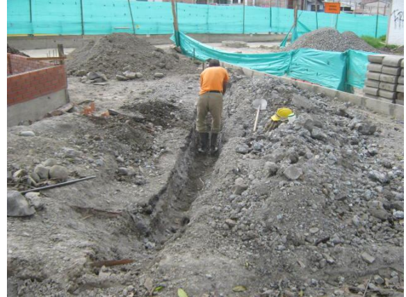
Foto #6 Excavación manual
