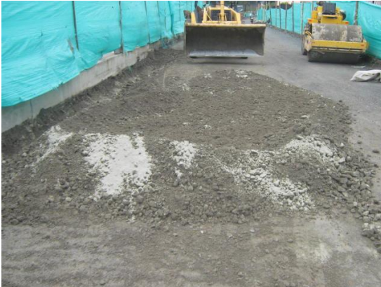
Foto #21 arreglo de un fallo
