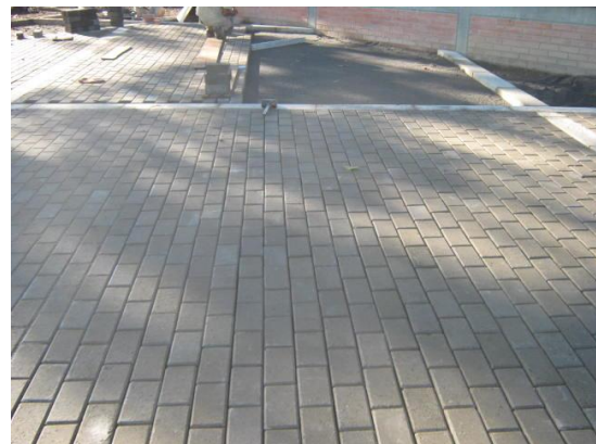
Foto #62 Adoquín instalado
