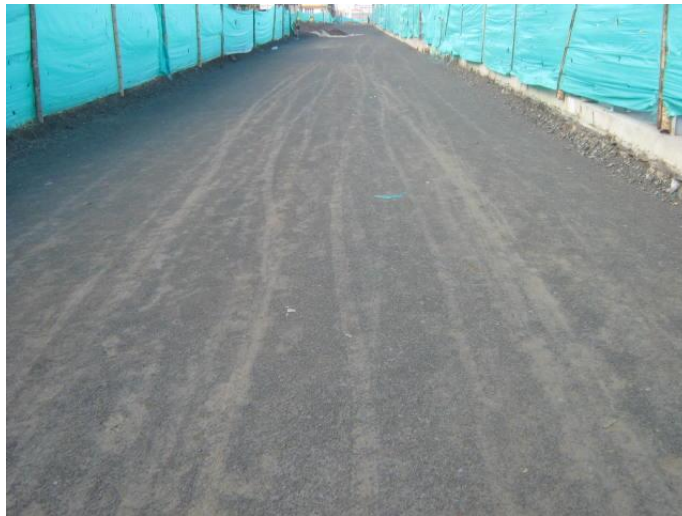
Foto #29 Capa de Subbase terminada
