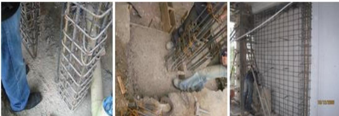
**Fig.42 Cimentación y anclaje de las columnas**
