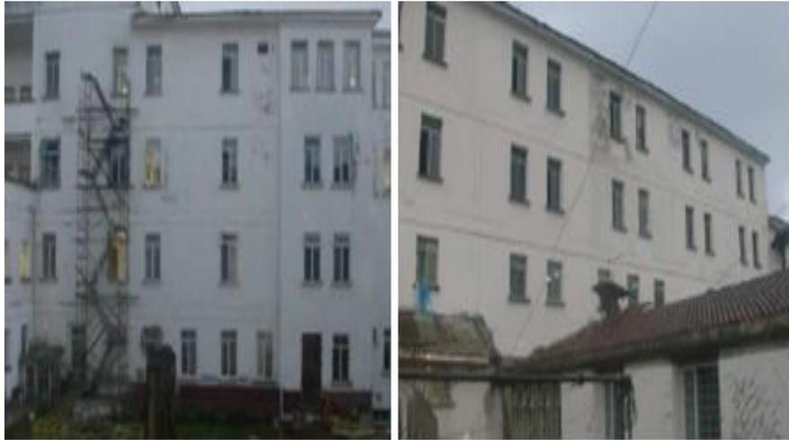
El sector 9 del hospital san José de Popayán es un edificio de 4 pisos el cual tiene como sistema estructural pórticos de concreto reforzado, este se reforzó por medio de pantallas estructurales de concreto reforzado y cimentadas sobre unos pilotes de concreto reforzado con una profundidad de 7.0 m de profundidad y 0.4m de diámetro, conectados a la zapata por medio de un dado de cimentación en concreto reforzado.
