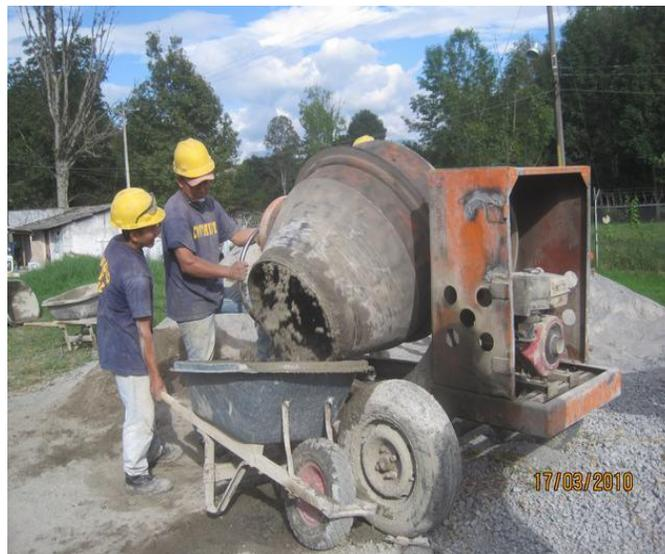
**Fig. 66 Método de transporte del concreto**
