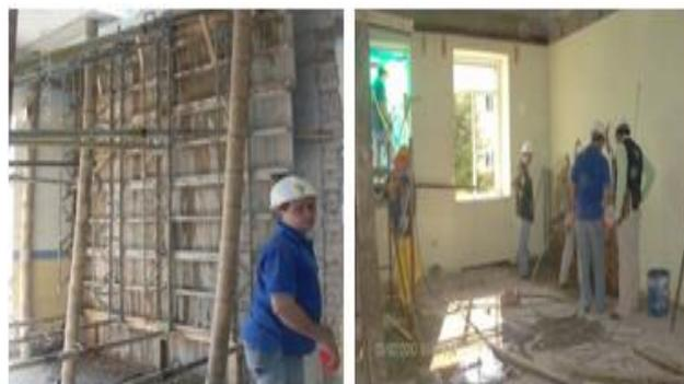
**Fig.20 Formaleta y fundición de las pantallas**
