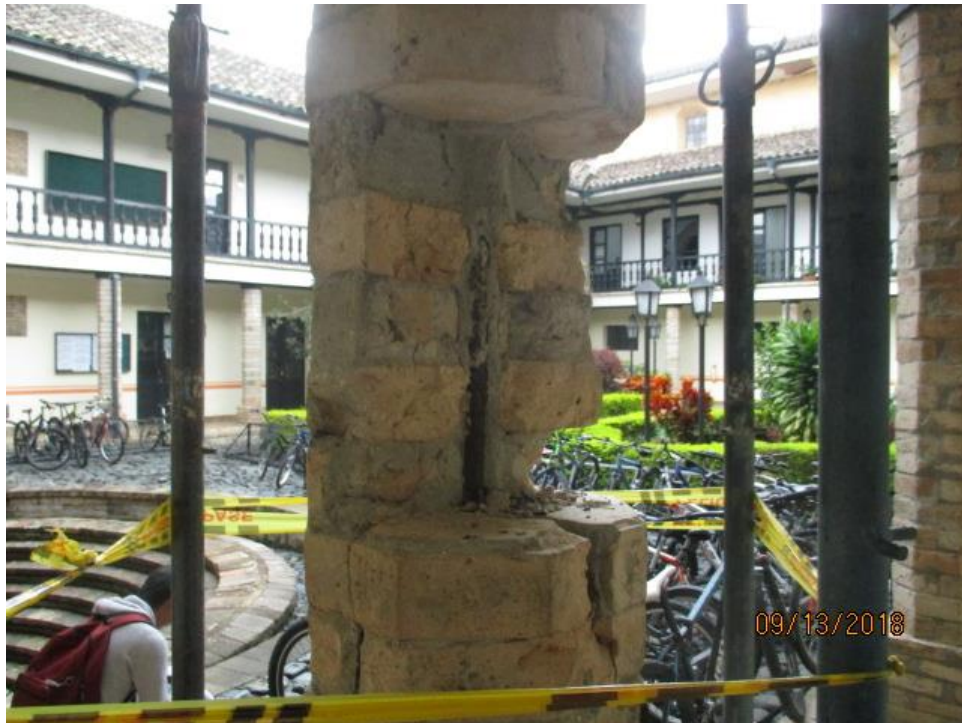
Figura 32 Interior de las columnas
