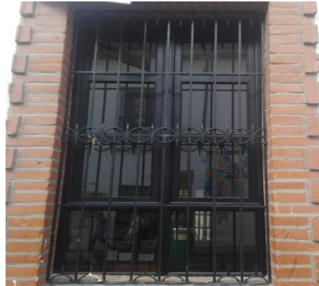
Figura 34 Ventanas instaladas en el edificio el Carmen
