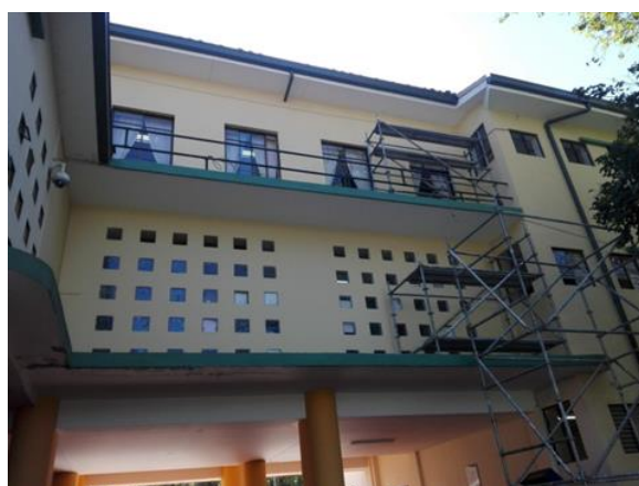
Figura 28 Pintura en la fachada de Educación con andamios certificados
