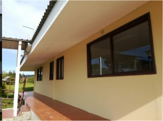
Figura 57 Fachada edificio de Oficinas
