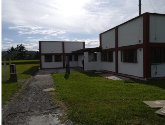
Figura 56 Fachada Planta piloto
