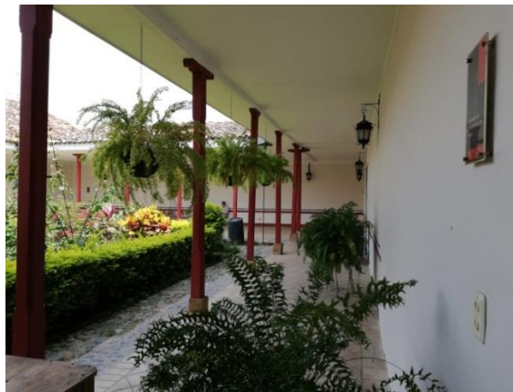
Figura 58 Pasillos de la Casona terminados
