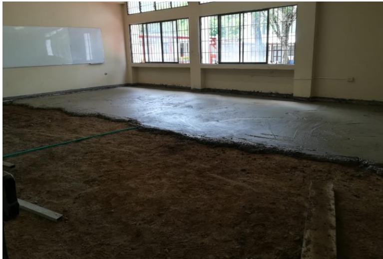
Figura 17 Piso primario fundido en el salón 329
