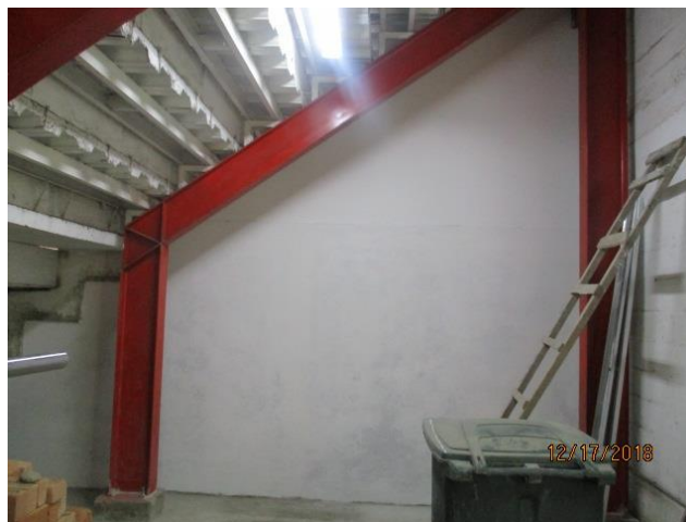
Figura 36 Muro divisorio terminado
