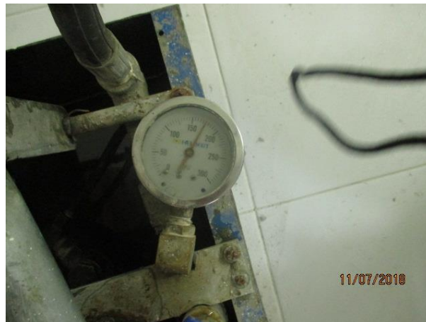
Figura 40 Equipo utilizado para la Prueba hidráulica
