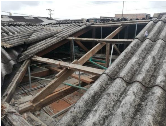
Figura 44 Estructura y cubierta antes de la intervención
