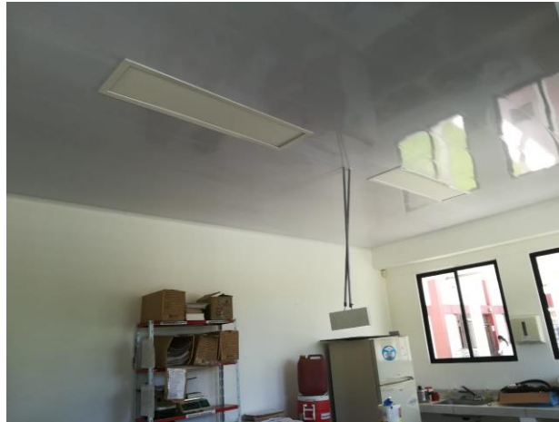
Figura 24 Laboratorio de agroquímica terminado
