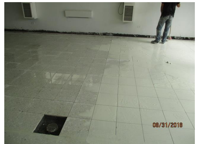
Figura 4 Proceso de fraguado con cemento blanco
