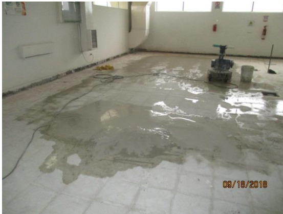
Figura 5 Proceso de pulimiento del piso instalado
