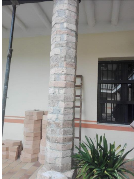
Figura 31 Columnas existentes en el edificio del Carmen
