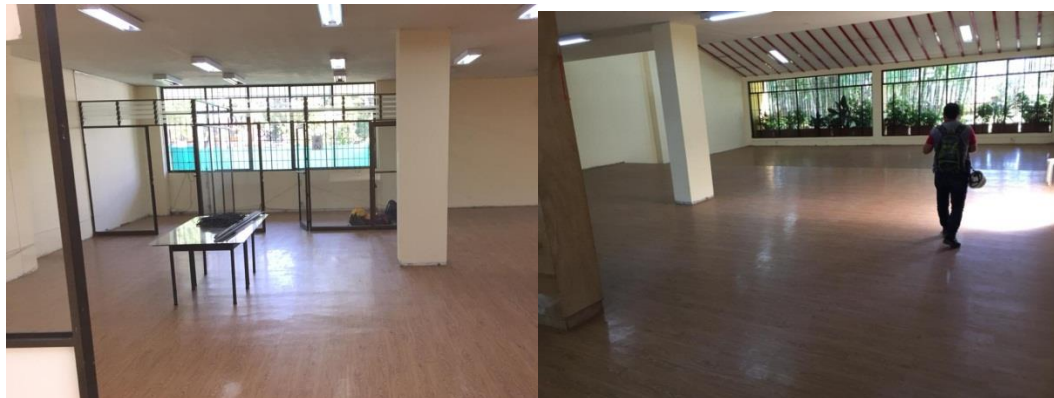
Figura 23 Piso de la biblioteca terminado
