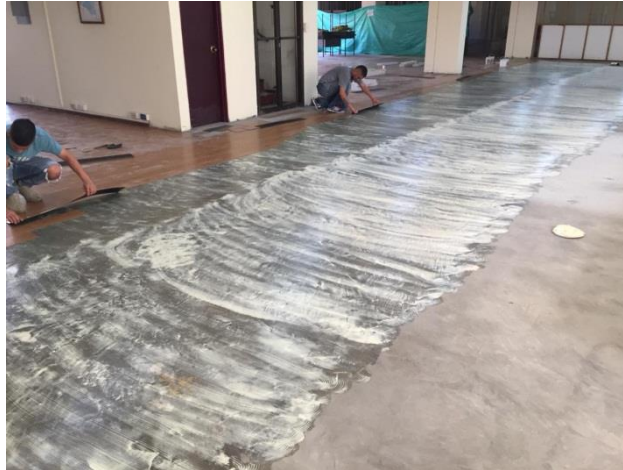
Figura 22 Instalación de piso en vinilo
