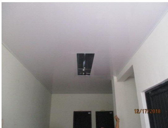
Figura 35 Cielo falso en PVC área administrativa CDU
