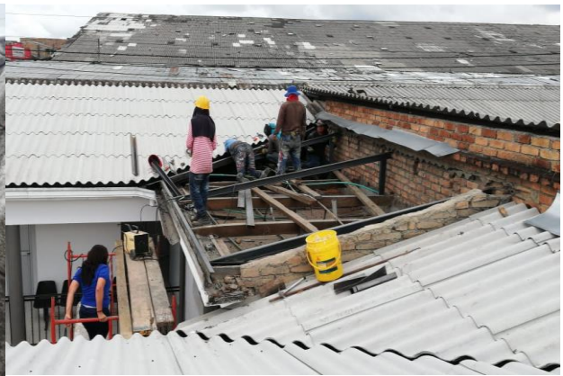
Figura 45 Instalación de perlines y tejas
