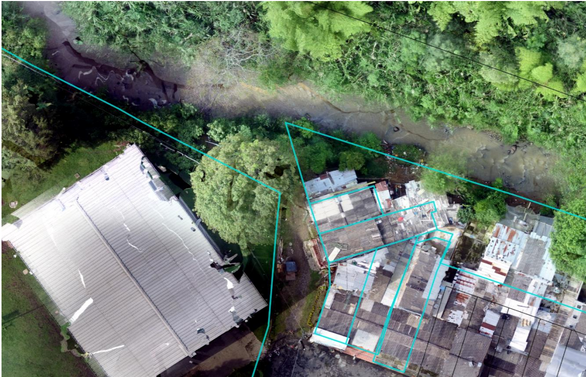
Ilustración 66. Vista aérea de la vivienda
