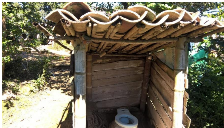
Ilustración 50. Fotografía de visitas para el proyecto de batería sanitarias
