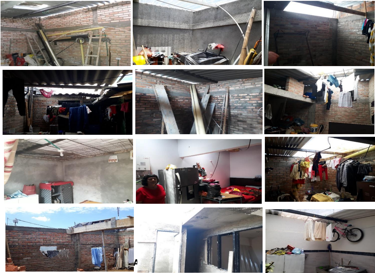
Ilustración 1. Visita de verificación de construcción de muros
