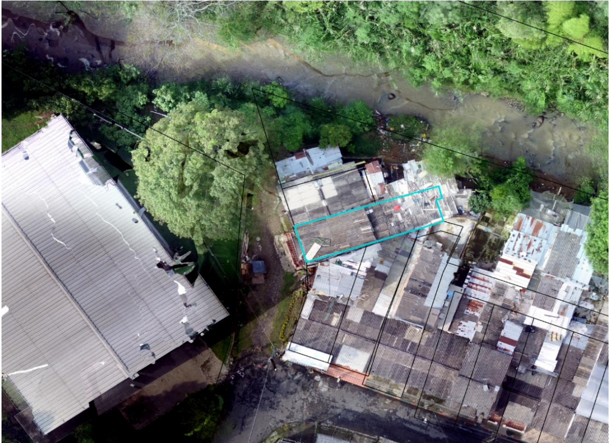
Ilustración 65. Vista aérea de la vivienda
