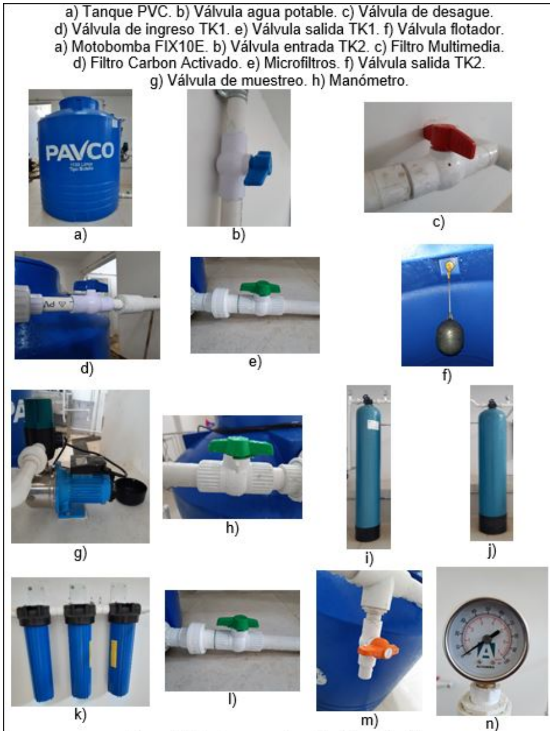
Figura 3.7: Equipos parciales unidad de purificación. Fuente: Acueducto y Alcantarillado de Popayán S.A. E.S.P.
