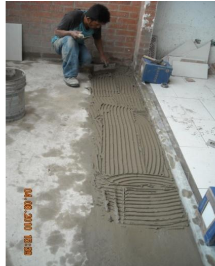
Fig.10. Extendido de mezcla con llana dentada
