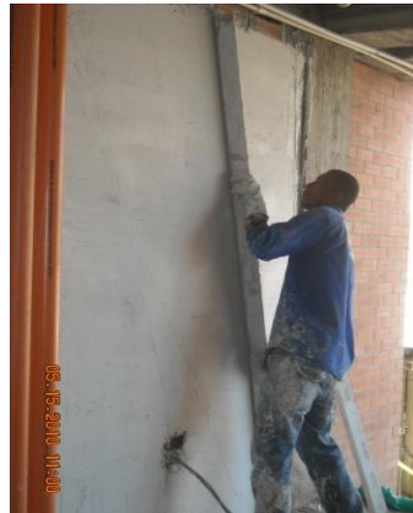
Fig.8.Distribución horizontal del estuco con codal.
