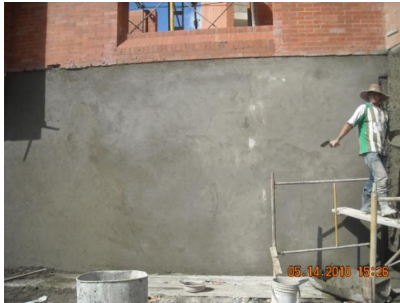
Fig.20. Pantalla repellada con mortero tradicional.
