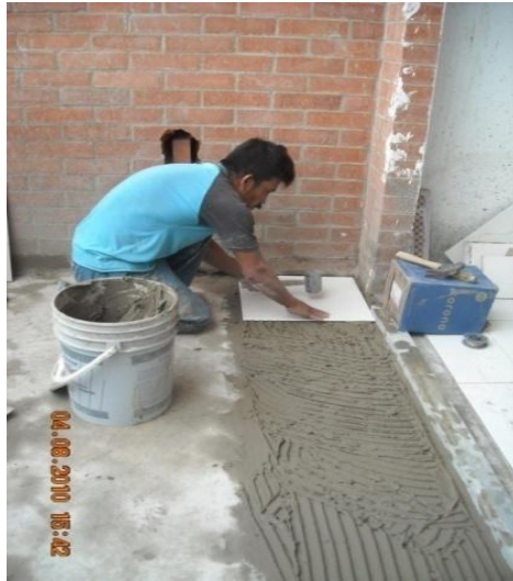
Fig.11. Colocación de pieza de cerámica.
