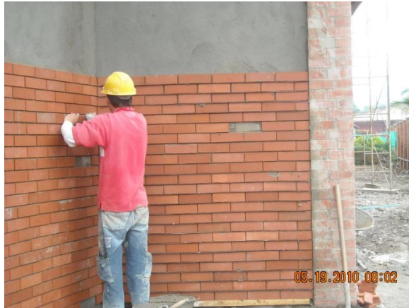
Fig. 29. Instalación de fachaleta con pegante para cerámica.
