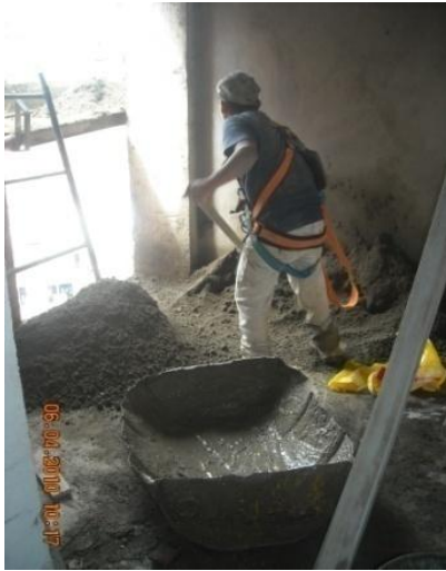
Fig.21. Preparación de mortero.
