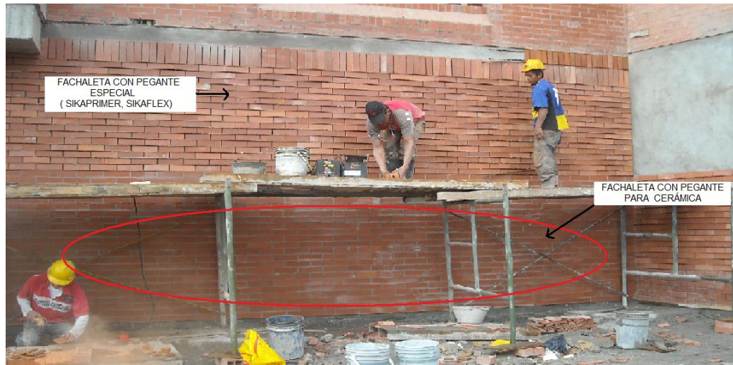
Fig. 30. Fachaleta con pegante para cerámica y Fachaleta con pegante especial.
