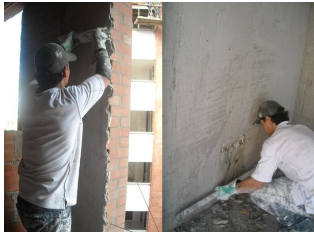
Fig. 6. Redefiniendo el relleno con codal sobre el muro.
