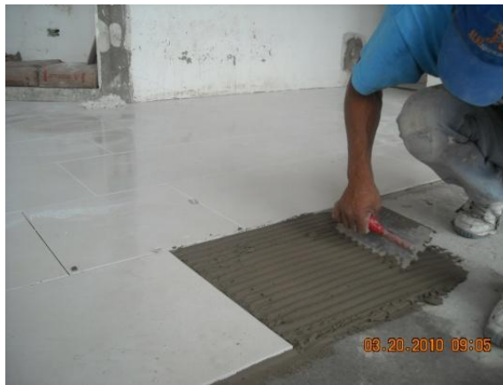
Fig. 13. Colocación de mezcla para enchapar con cerámica.
