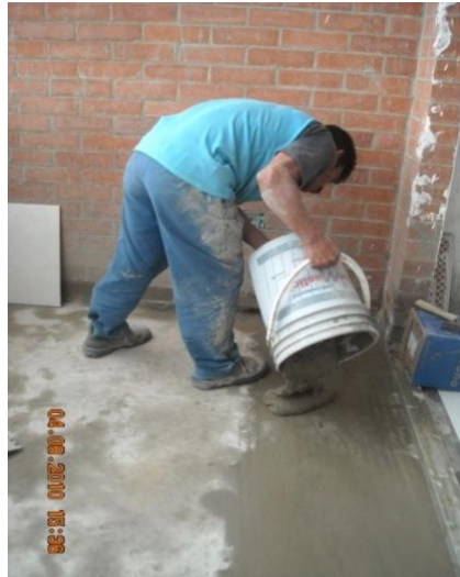
Fig.9. Colocación de mezcla para encajpe.
