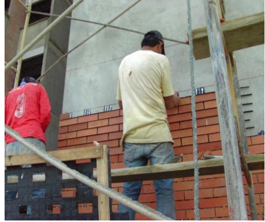
Fig. 24. Instalación de fachaleta.
