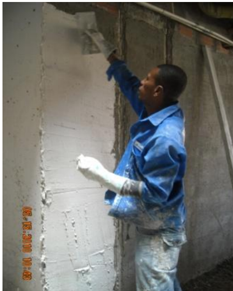
Fig.7.Colocación del estuco sobre el muro con llana.
