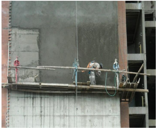
Fig.22. Colocación de mortero sobre pantalla en alturas.
