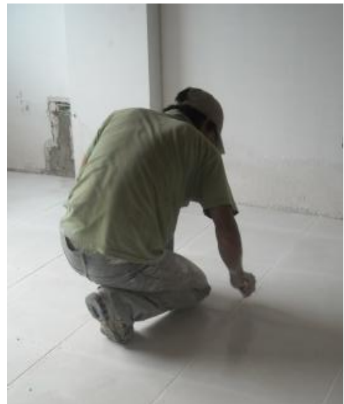
Fig. 17. Ajuste de boquilla
