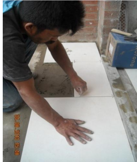
Fig.12. Colocación de dilatación plástica.
