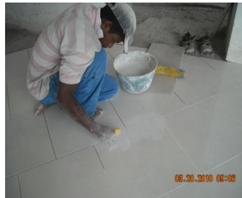
Fig. 15. Emboquillada.
