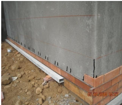
Fig. 27. Colocación de fachaleta.
