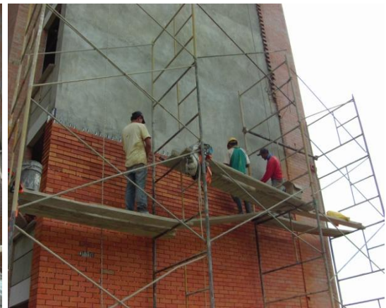
Fig. 26. Trabajo de fachaleta en altura.
