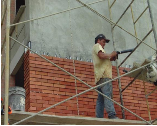
Fig. 23. Colocación de Sikaflex en aplicador.
