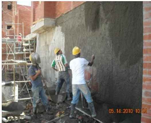
Fig.18. Colocación de mortero en la pantalla. Fig.19. Acabado para el repello de pantalla.
