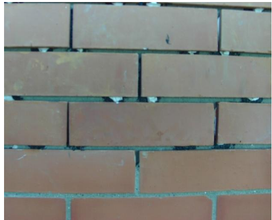
Fig. 28. Fachaleta instalada con y sin revoque.
