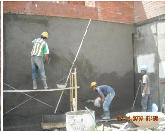
Fig.18. Colocación de mortero en la pantalla. Fig.19. Acabado para el repello de pantalla.
