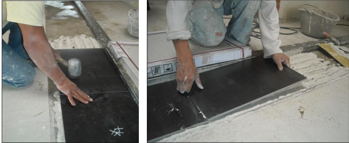
Fig. 34. Colocación y asentada de cerámica
