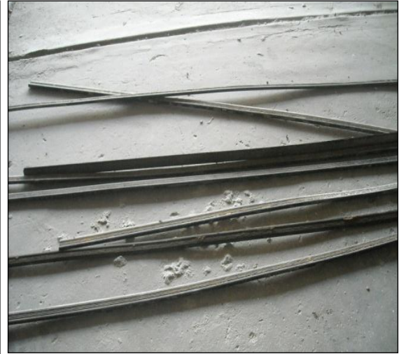
Fig.47. Dilataciones de caucho.
