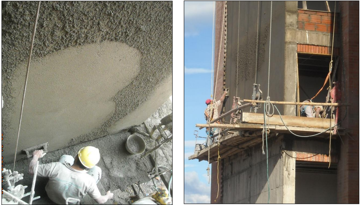
Fig. 37. Afinado del repello con llana de madera.
