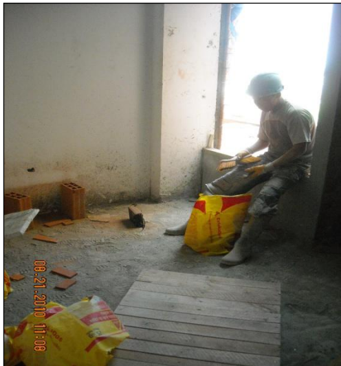
Fig. 44. Limpieza de fachaleta con escoba.
