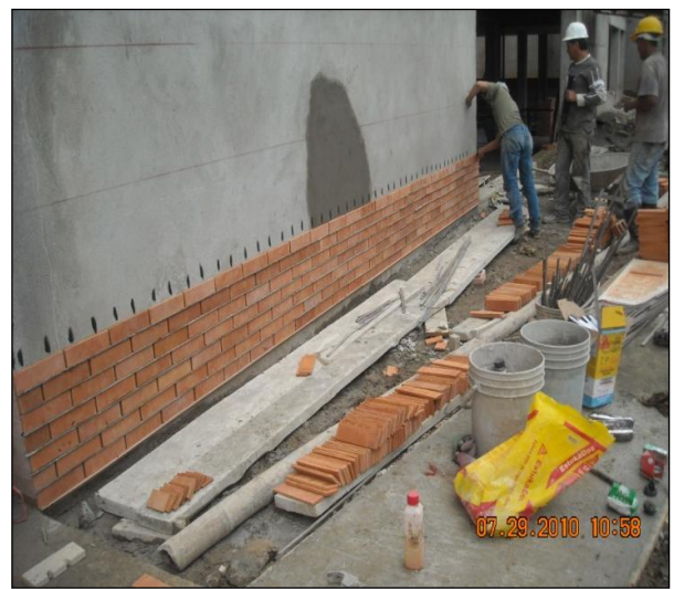
Fig. 45. Instalación de fachaleta.
