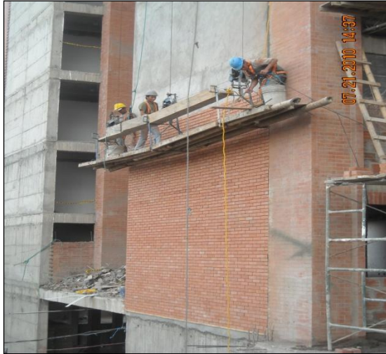
Fig. 46. Instalación de fachaleta utilizando andamio colgante.
