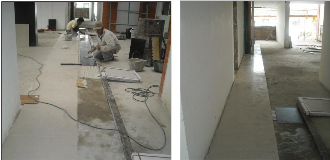
Fig. 33. Trazado de enchape.
