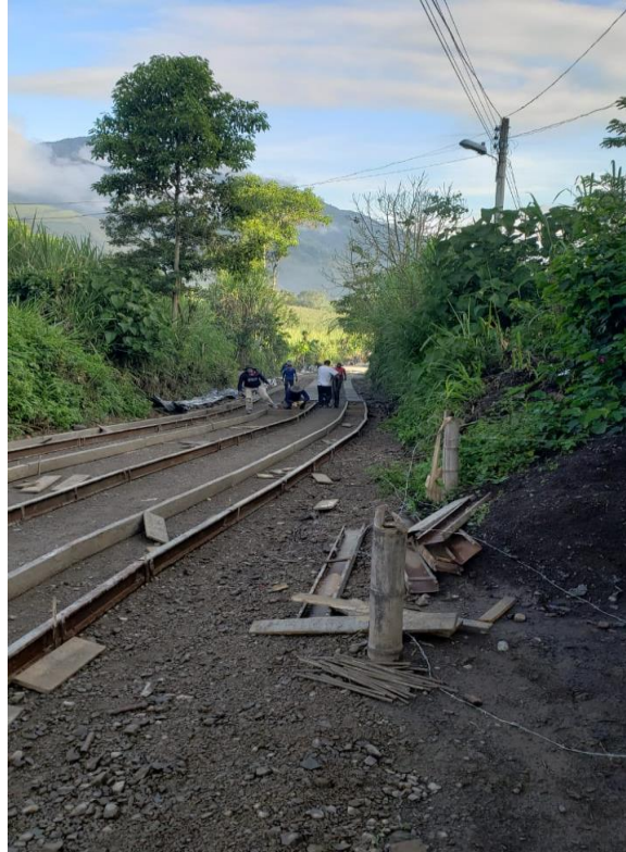
Figura 7.1 Formaleta para concreto ciclópeo
