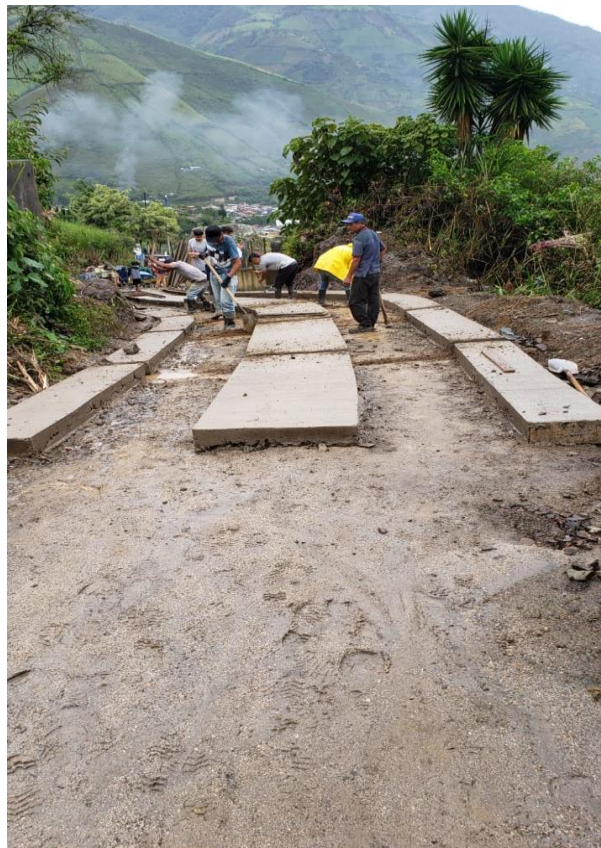
Figura 7.3 Excavación de riostras y solado
