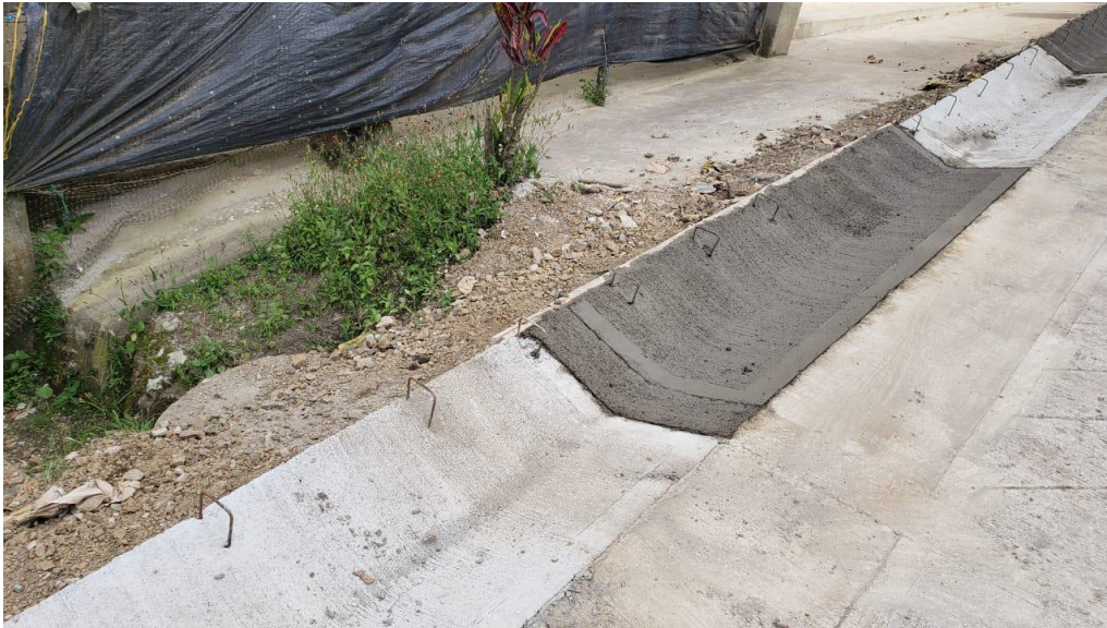
Figura 7.11 Acabado de cunetas
