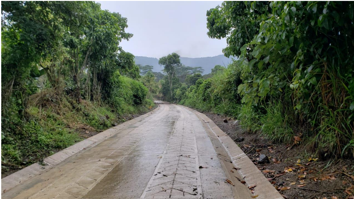
Figura 7.13 Obra finalizada Vereda san francisco
