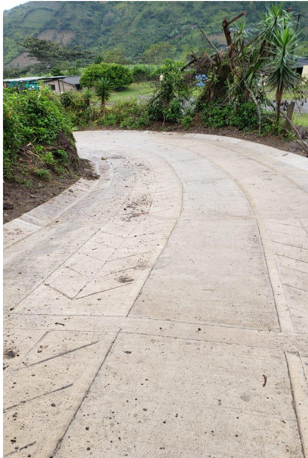
Figura 7.12 Obra finalizada Vereda sanfrancisco sector el altillo
