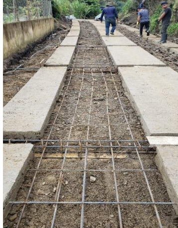
Figura 7.5 Mallas sobre panelas de concreto
