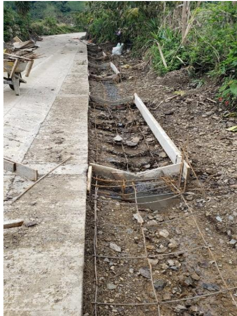
Figura 7.9 Acero de refuerzo de cuneta
