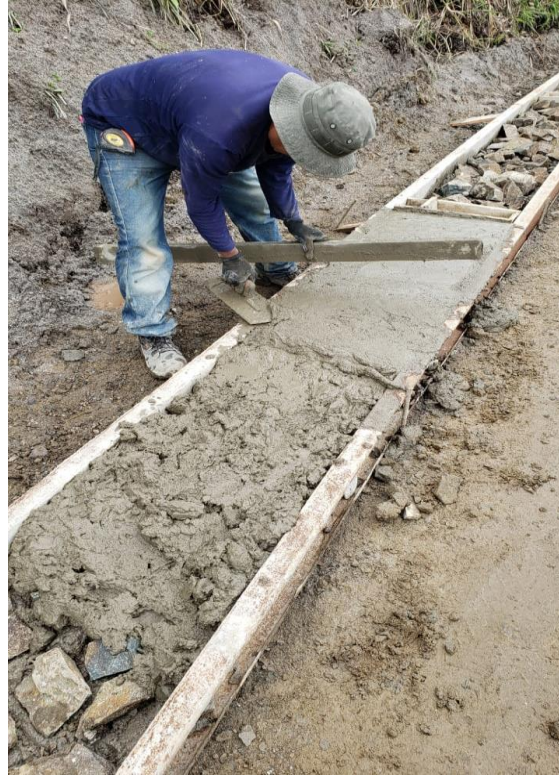
Figura 7.2 Fundición de piedra o concreto ciclópeo
