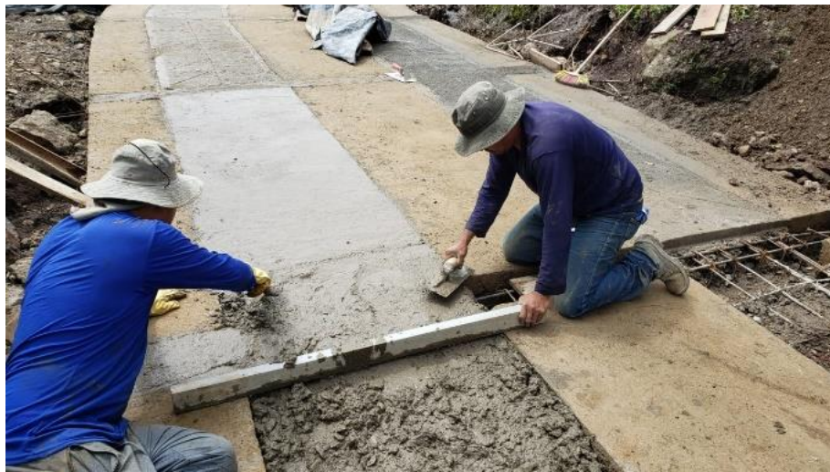
Figura 7.6 Fundición de placa
