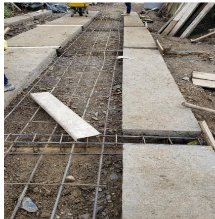
Figura 7.4 Mallas extendidas para placa
