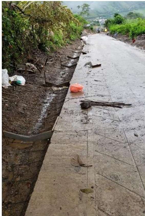
Figura 7.8 Instalación formaleta de cuneta
