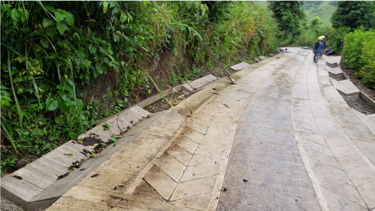
Figura 7.10 Fundición de cunetas
