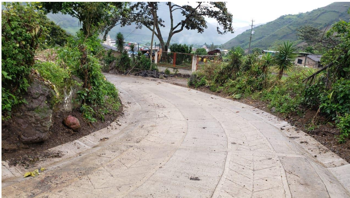
Figura 7.14 Obra finalizada Vereda san francisco sector trapiche asopal
