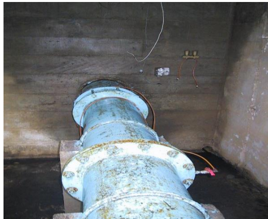
Figura 18: Transmisor de caudal por diferencial de presión
