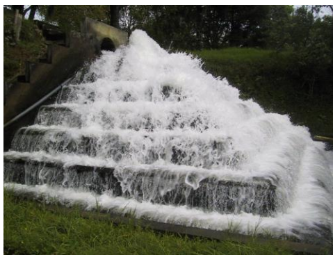
Figura 3: Oxigenación del agua cruda en la planta de tratamiento de El Tablazo.
