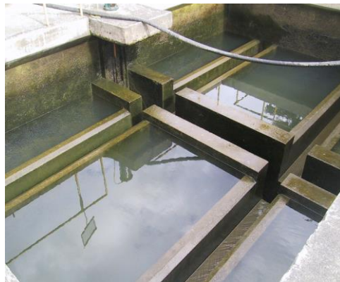
Figura 11: Foto de un filtro de arena y grava.
