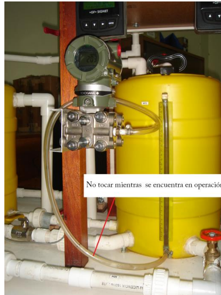
Figura 18: Conexión transmisor de nivel
