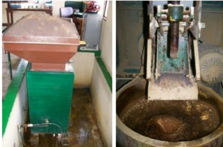
Figura 20. Máquina dosificadora de Sulfato de Aluminio.
