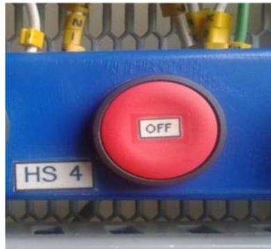
**Figura 4.12** Pulsador HS4, Apaga el ventilador de la planta.
