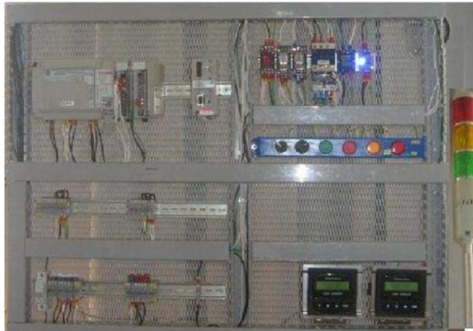
**Figura 2.2** Panel de control planta de temperatura (Laboratorio, 2010).
