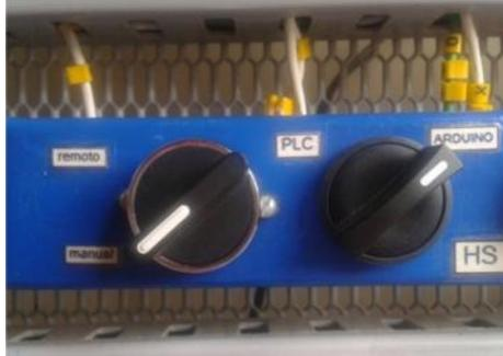
**Figura 4.5** Posición de las perillas para el encendido de la planta.
