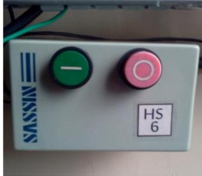
**Figura 4.11** Interruptor para el encendido y apagado de las resistencias.
