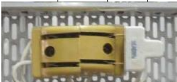
Figura C.5. Cuchilla de mando del compresor en la planta de presión del LCP.
