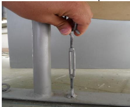
Figura E.6 Forma de sostener el tenor para tensionar la guaya
