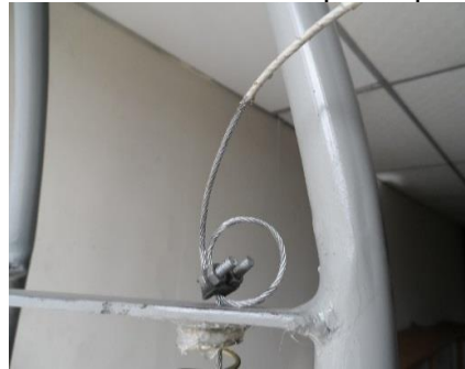
Figura E.5 Circunferencia del extremo superior para asegurar la guaya
