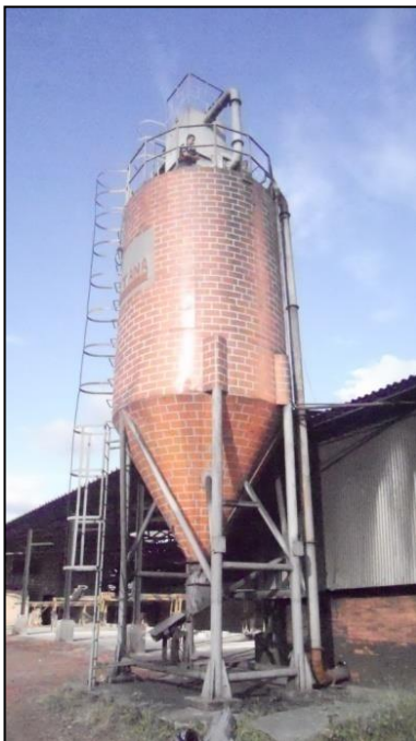
a) Estructura Silo
