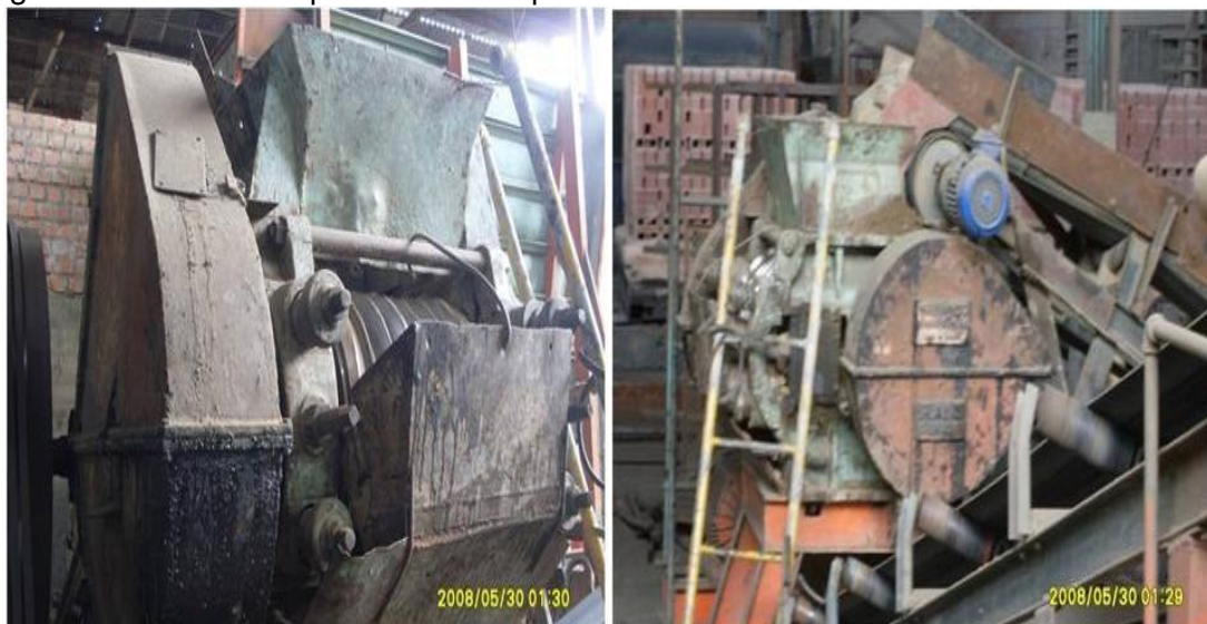
Figura 1.6. Molino rompe-terrones en planta 1.
