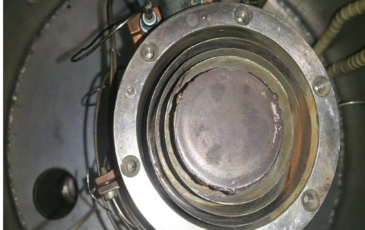
Figura B.33. Interior del Horno
