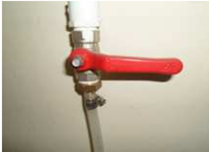
Figura 2.2. Válvula de flujo de entrada de agua domiciliaria tipo bola. [Fuente propia].
