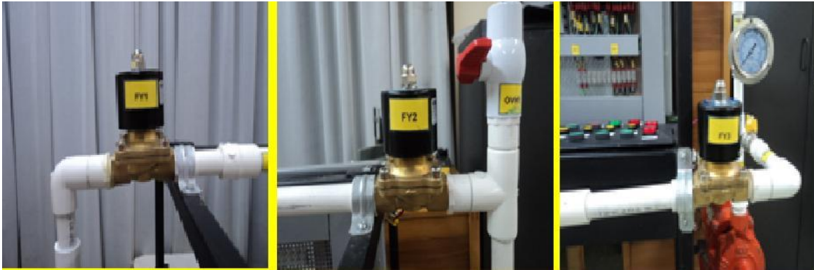
Figura 11 Electroválvulas FY1, FY2, FY3 respectivamente.
