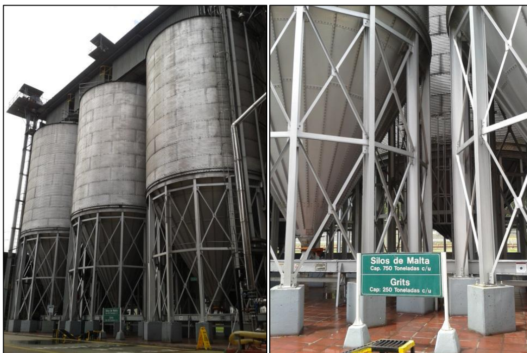
Figura 26. Silos de Almacenamiento de materias primas
