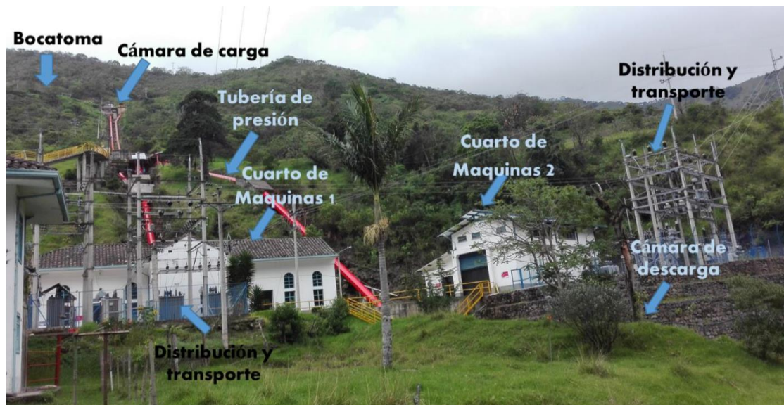
Figura 1. Central hidroeléctrica (PCH) de EMEESA S.A. E.S.P. Fuente: Propia
