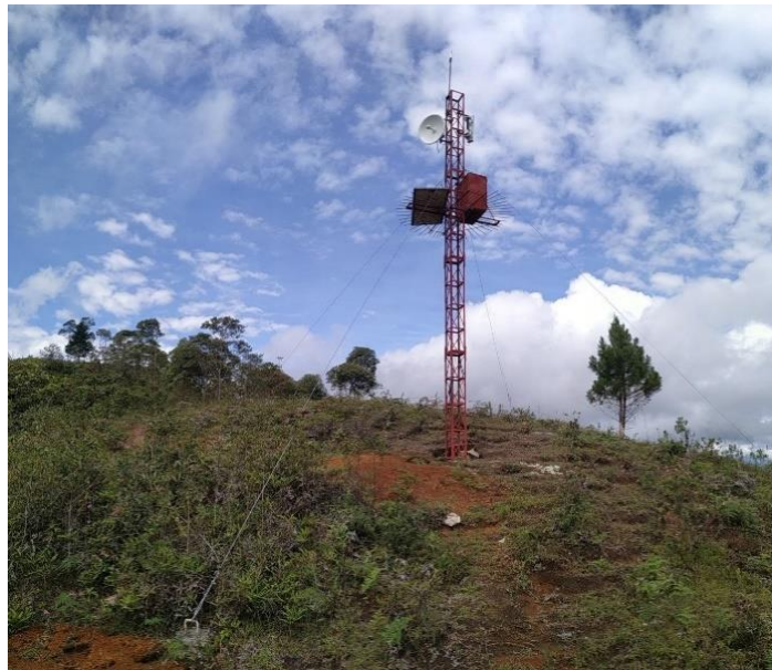
Fig. 54. Torre de la BS San Rafael.
