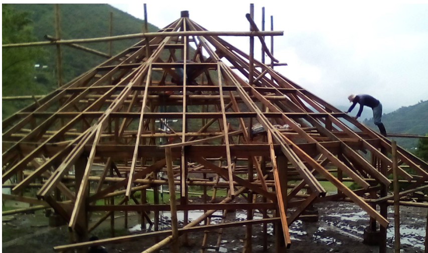
Foto 61 y Foto 62 Construcción del Uus yat (casa del pensamiento nasa) (Fotos facilitadas por la familia Méndez Secue)
