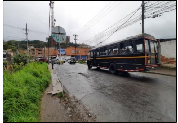
Ilustración 22 Deterioro capa de rodadura cra 4 Ilustración 23 Baches, hundimientos y fisuras.
