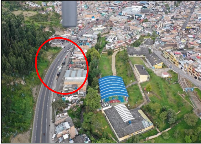
Ilustración 6. Vista general ramal sur.
