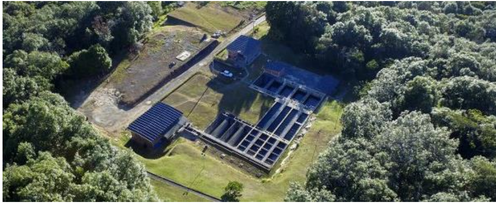
Figura 2.3: Vista aérea Planta Palace AAPSA. Fuente: Acueducto y alcantarillado de Popayán S.A. E.S.P
