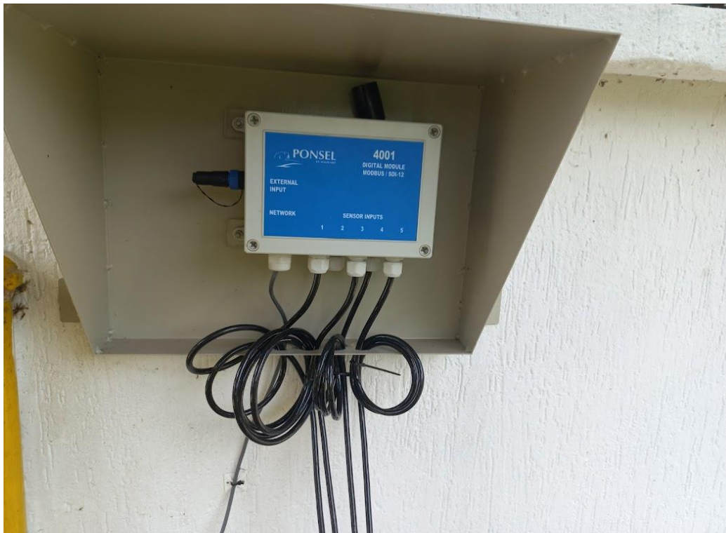
Figura 4.6: Instalación junction box aqualabo. Fuente: Propia.
