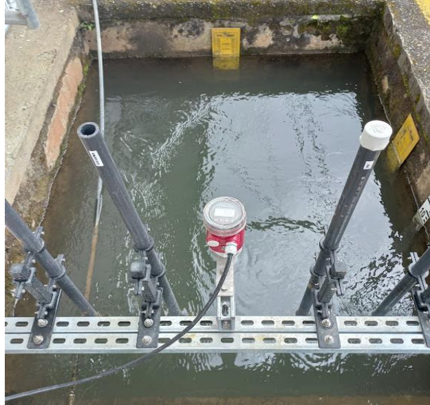
Figura 4.4: Instalación soporte de sensores.
