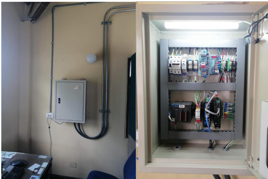
Figura 4.3: Gabinete de entrada instalado. Fuente: Propia.
