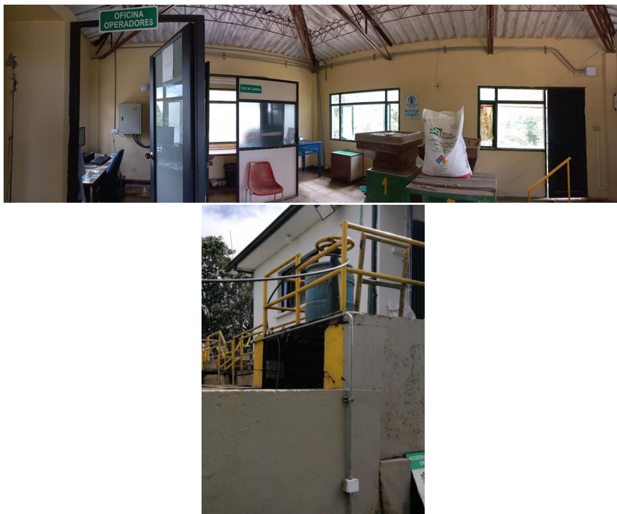
Figura 4.1: Instalación de tubería eléctrica, cableado de potencia y señal.
