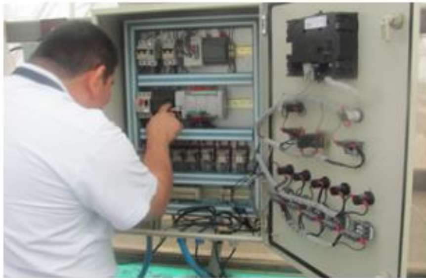
Figura 2.10 Sistema de riego automatizado.
