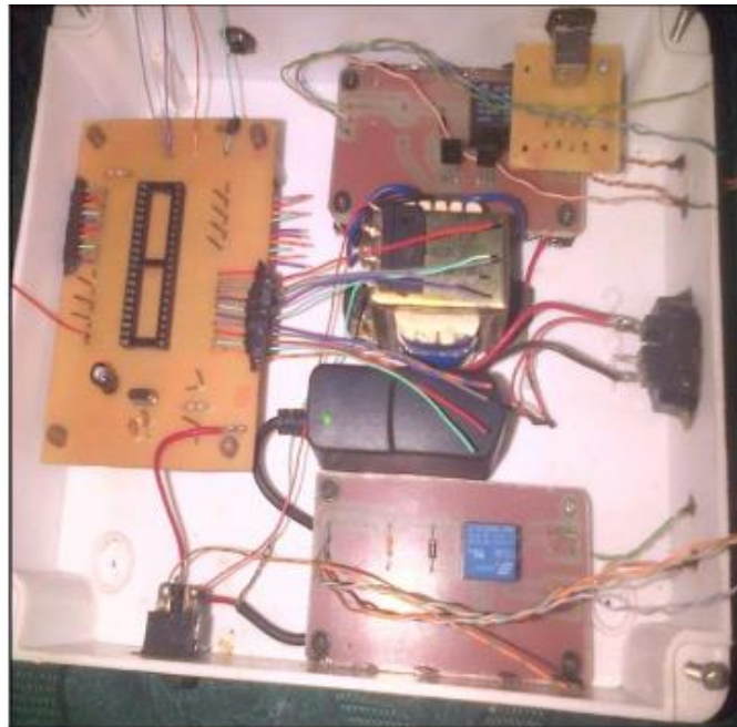
Figura 2.7 Sistema de control de riego.
