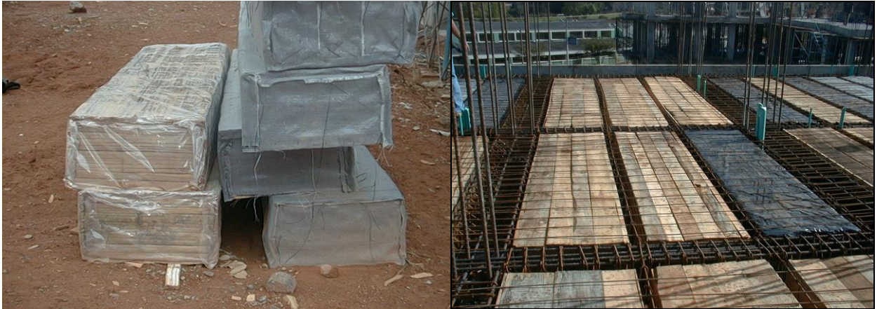
Foto (A15). Casetones forrados en plástico y Foto (A16). Casetones en madera sin forrar casetex
