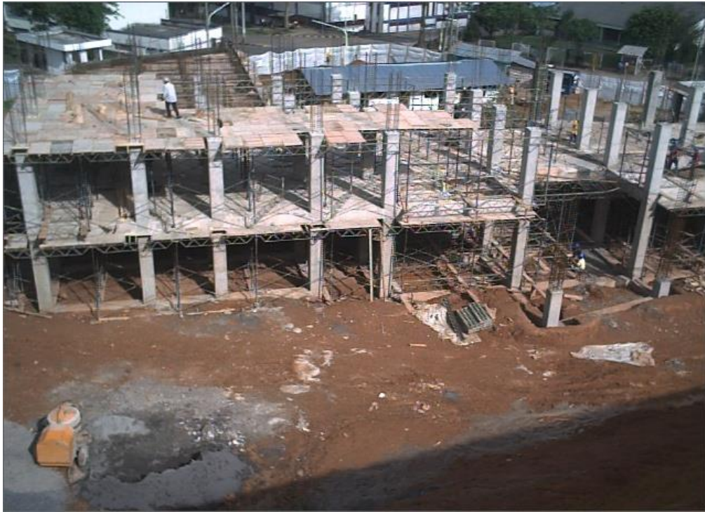
Foto No. 19 Entablerado para losa de 3° piso
