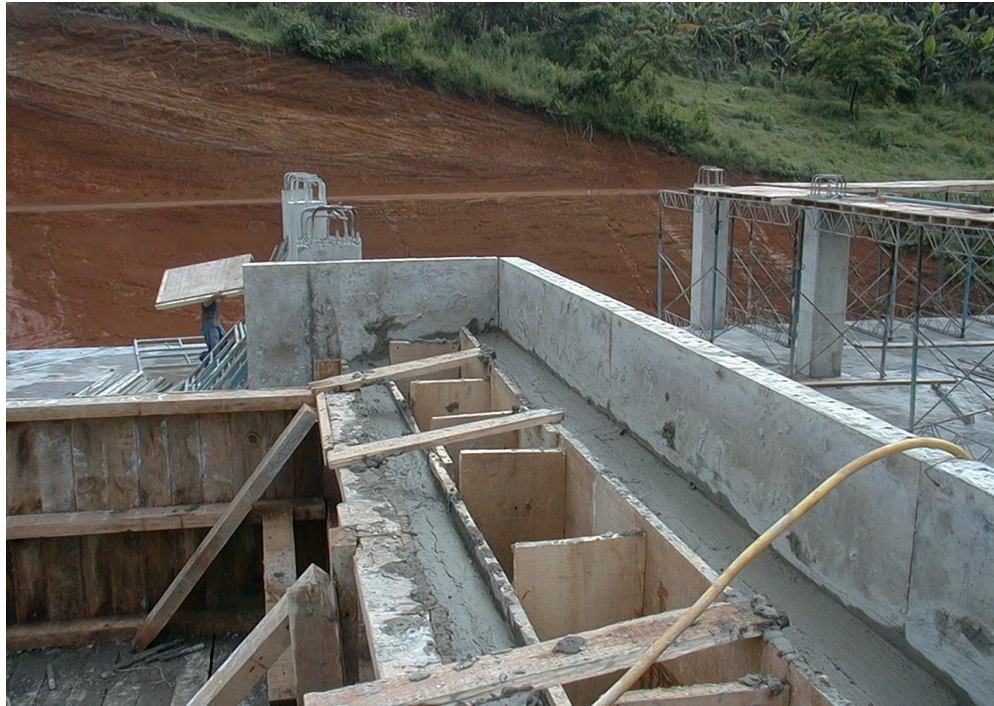
Foto No. 31 Viga canal recién fundida
