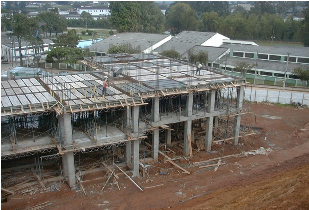
Foto No. 20 Losa de 3° piso próxima a ser fundida
