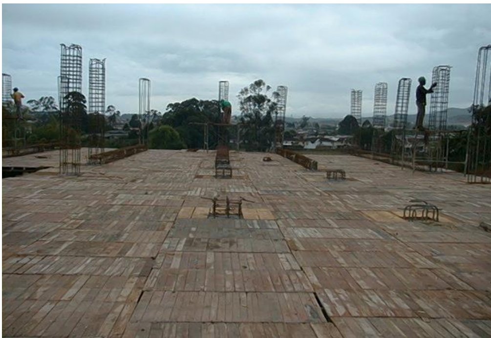
Foto No. 28 Detalle de columnas que terminan a nivel de la losa de 4° piso
