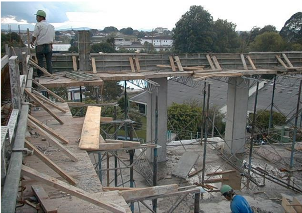
Foto No. 30 Formateado de vigas de cubierta
