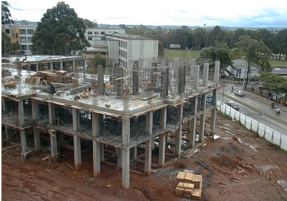
Foto No. 21 Columnas de 3° a 4° piso en proceso de construcción
