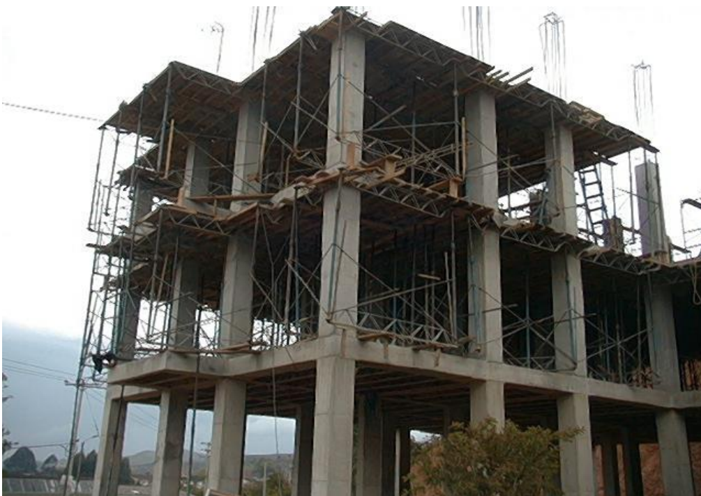
Foto No. 22 Entablado para los del 4° (último) piso
