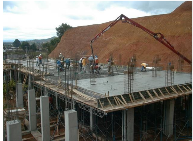
Foto (A10). Fundición de placa de entrepiso
