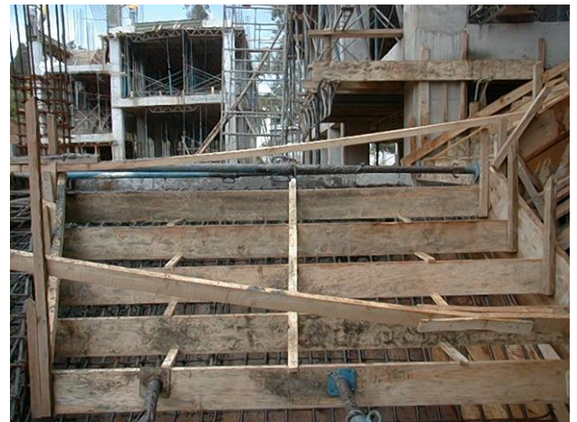
Foto (A12). Formaletería de escaleras
