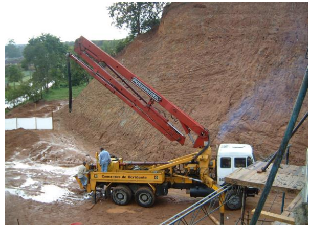
Foto (A1). Camiones mixers utilizados para transporte del concreto Foto (A2). Autobomba
