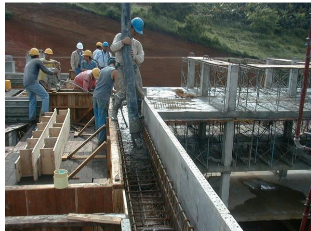
Foto (A14). Vaciado de concreto vigas de cubierta
