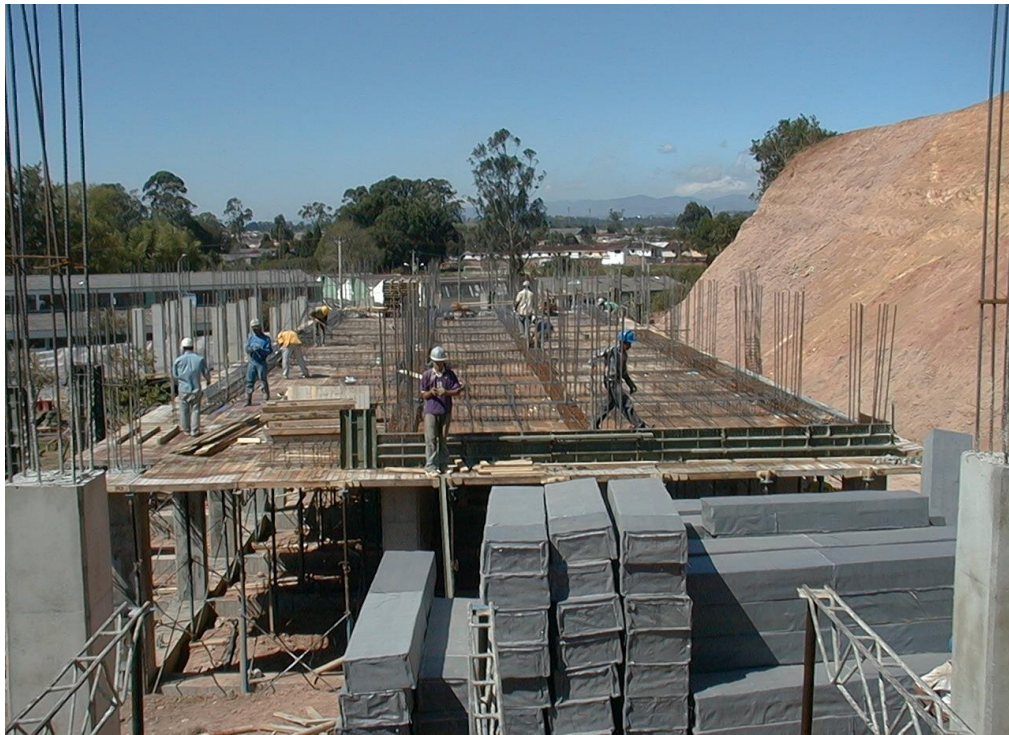
Foto No. 15 Encofrado perimetral de la losa de entrepiso (2° piso)
