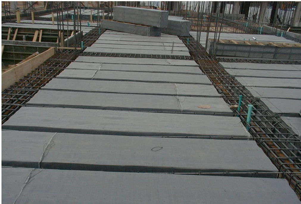
Foto No. 14 Disposición de los casetones en la losa de entrepiso (2° piso)
