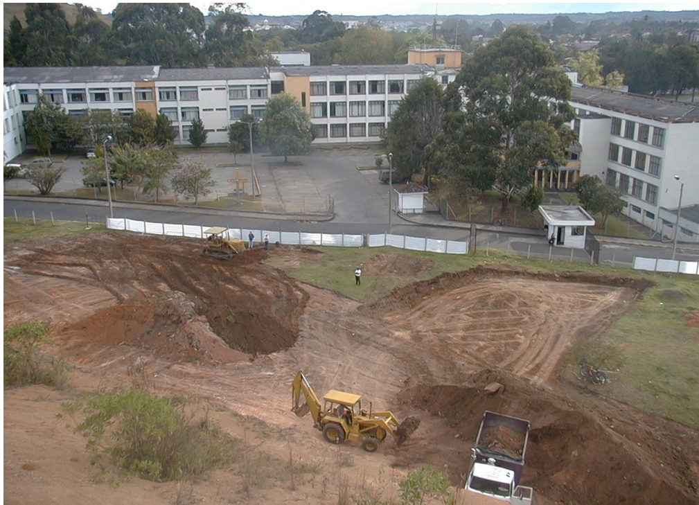
Foto No. 1 Trabajos de descapote del terreno
