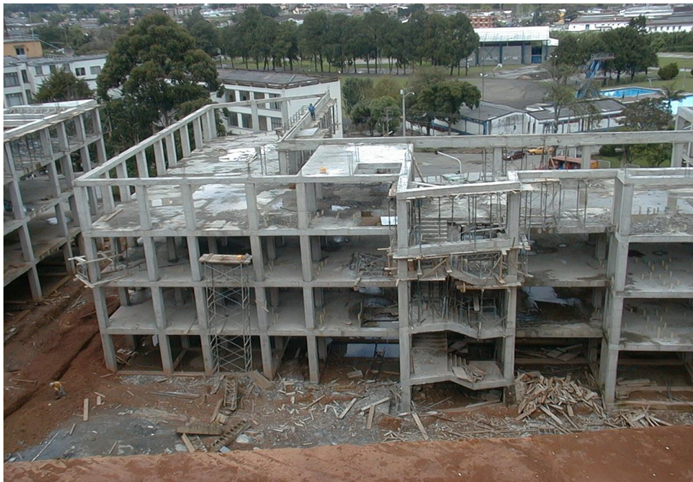
Foto No. 32 Vigas y losa de cubierta terminadas
