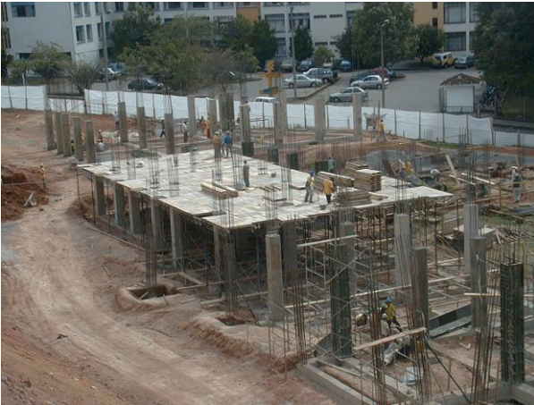
Foto (A9). Sistema de apoyo para fundición de placa de entrepiso
