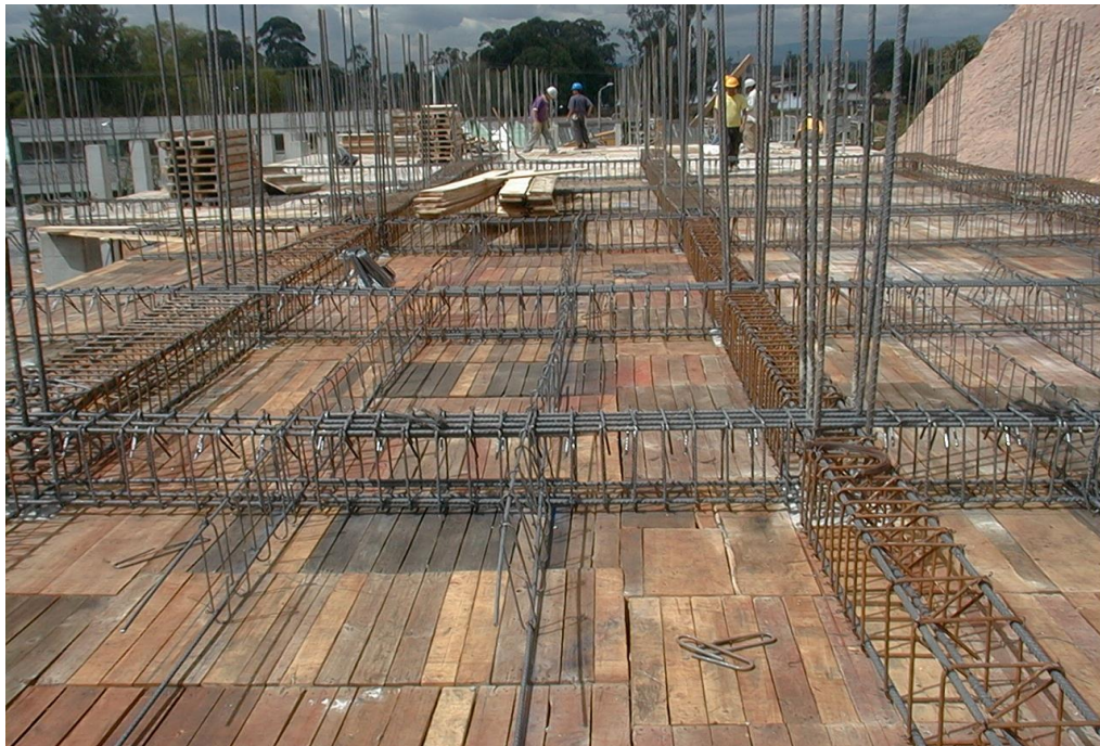
Foto No. 12 Amarre de de vigas y viguetas para losa aligerada de entrepiso
