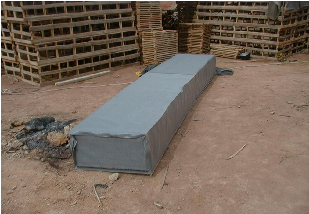
Foto No. 13 casetón forrado con casetex; al fondo, casetones sin forrar
