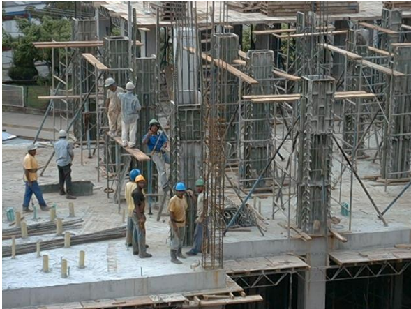
Foto (A5). formaleta metálica para columnas
