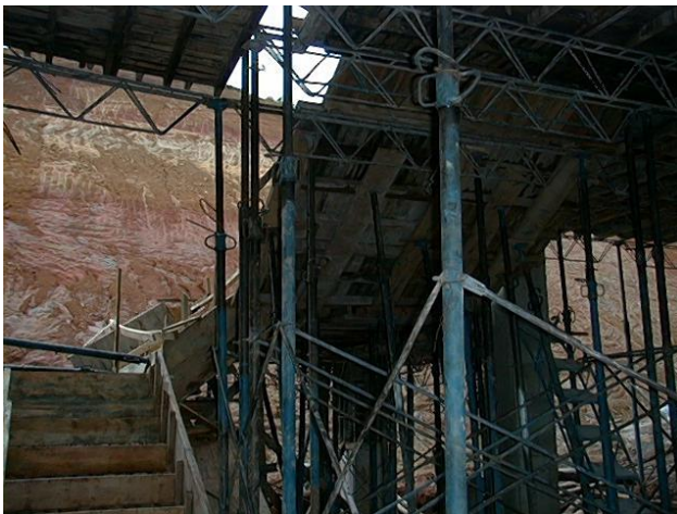
Foto (A11). Sistema de apoyo para fabricación de escaleras
