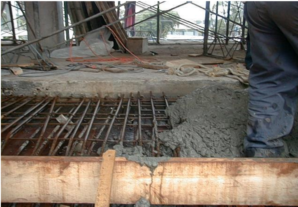
Foto No. 26 Vaciado de concreto para escaleras
