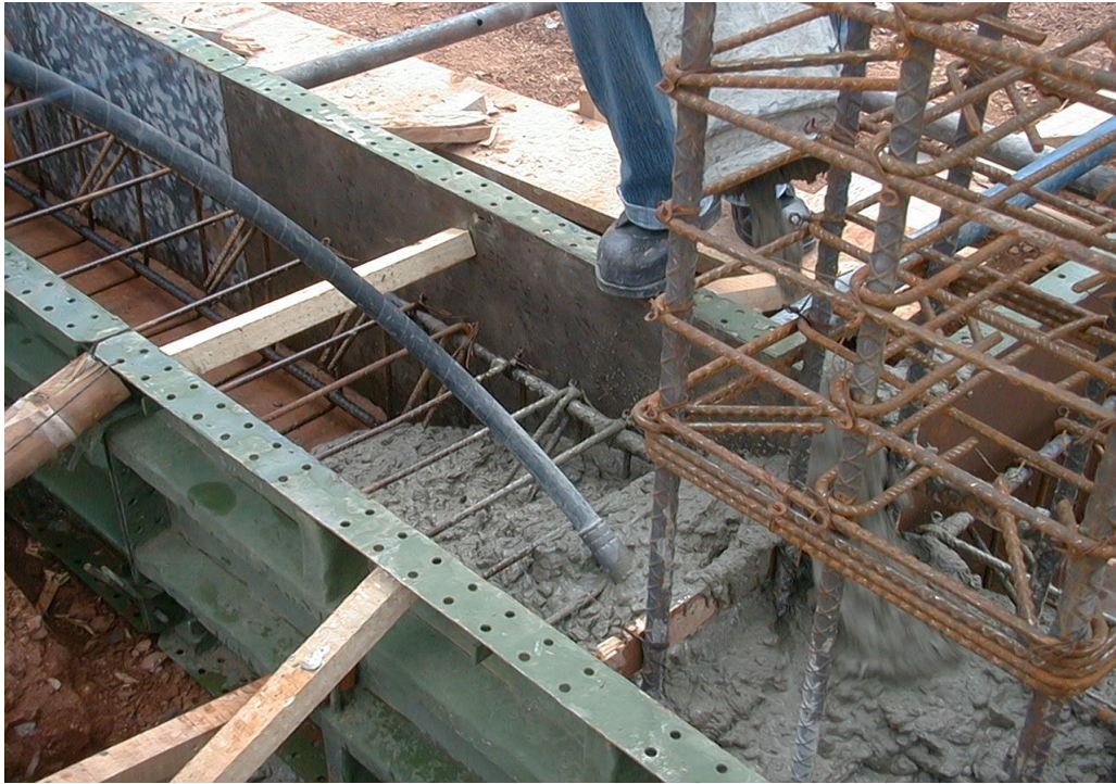
Foto No. 9 Vaciado y vibrado de concreto para vigas de cimentación
