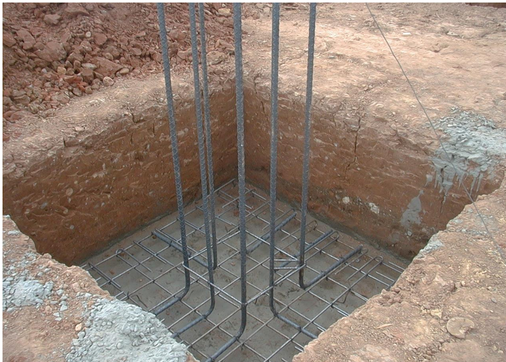
Foto No. 7 Amarre de acero para zapatas y arranque de columnas
