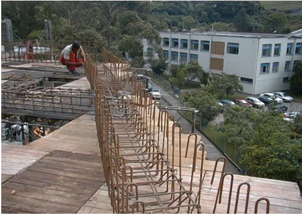
Foto No. 29 Acero amarrado para viga de cubierta (Viga canal)
