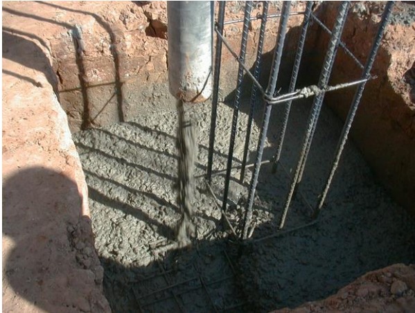
Foto (A3). Vaciado de concreto para zapatas
