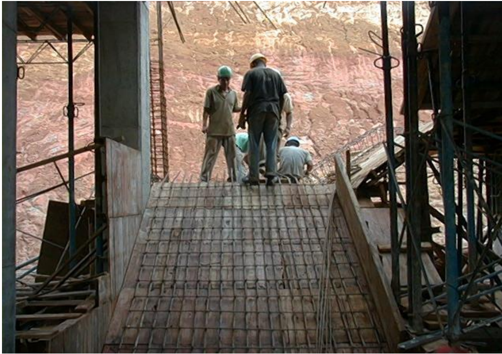
Foto No. 25 Amarre de acero para escaleras
