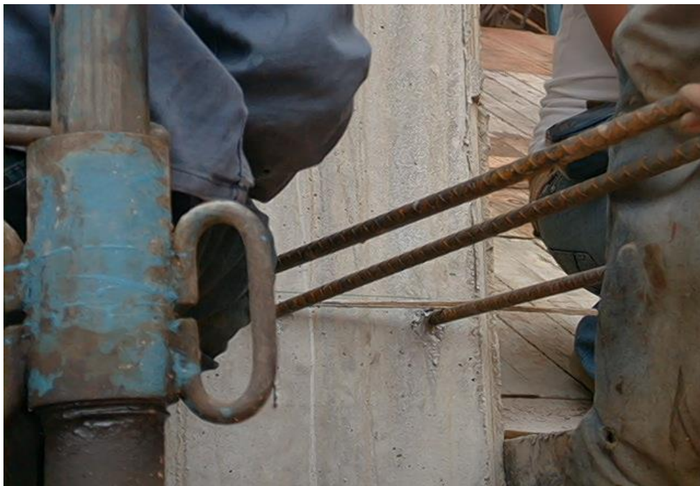
Foto No. 24 Colocación de anclajes, barras No. 5 con mortero epóxico
