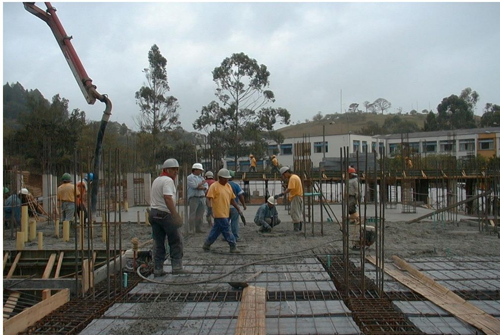
Foto No. 16 Fundición de losa de entrepiso (2° piso)
