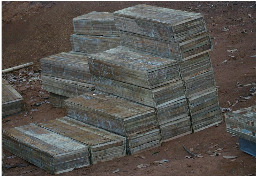
Foto No. 18 Casetones totalmente cubiertos con esterilla (para ser forrados con plástico)
