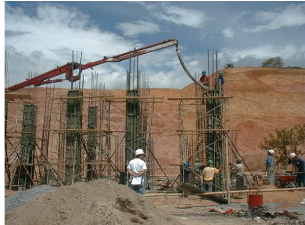
Foto (A6). Vaciado de columnas
