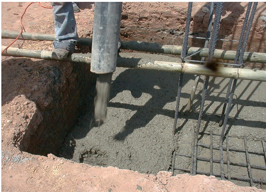
Foto No. 8 Vaciado de concreto para zapatas
