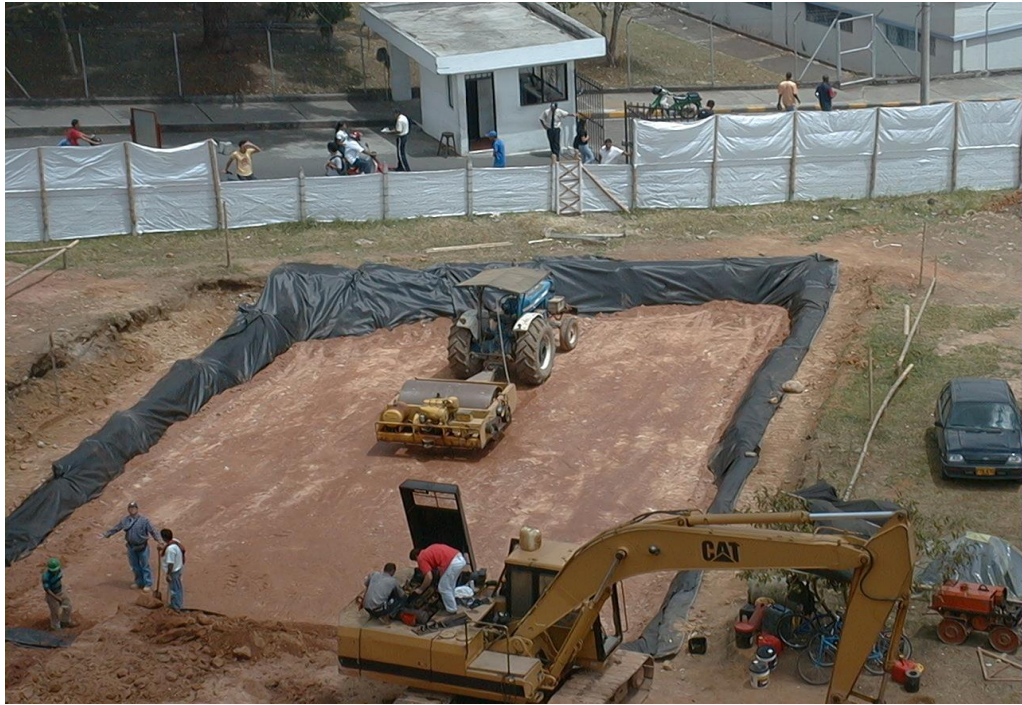
Foto No 5 Relleno compactado y reforzado con geotextil tejido.
