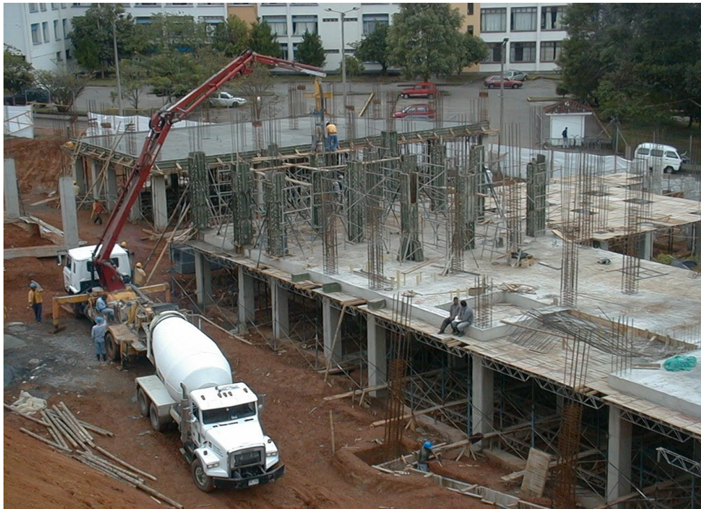
Foto No. 17 Colocación de concreto para columnas de 2° a 3° piso
