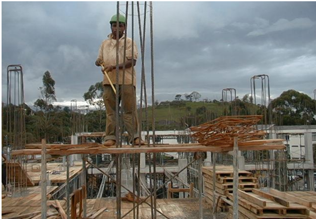
Foto No. 27 Amarre de acero para columnas de 4° piso a cubierta
