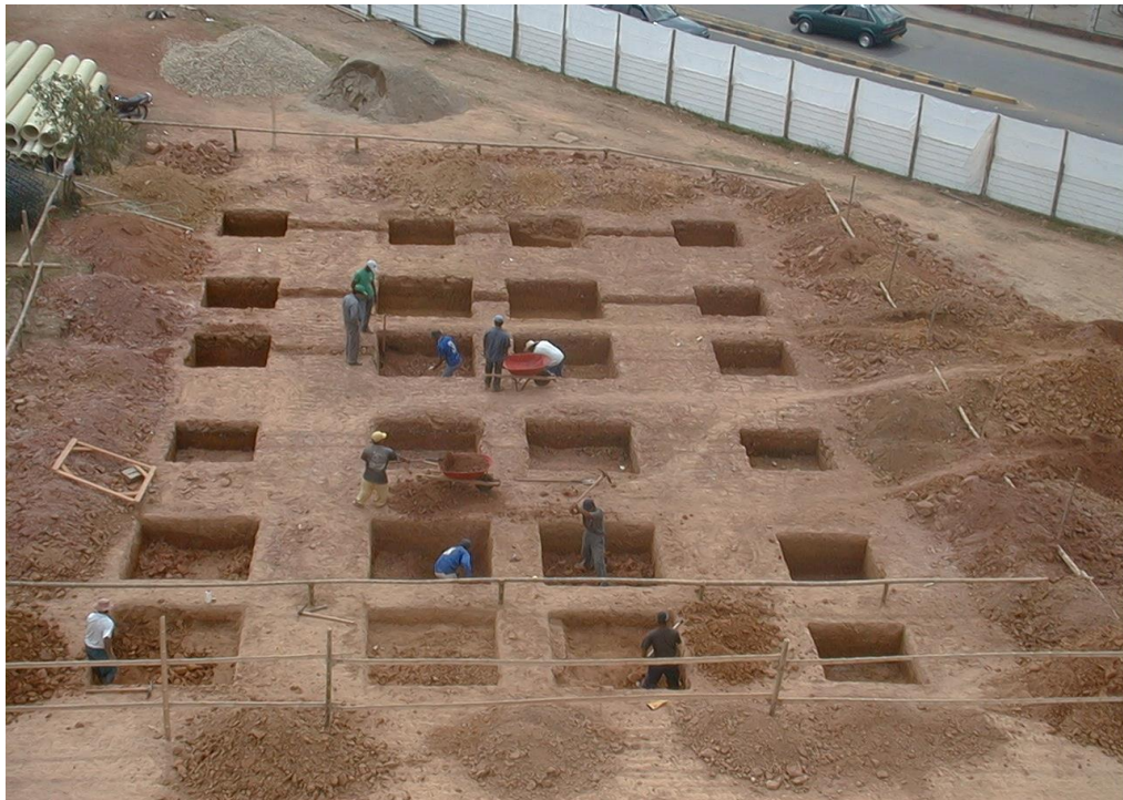
Foto No. 6 Excavaciones para cimientos
