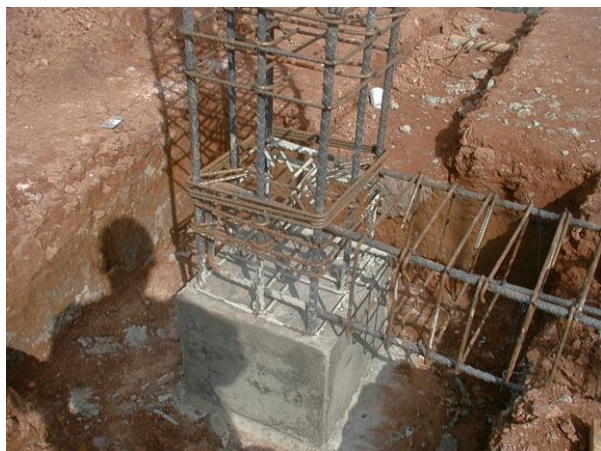
Foto (A8). Pedestal terminado
