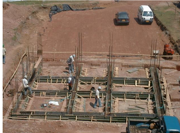
Foto (A4). Formaleta para vigas de cimentación
