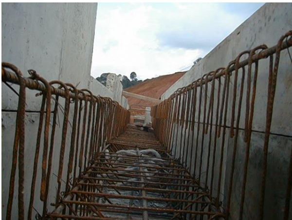
Foto (A13). Formaletería de viga canal
