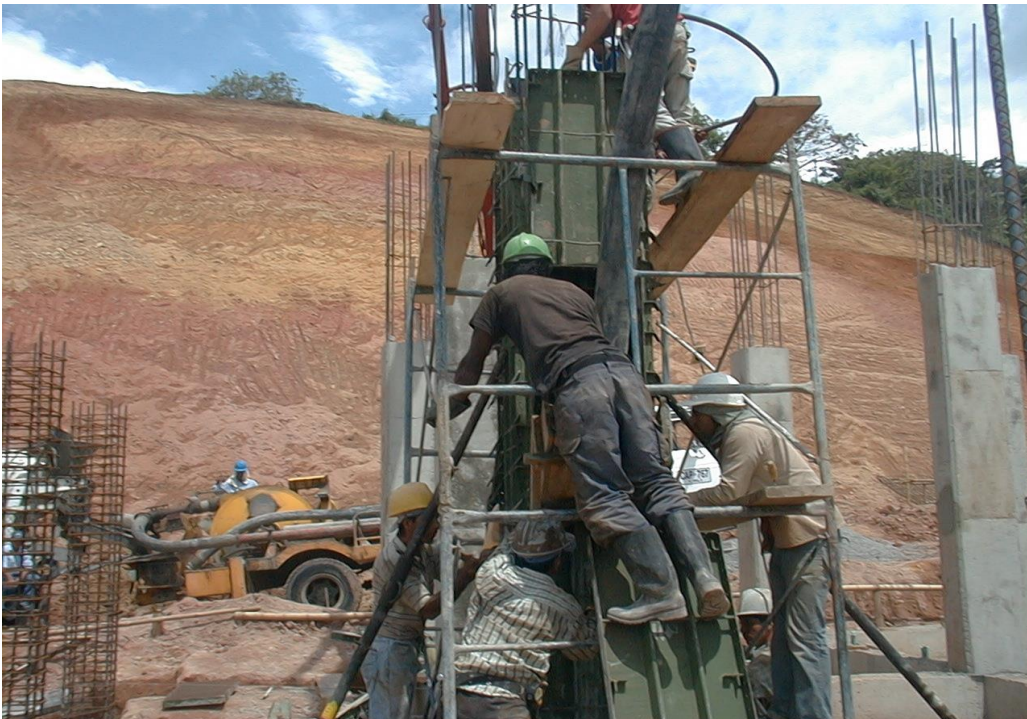
Foto No. 10 Vaciado de concreto para columnas de primer piso (formaletaría metálica)
