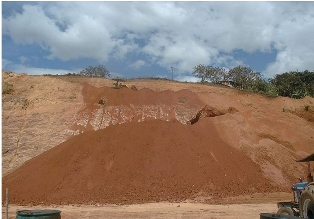
Foto No. 2 Corte y perfilado del talud posterior al Edificio de la FCCEA
