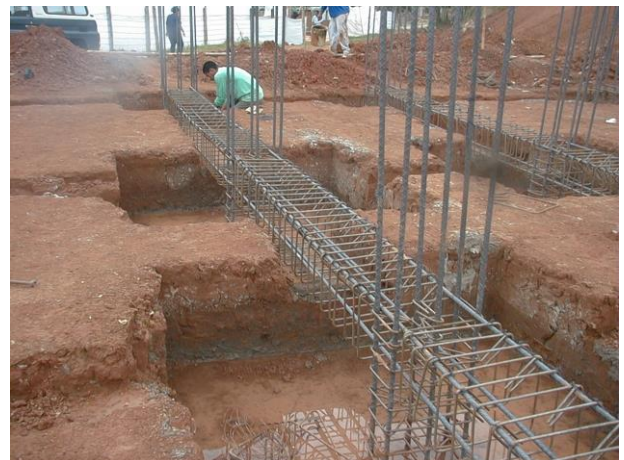
Foto (A18). Amarre de acero de vigas de cimentación.
