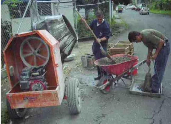
Figura 4. Mezcla mecánica y ensayo de asentamiento.
