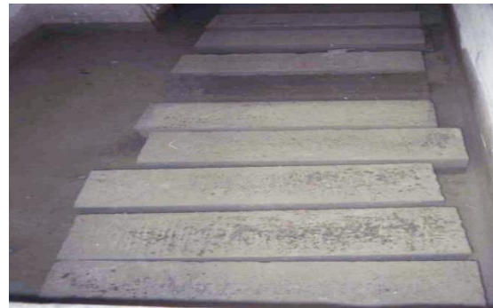
Curado de vigas
