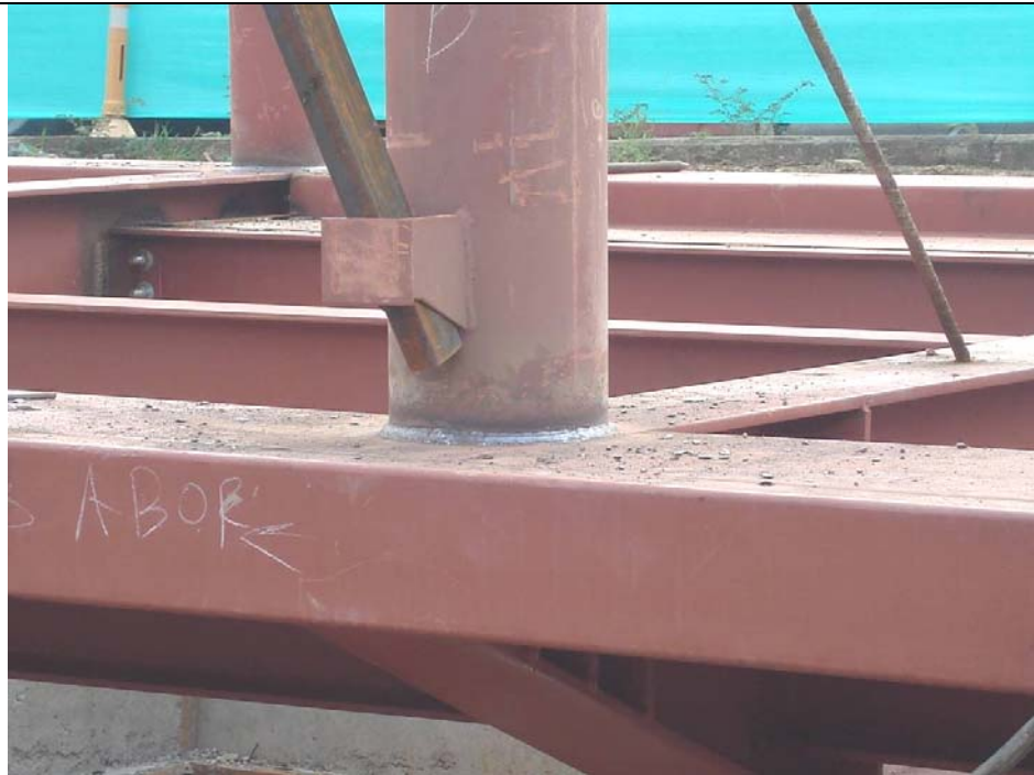
Después de montadas las columnas sobre los recibidores, se une la plataforma con la columna con soldadura
