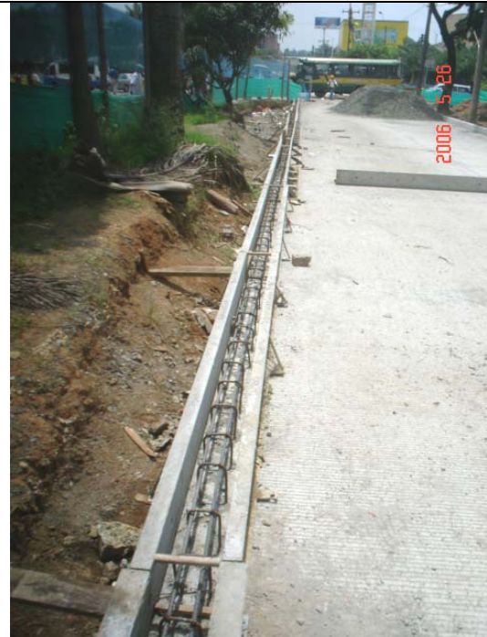
El concreto utilizado es de 210Kg/cm2 (3000PSI).
