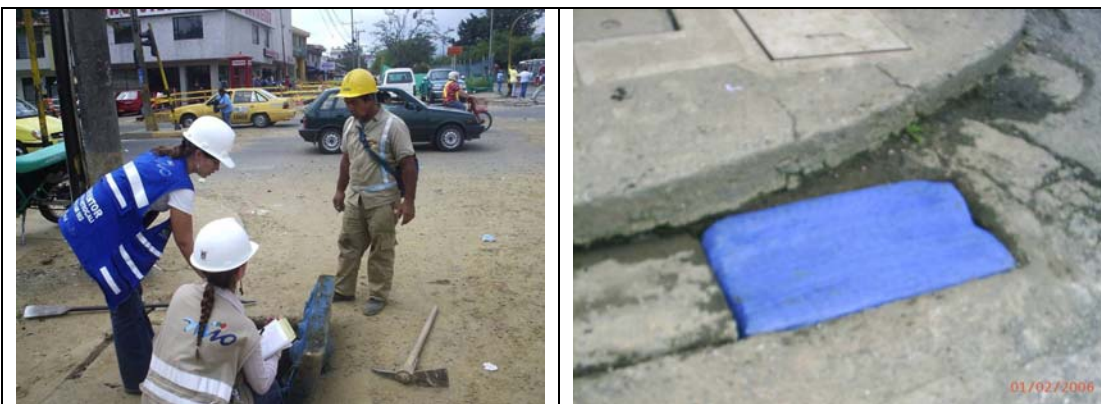
Mantenimiento y revisión de sumideros
