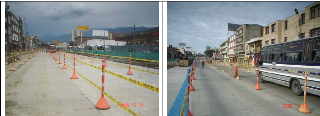
En la segunda etapa, se habilitó la calzada Oriental desde la Carrera 27 hasta antes del puente Roosevelt. Desde este punto hasta la Carrera 15, el flujo de buses y colectivos continua por la calzada occidental.
