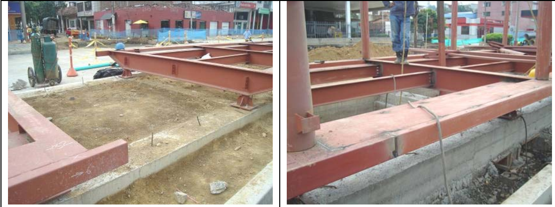
Las tres plataformas se unen con vigas aseguradas con tornillos y soldadura.
