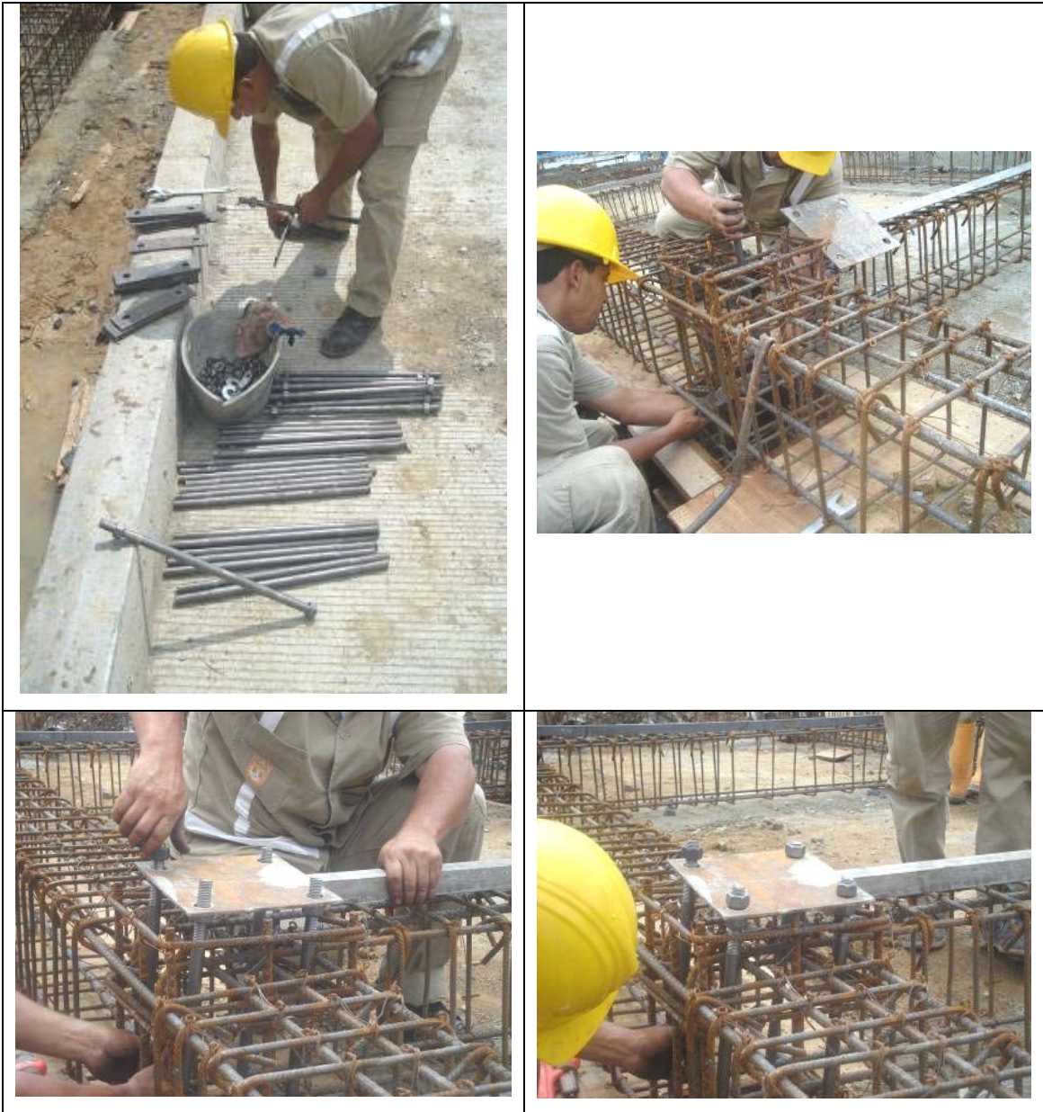
La colocación de los pernos se realiza con una platina guía, que sirve para mantener transversalmente la distancia exacta de la estructura metálica que se montará después.
