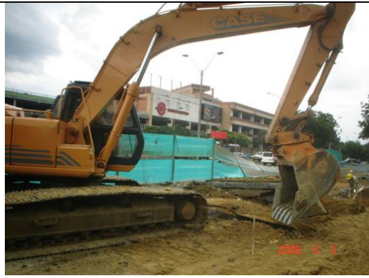
Excavadora de orugas
