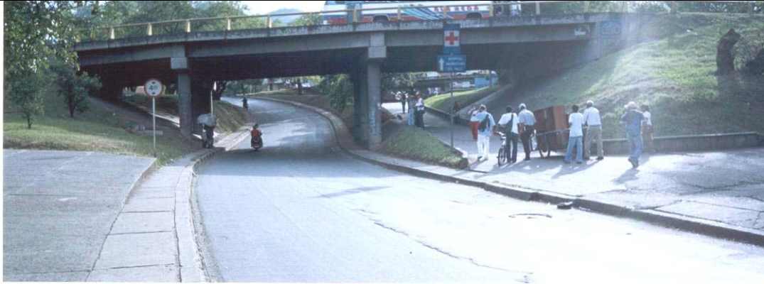
Sección antigua del puente Santa Librada
