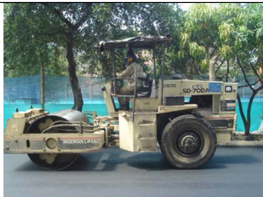
Vibrocompactador de rodillo
