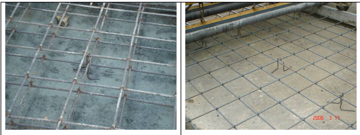
Chequeo de separaciones entre parrillas y recubrimientos mínimos
