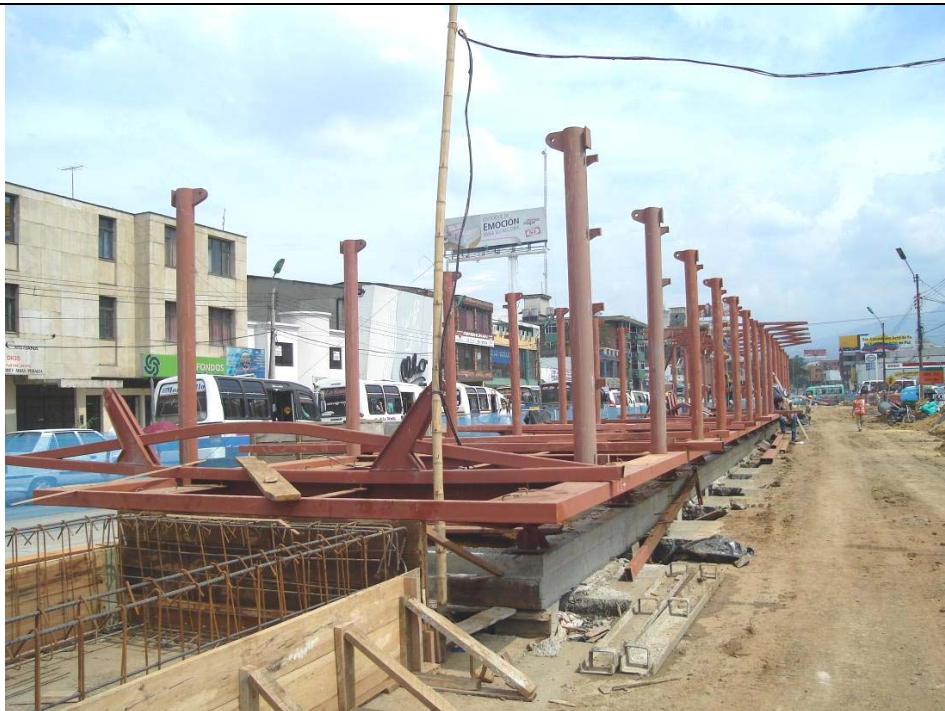
Después de montadas las columnas sobre los recibidores, se une la plataforma con la columna con soldadura
