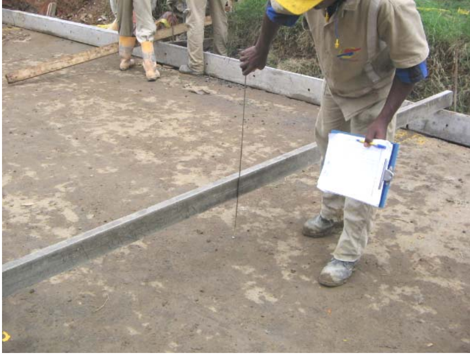
Chequeo el espesor mínimo del pavimento
