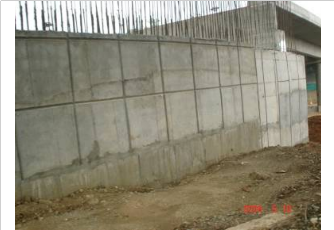
Construcción de las aletas
