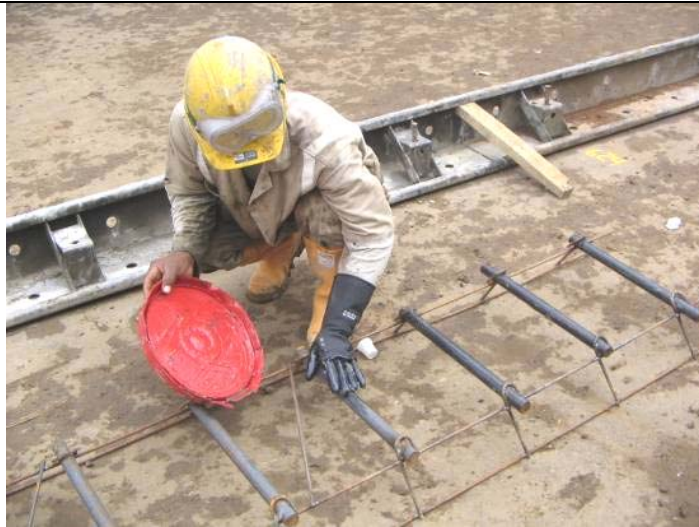
Utilizando guantes de caucho se engrasan los pasadores lisos de 1"o 1¼" .
