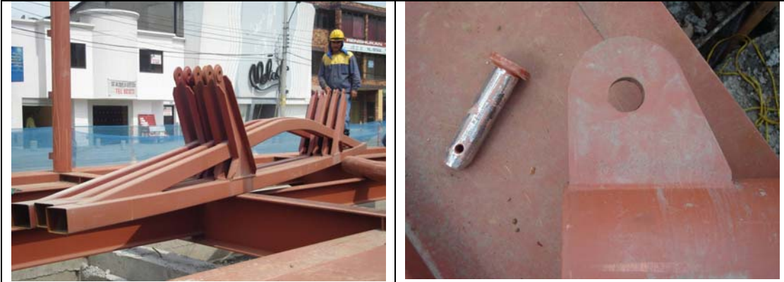
Cerchas que se colocan en la parte superior de las columnas, aseguradas con pasadores metálicos.
