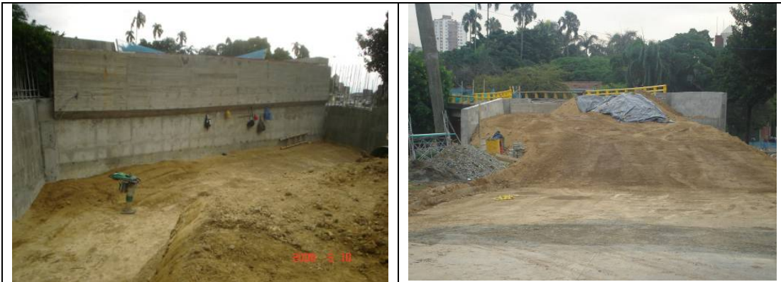
Relleno del terraplén contenido por el estribo y las aletas
