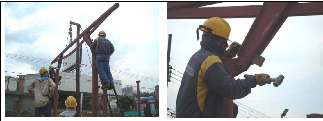
Cerchas que se colocan en la parte superior de las columnas, aseguradas con pasadores metálicos.
