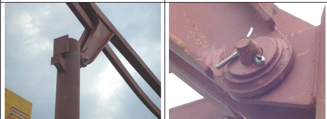
Izada y montaje de cerchas. Los pasadores se aseguran con chavetas.
