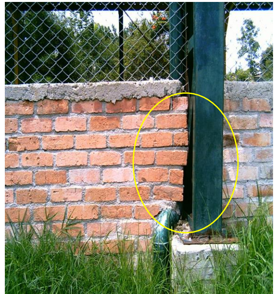
Se observa la unión del muro a la estructura metálica y a la tubería de PVC
