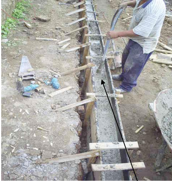
Se observa proceso de vibrado del concreto para lograr un mejor acomodo y distribución de las partículas
