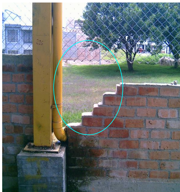
Confinamiento incorrecto del muro. Unión muro a bajante de aguas lluvias de PVC
