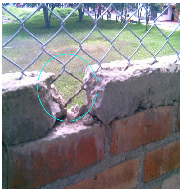
Se observa el pisa malla en pésimas condiciones, por un posible uso de materiales de mala calidad.
