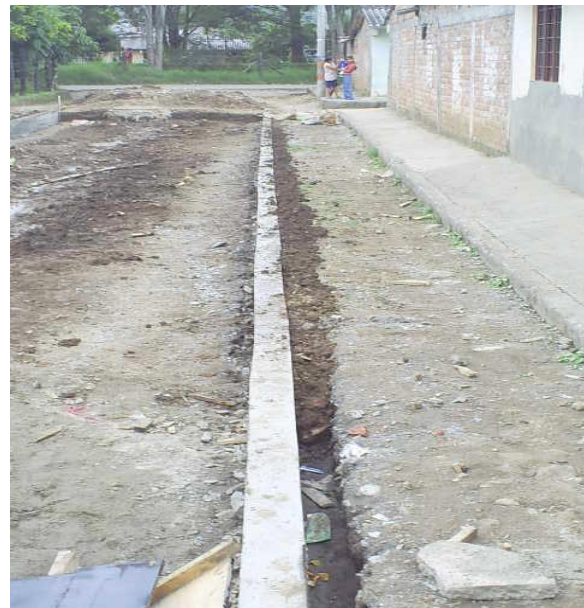
Se muestra sardinel derecho, totalmente terminado.
