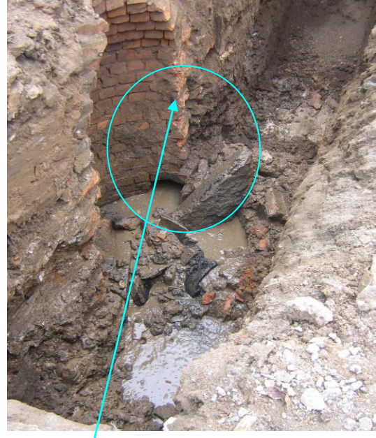
Cámaras existentes en ladrillo, demolidas para ser construidas en concreto conforme normatividad técnica vigente.
