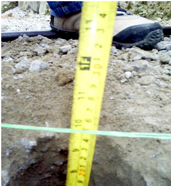
Se sigue perforando hasta alcanzar el nivel de rasante y se mide el espesor.
