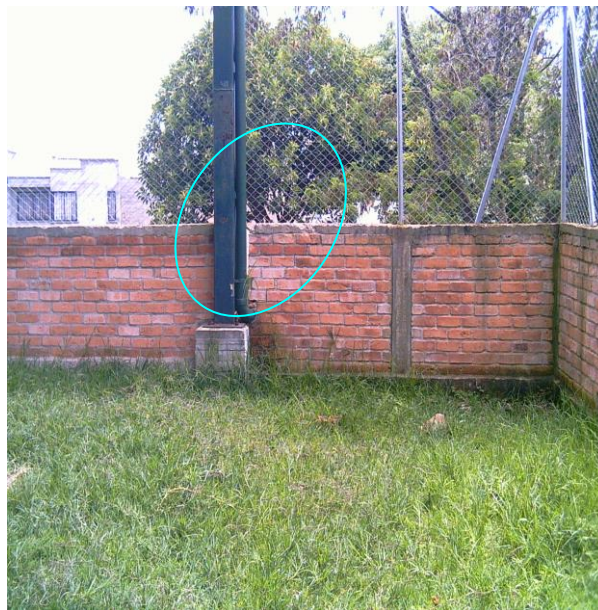
Confinamiento incorrecto del muro. Unión muro a bajante de aguas lluvias de PVC
