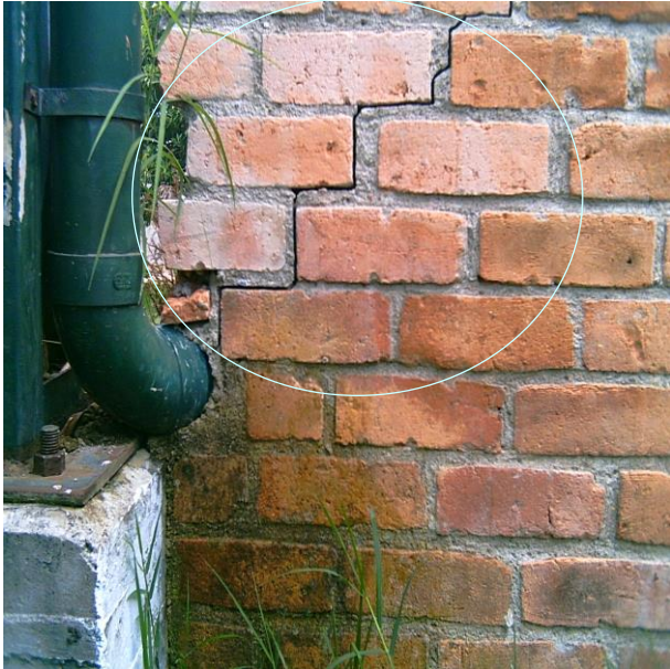
Se observa claramente el inicio de la falla en el muro.
