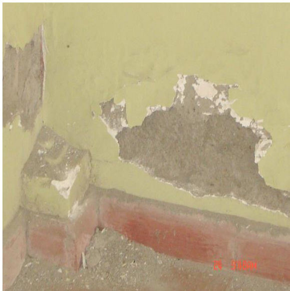
En esta figura se puede ver el avanzado grado de deterioro en el cual se encuentran los repellos de los salones.
