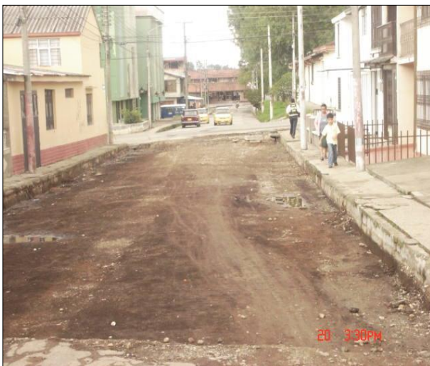
Trabajos de excavación, vías a nivel de sub-rasante
