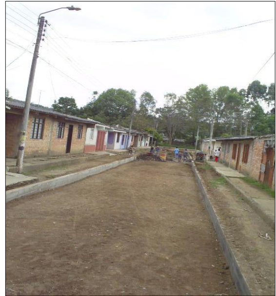
Se muestran los dos sardineles terminados, y se muestra el terreno preparado para la construcción de la estructura del pavimento.
