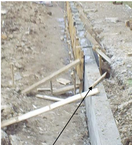
Aquí se muestra el proceso de desencofrado de los sardineles.
