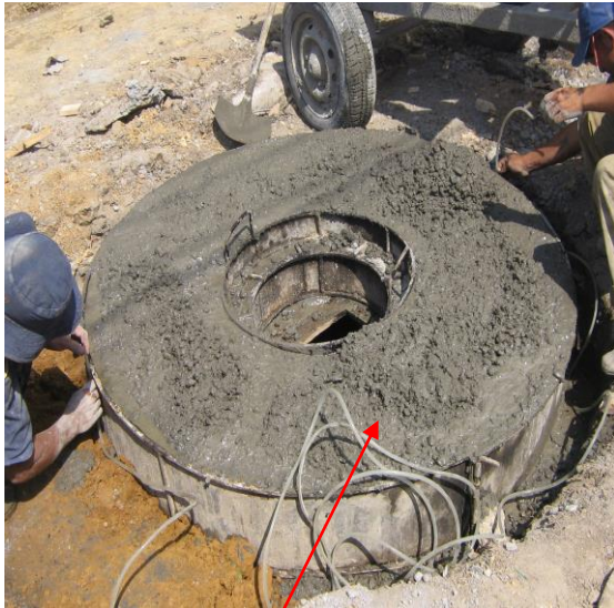
Construcción de cámaras en concreto
