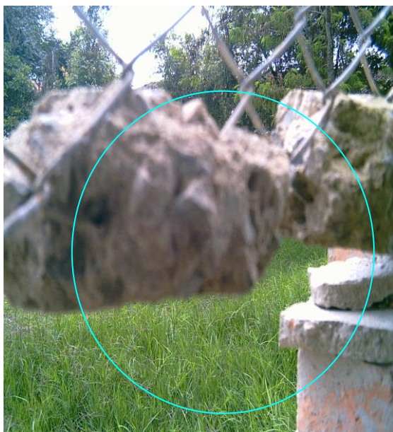
Se observa el pisa malla en pésimas condiciones, por un posible uso de materiales de mala calidad.
