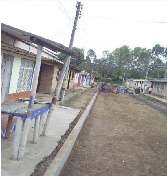
Se observa el sardinel izquierdo totalmente terminado.
