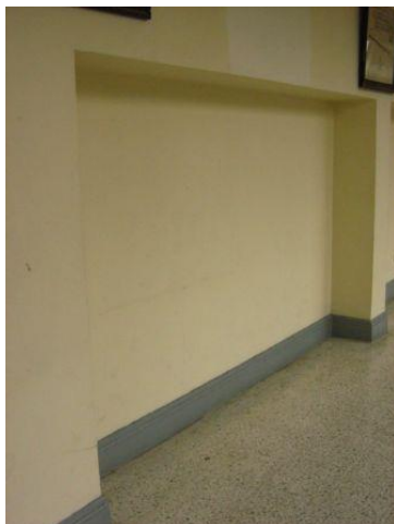
Fotografía 2 Detalle interior y exterior del muro divisorio entre el salón y el pasillo. Nótese la concavidad que se forma en la parte superior (vista interior- fotografía de la derecha) y en la parte inferior (vista exterior – fotografía de la izquierda).
