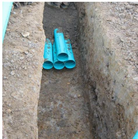
EXCAVACIONES CON DUCTOS PVC PARA ACOMETIDAS ELECTRICAS Y TELEFONICAS
