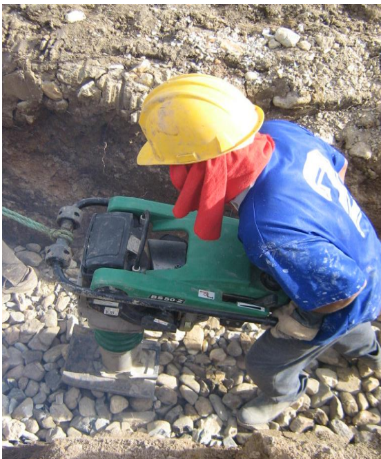
FOTO 14 Y 15: PROCESO DE COMPACTACION DEL MATERIAL FILTRANTE
