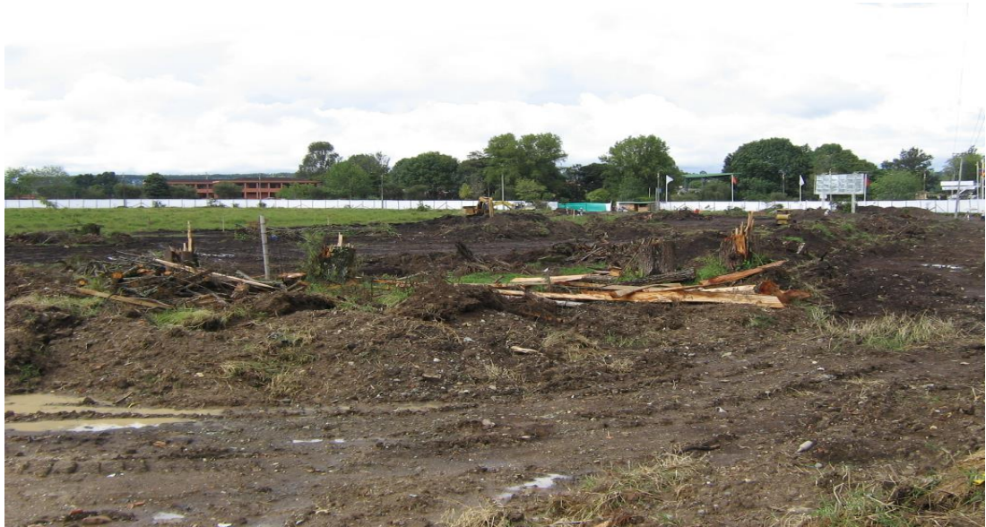
FOTO 5: REMOCION DE LA CAPA VEGETAL.
