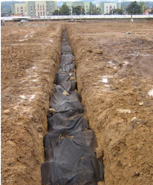
FOTO 16: TERMINACION DE 1 FILTRO
