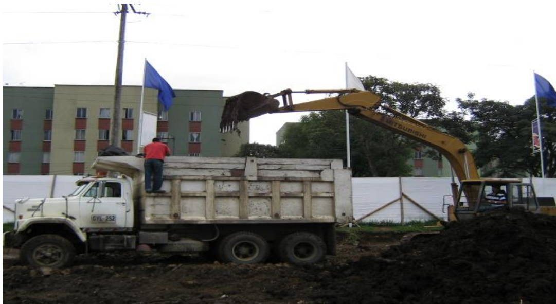
FOTO 6: RETIRO DEL SUELO EXCAVADO.
