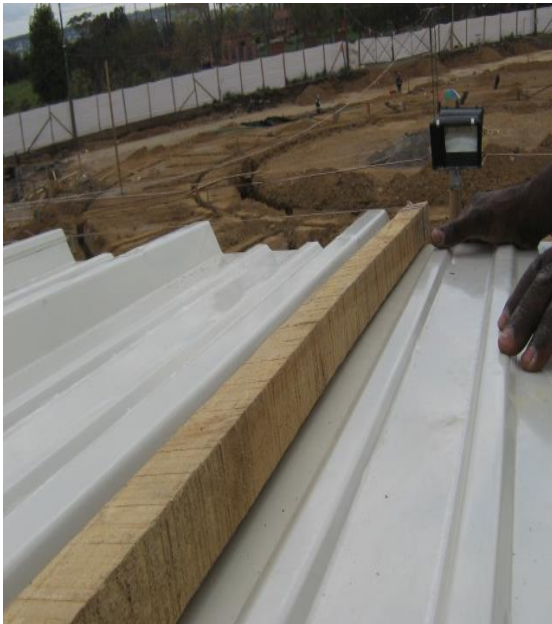
FOTOS 82 Y 83: NIVELACIÓN DE LAS TEJAS YA TRASLAPADAS
