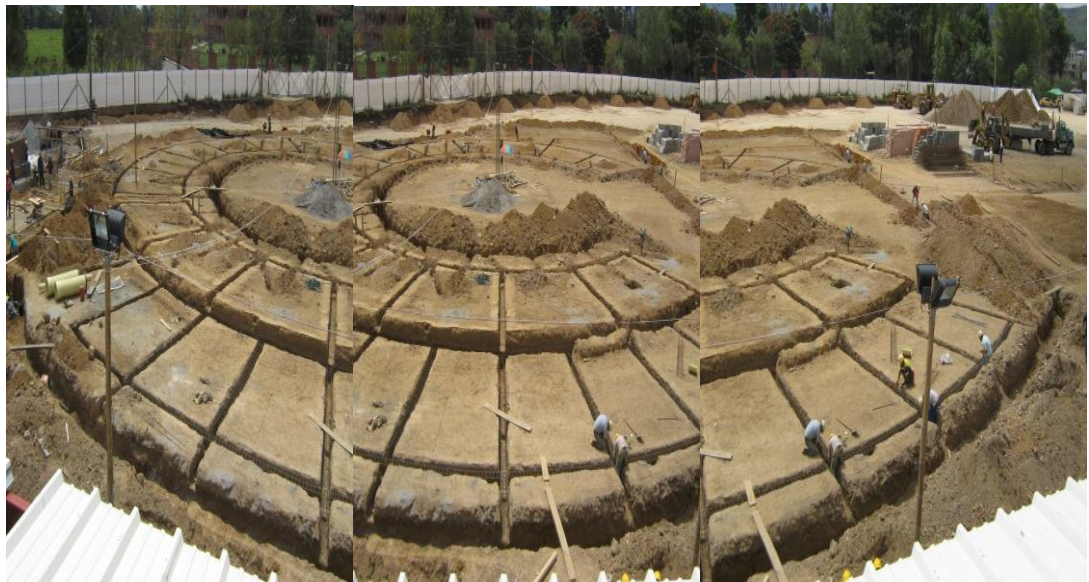
FOTO 43: CIMENTACIÓN DE LA PLAZOLETA DE COMIDAS
