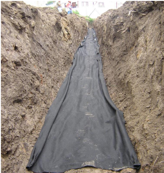
FOTO 10: GEOTEXTIL EN FILTROS
