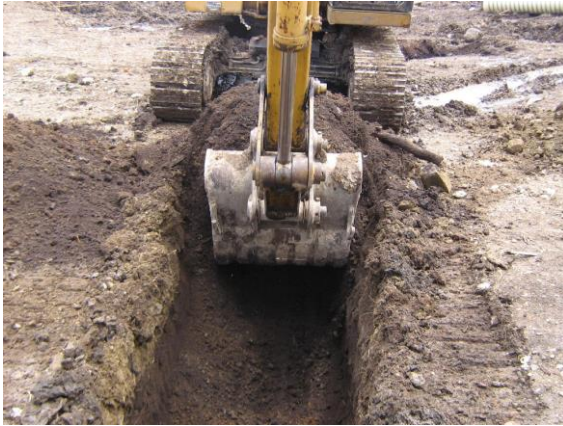
FOTO 8: EXCAVACION PARA FILTROS
