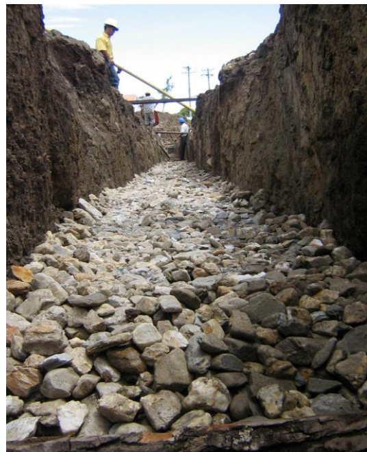
FOTO 14 Y 15: PROCESO DE COMPACTACION DEL MATERIAL FILTRANTE
