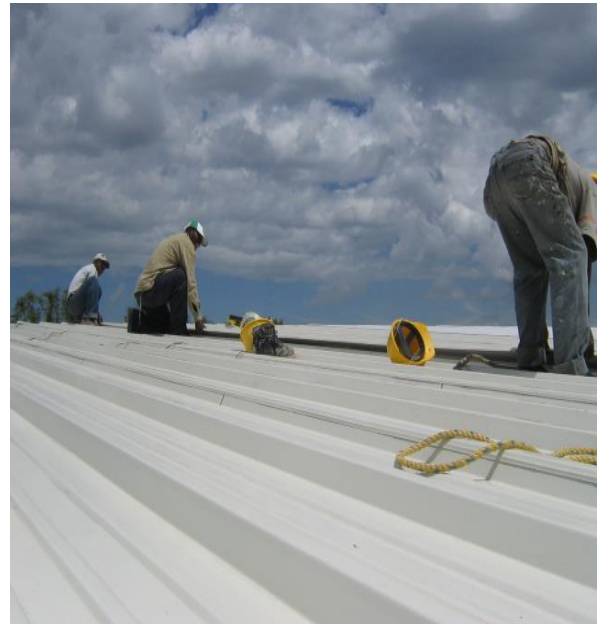
FOTOS 82 Y 83: NIVELACIÓN DE LAS TEJAS YA TRASLAPADAS
