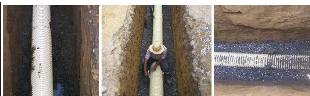
Material utilizado en el encamado de la tubería, instalación y acabado final del mismo.
