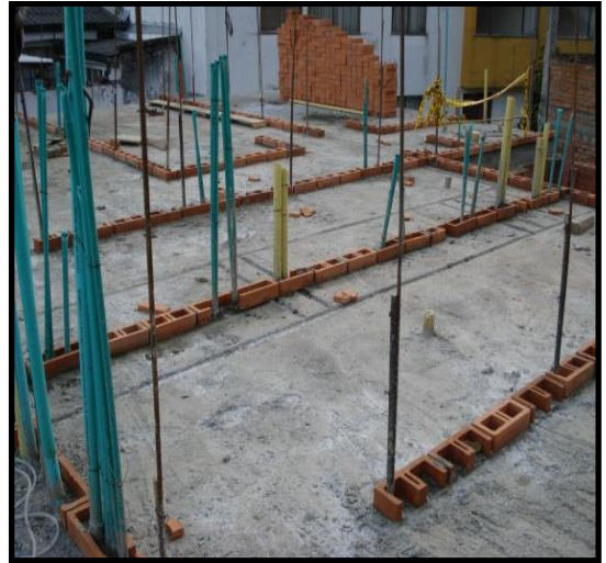
Figuras 5.1.3 y 5.1.4 Muros del primer piso todos llevan las ventanas de limpieza para posteriormente ser fundidos.
