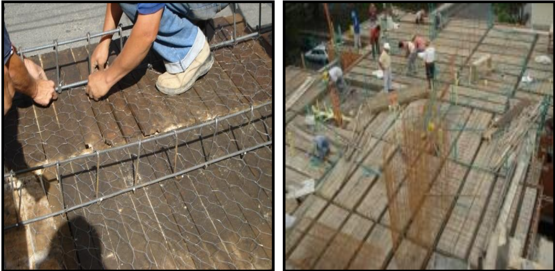
Figuras 6.5 y 6.6 Aceros de viguetas en cada losa, acero de vigas de pórticos sector de parqueadero primer nivel.
