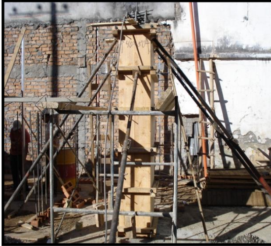
Figura 4.3 y 4.4 Collarín de una columna, acero de refuerzo de una columna
