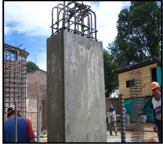
Figura 4.3 y 4.4 Collarín de una columna, acero de refuerzo de una columna
