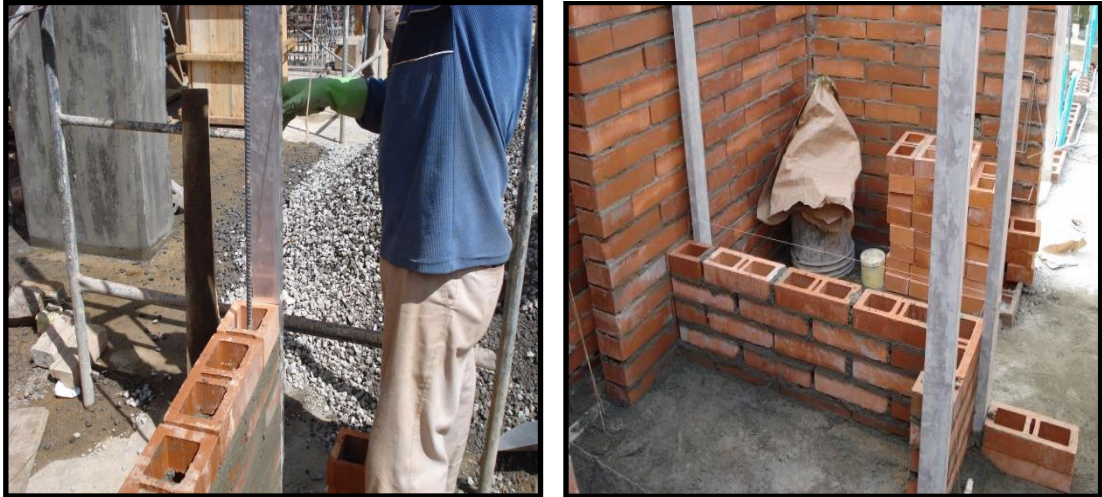
Figuras 5.2.3 y 5.2.4 Hilo horizontal colocado para controlar el nivel horizontal de las hiladas en el muro.
