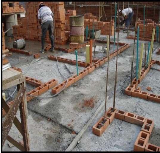
Figuras 5.1.3 y 5.1.4 Muros del primer piso todos llevan las ventanas de limpieza para posteriormente ser fundidos.
