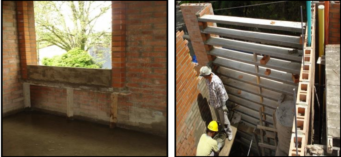
Figuras 8.7 y 8.8 Muro en la sección de sala, colocación de quiebra soles en la grada.
