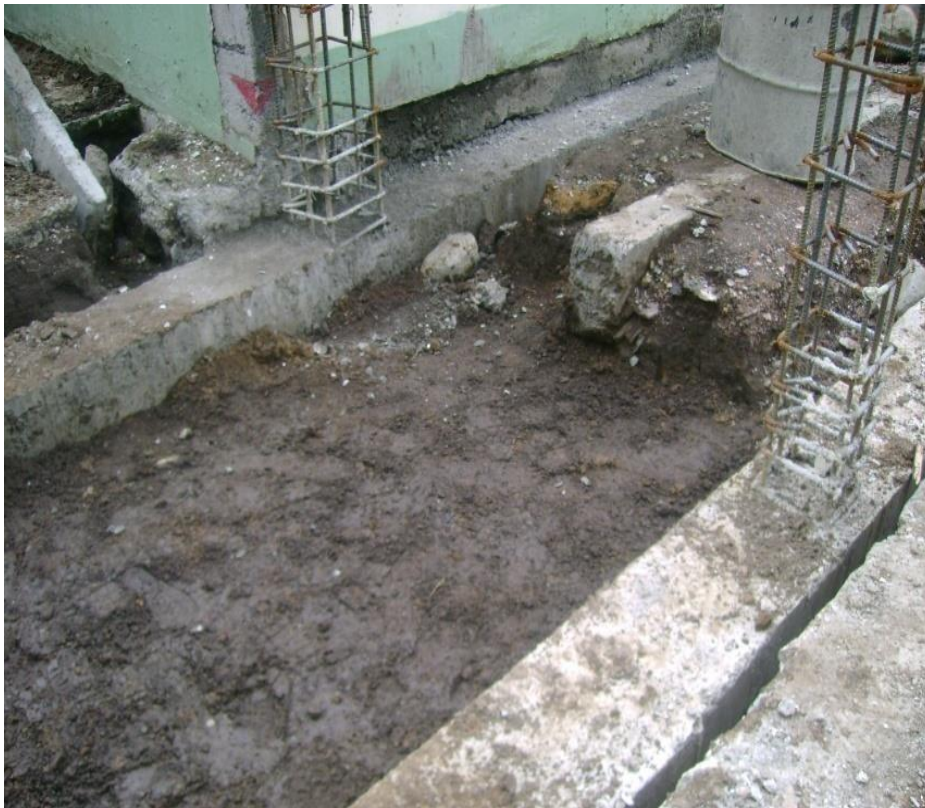
Foto 36: Rellenos para la cimentación.
