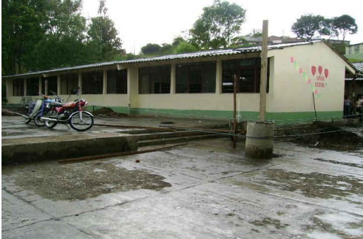
Foto 4: Tipo de sistema estructural.
