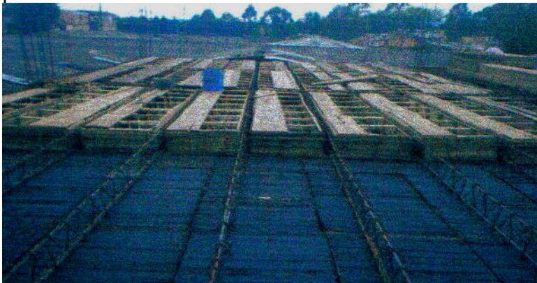
Foto 51: Refuerzo en los nervios. Primero se colocó el acero de los nervios y posteriormente los casetones.
