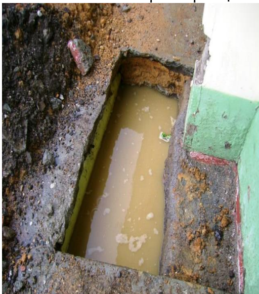
Foto 6: Excavación zapata tipo Z4.
