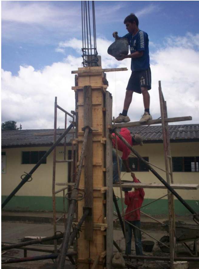
Foto 41: Vaciado del concreto.
