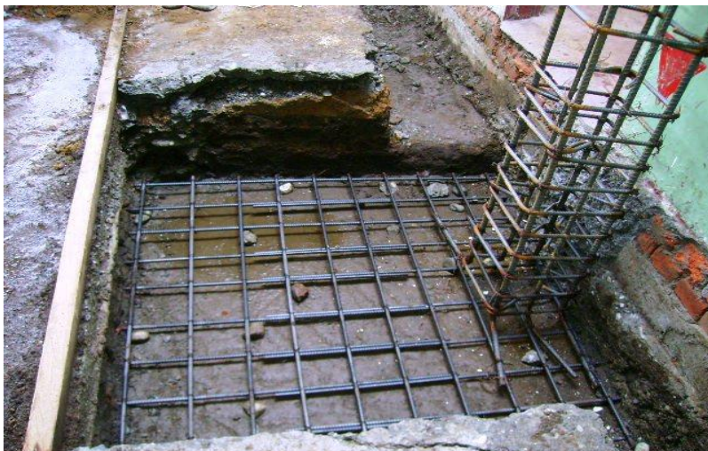
Foto 16: Colocación del acero.
