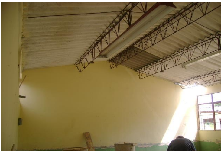
Foto 5: Cerchas. Las tejas están sostenidas mediante un sistema de cerchas.
