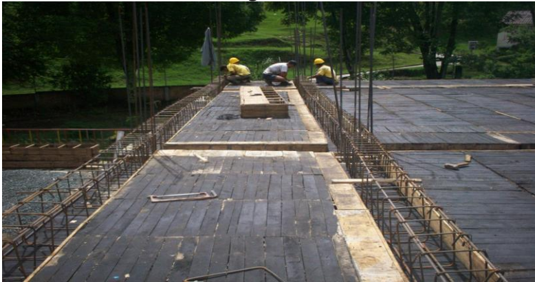
Foto 50: Refuerzo de las vigas de amarre.
