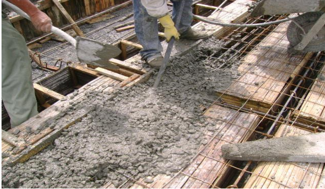
Foto 55: Compactación del Concreto.
