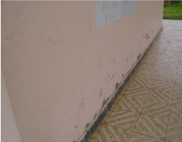
Foto 67: Pisos y Muros.
