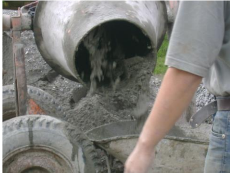
Foto 24: Vaciado del concreto.
