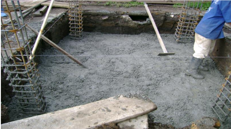
Foto 27: Colocación del concreto.
