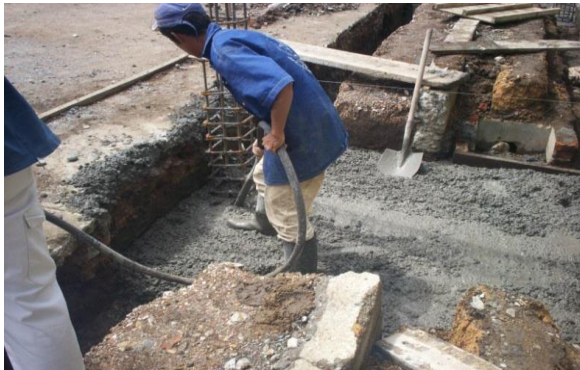
foto 28: Compactacion del concreto
