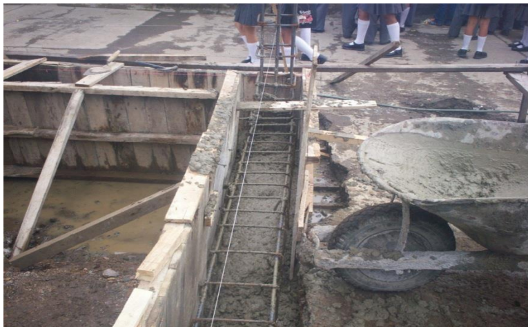
Foto 32: Vaciado del concreto.
