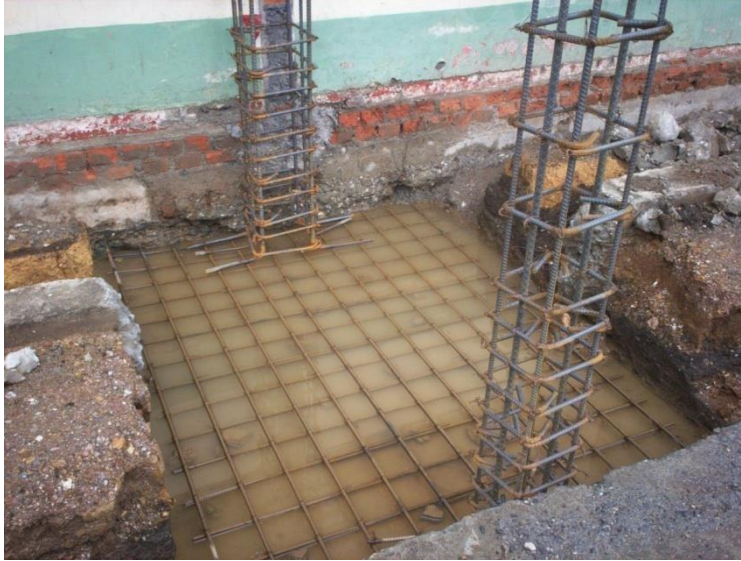
Foto 12: Acero en las columnas.
