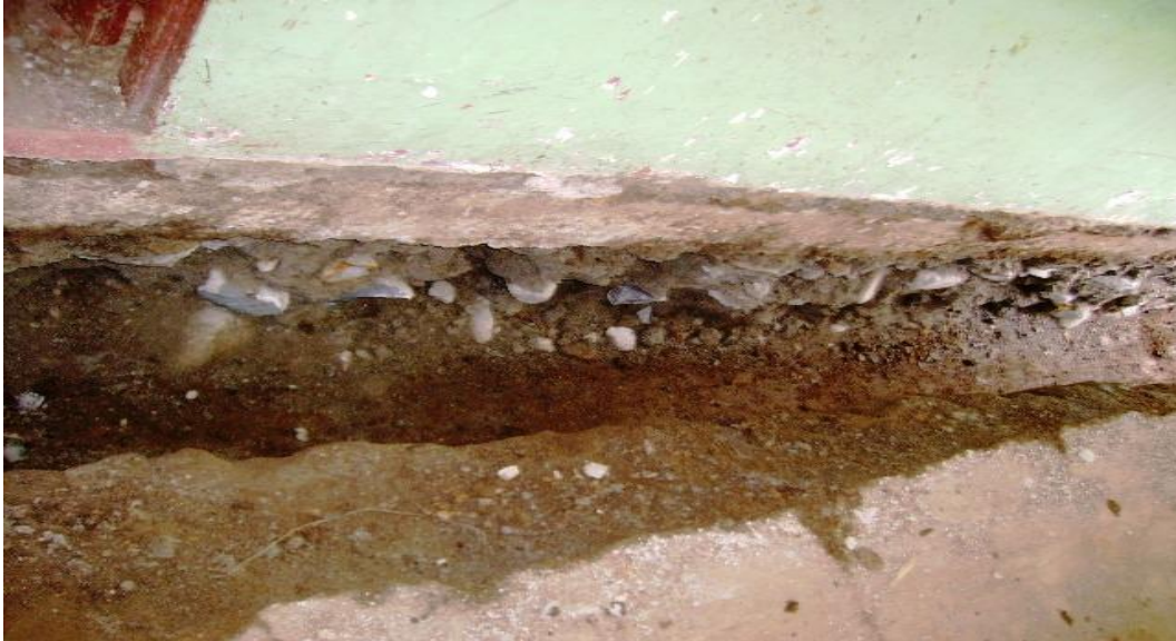
Foto 2: Cimentaciones. En estas fotos se puede ver claramente el concreto Ciclópeo encima de la zapata corrida y encima va el muro.
