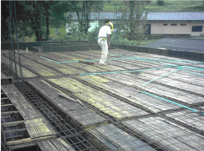
Foto 52: Refuerzo de tracción y temperatura.
