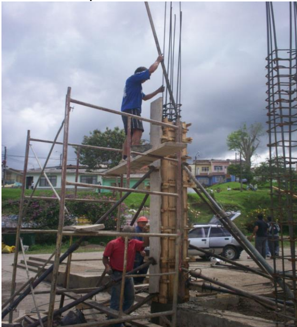
Foto 42: Compactación del concreto.
