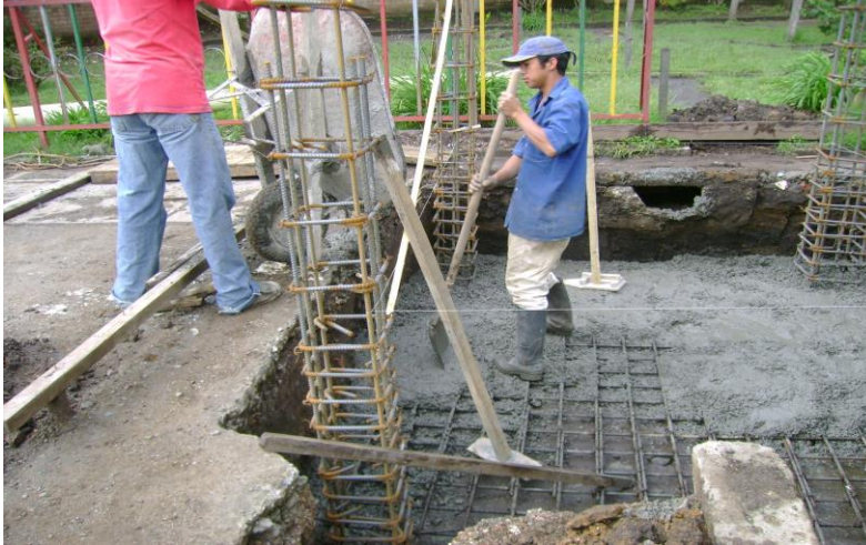
Foto 26: Colocación del concreto
