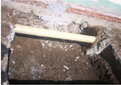
Foto 7: Excavación zapata tipo Z1.
