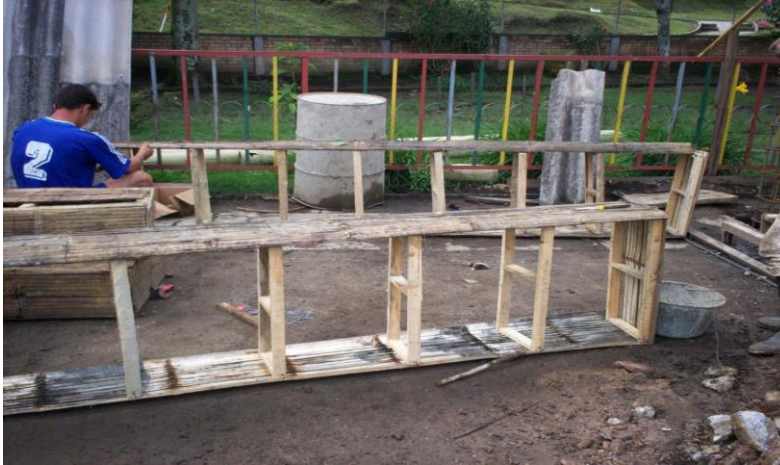
Foto 45: Casetones. Los casetones fueron contruidos en obra.
