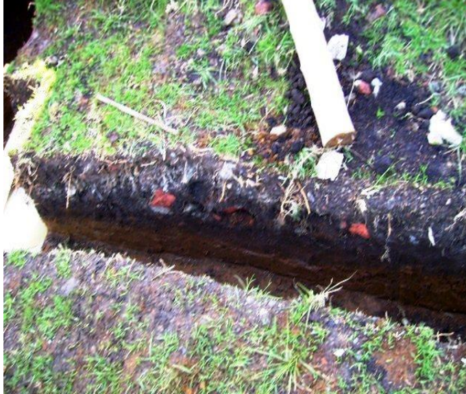
Foto 9: Excavación vigas de amarre.
