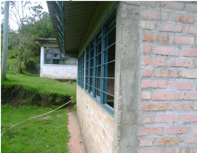
Foto 74: Puertas y ventanas.
