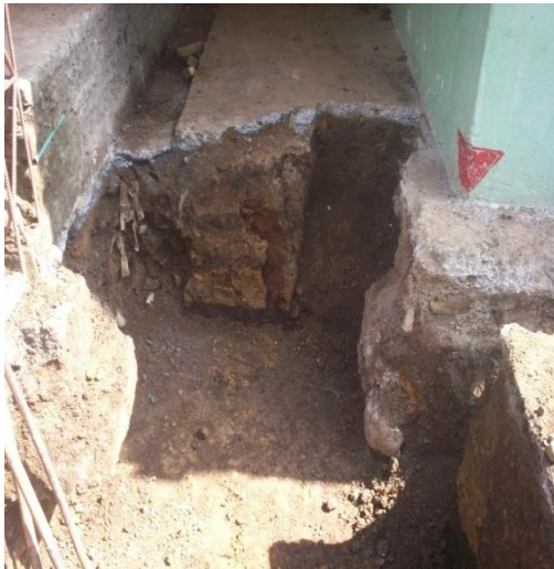
Foto 8: Excavación zapata tipo Z3.
