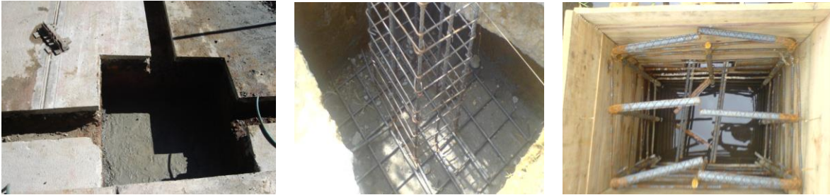
Pedestales anclados a las zapatas.
