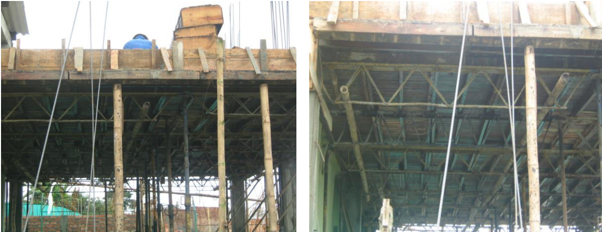
Formaleta Losa Aligerada
