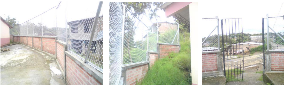
Mampostería, alfajía y malla eslabonada.
