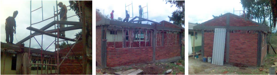
Construcción de la cubierta.
