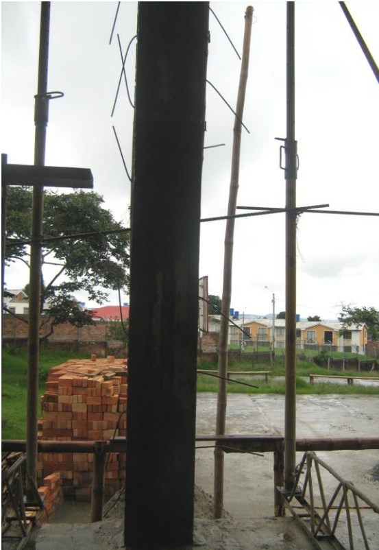
Varillas fundidas para anclar la mampostería
