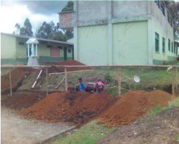
Excavación del terreno – zapatas y pantalla
