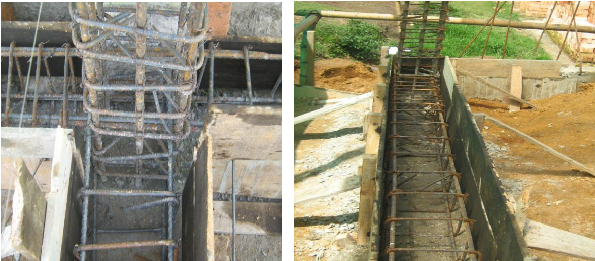
Solado para zapatas y vigas de amarre
