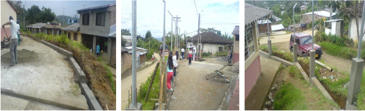
Vigas de sobrecimiento, columnetas y tubos anclados.
