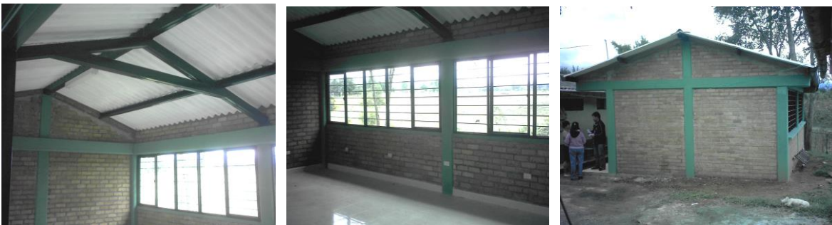
Terminación de la edificación. Salón de Sistemas.
