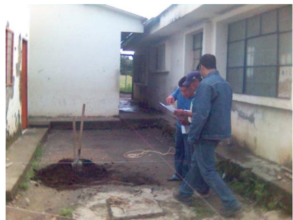
Alineación del salón de (3.0 * 4.0) m para dar inicio a la demolición.
