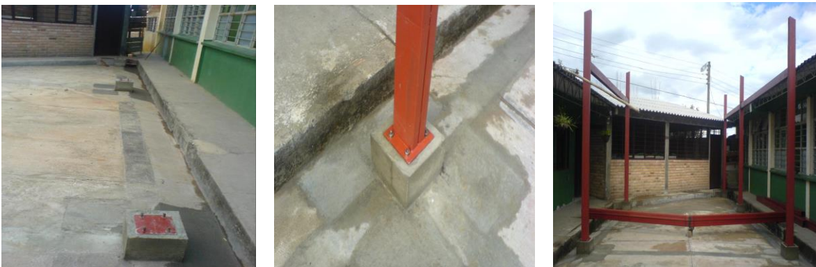
Platinas, columnas y vigas en perlines dobles.
