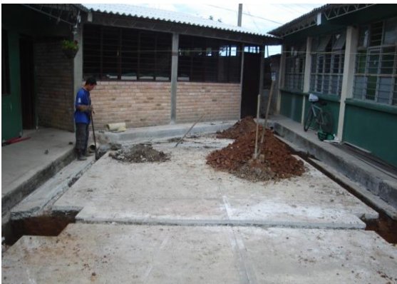
Corte de la losa de concreto (zapatas y vigas de sobrecimiento).
