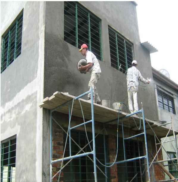
Repello de fachada
