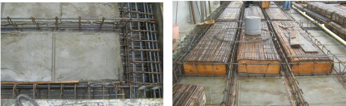
Losa aligerada con malla cargada con mortero
