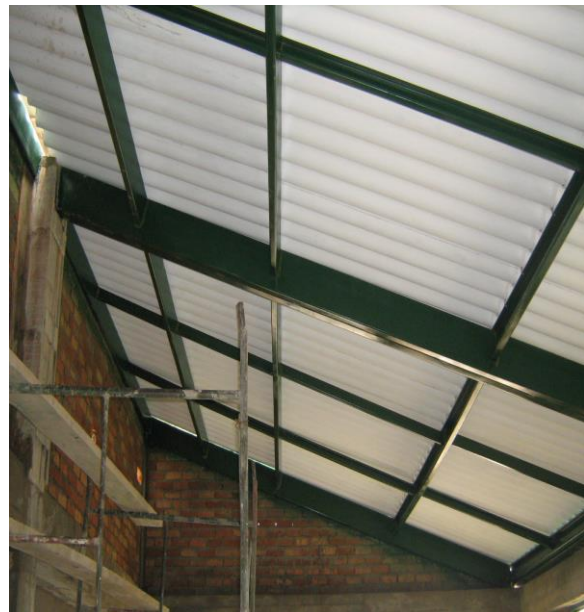
Tejas en Asbesto Cemento
