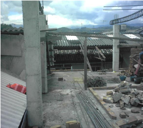
Columnas existentes y Viga de cubierta.
