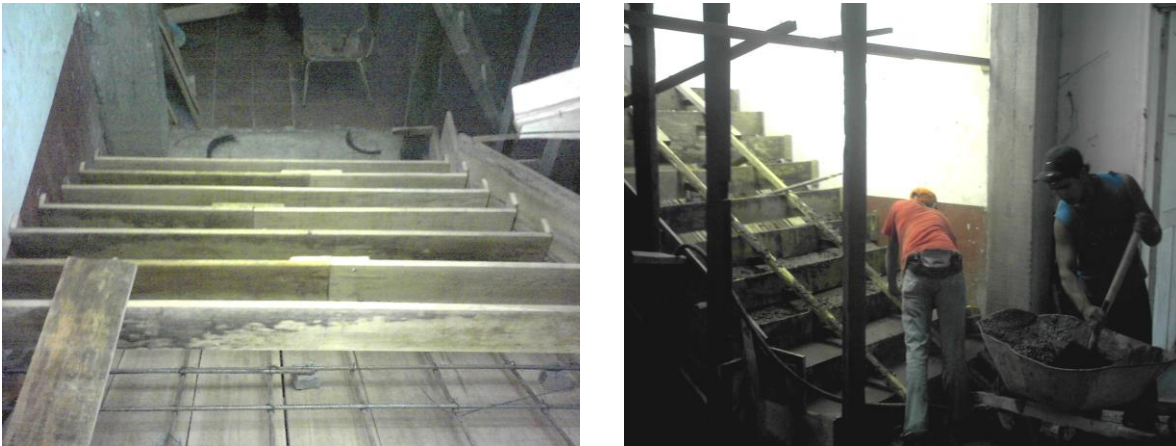
Fundición de la Grada
