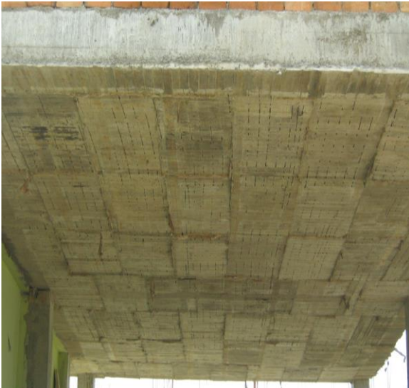
Acabado Losa Aligerada
