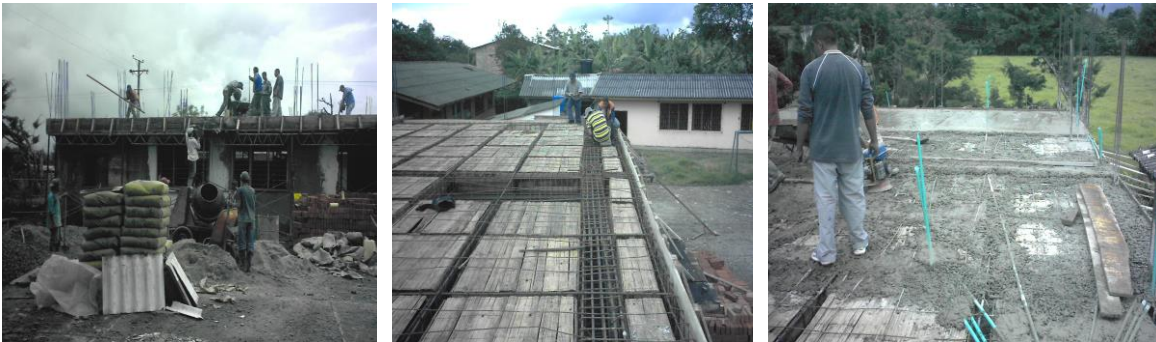
Colocación de la formaleta, acero y tubería.
