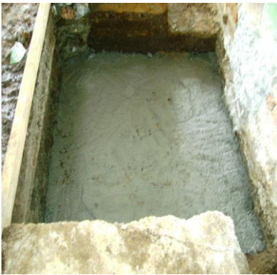
Solado en concreto pobre de 14 MPa, figurado de zapatas y columnas.
