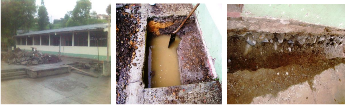
Edificación inicial, zapatas corridas (cimentación mejorada con ceto ciclopeo).
