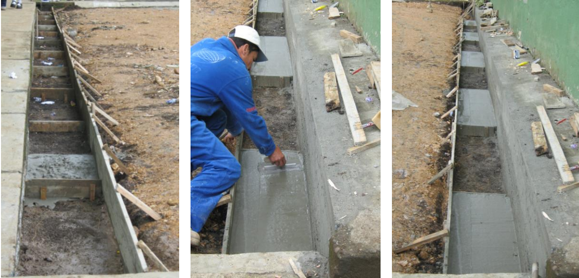
Forma de fundir las cunetas
