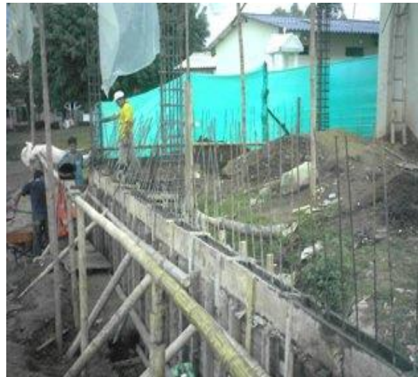
Formaleta para fundir la pantalla y la viga
