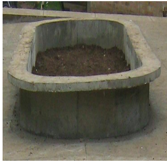
Matera Central: Pantalla e = 10 cm y Refuerzo 3/8" @15cm ambas direcciones Alfajía Reforzada, incluido 6 lagrimales para evacuación del agua.
