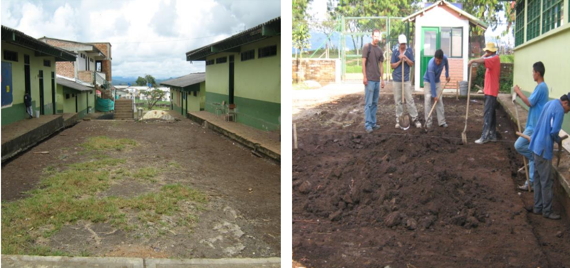
Nivelación y descapote del terreno
