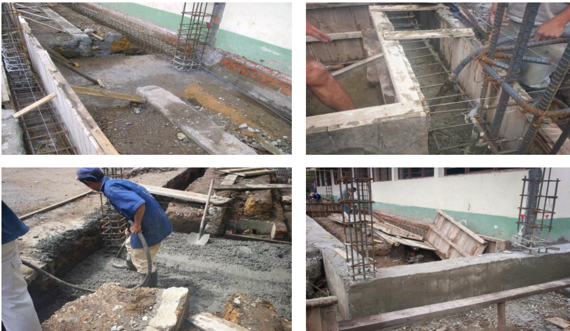
Fundición de zapatas y vigas de cimentación.
