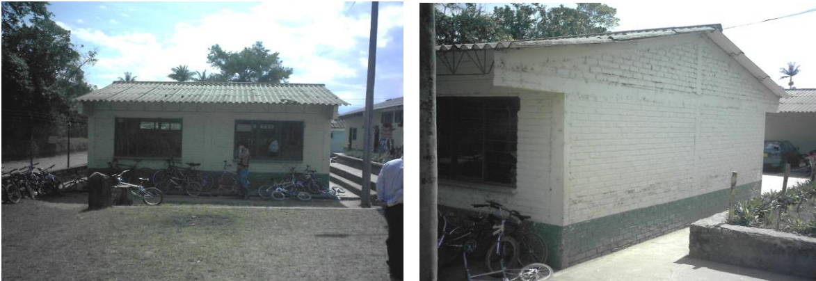
Salón existente para la construcción de un segundo piso.
