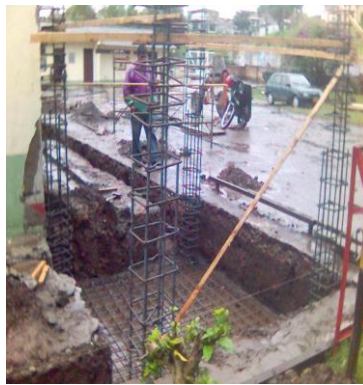
Solado en concreto pobre de 14 MPa, figurado de zapatas y columnas.
