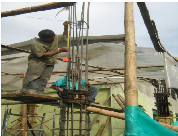
Traslapos de varillas en las columnas
