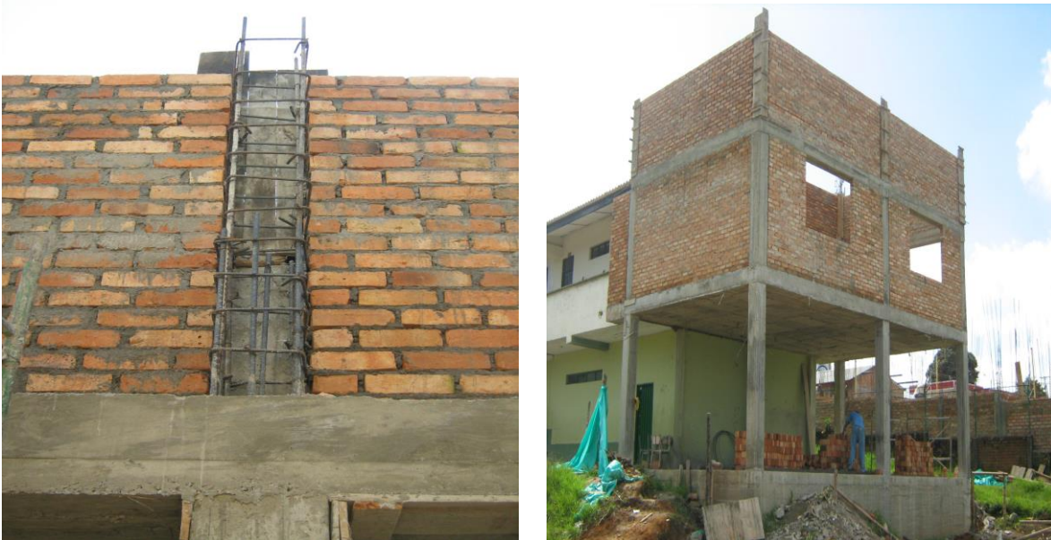
Columnas de 0.12 * 0.25 m para la construcción de la culata
