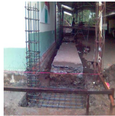
Solado en concreto pobre de 14 MPa, figurado de zapatas y columnas.
