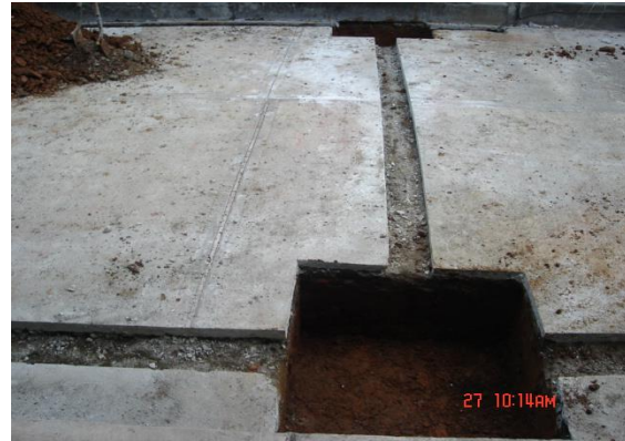
Corte de la losa de concreto (zapatas y vigas de sobrecimiento).
