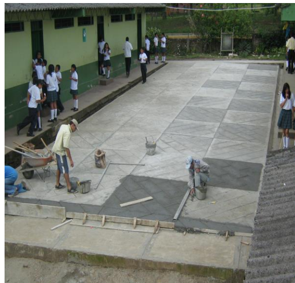
Pavimentacion Terminada – Patio Secundario
