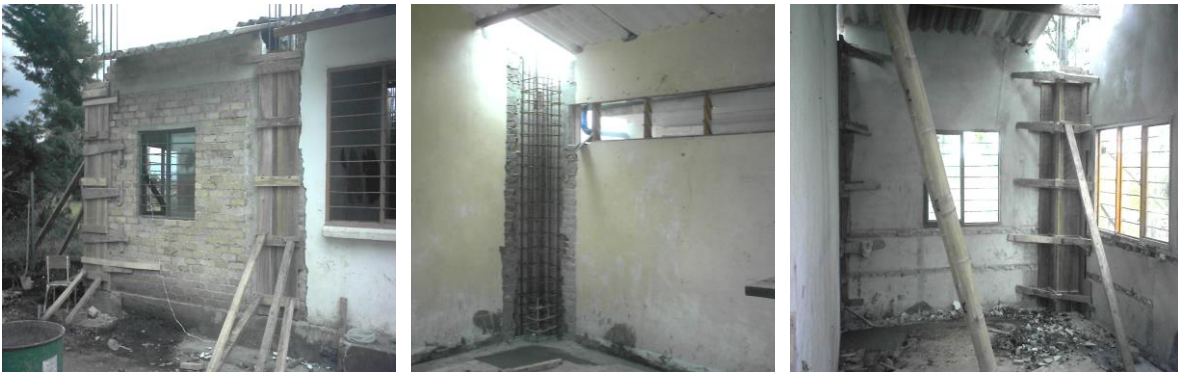
Colocación del acero y fundición de las columnas (Cocina).
