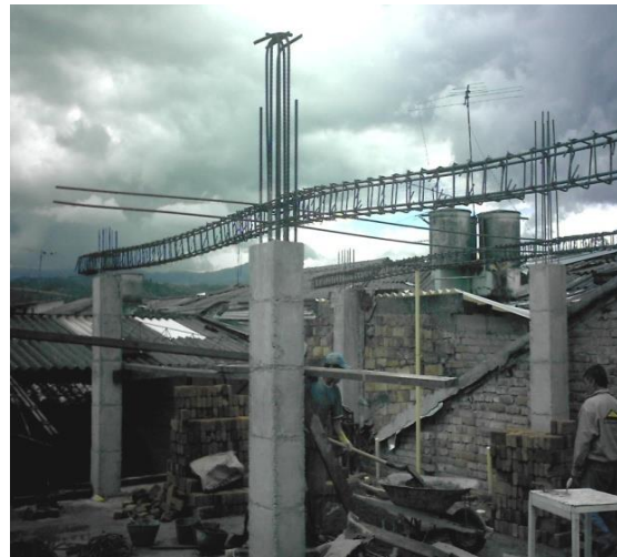
Columnas existentes y Viga de cubierta.
