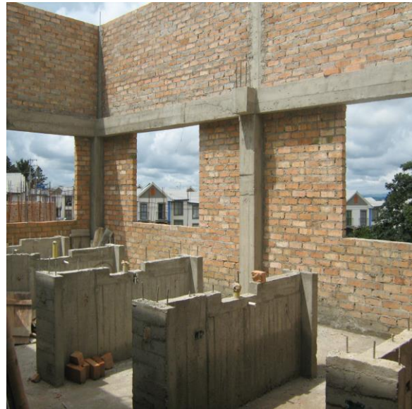
Ventanas soportadas sobre viga aérea (2do piso)
