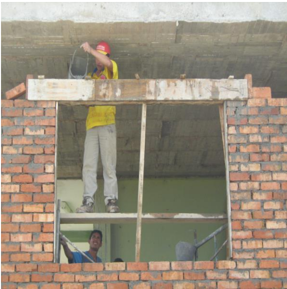
Construcción de la viga dintel (1er piso)
