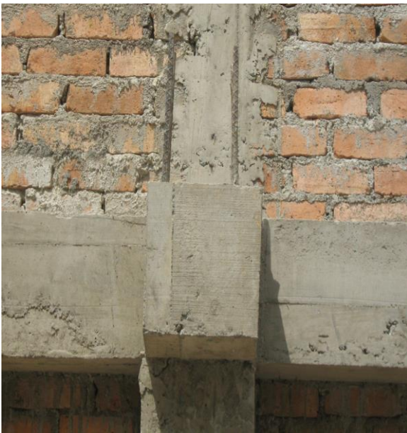
Ménsula de 0.30 x 0.30 x 0.35m constituida por 3#5@0.85m con E# 3@ 0.10m.
