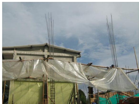
Traslapos de varillas en las columnas
