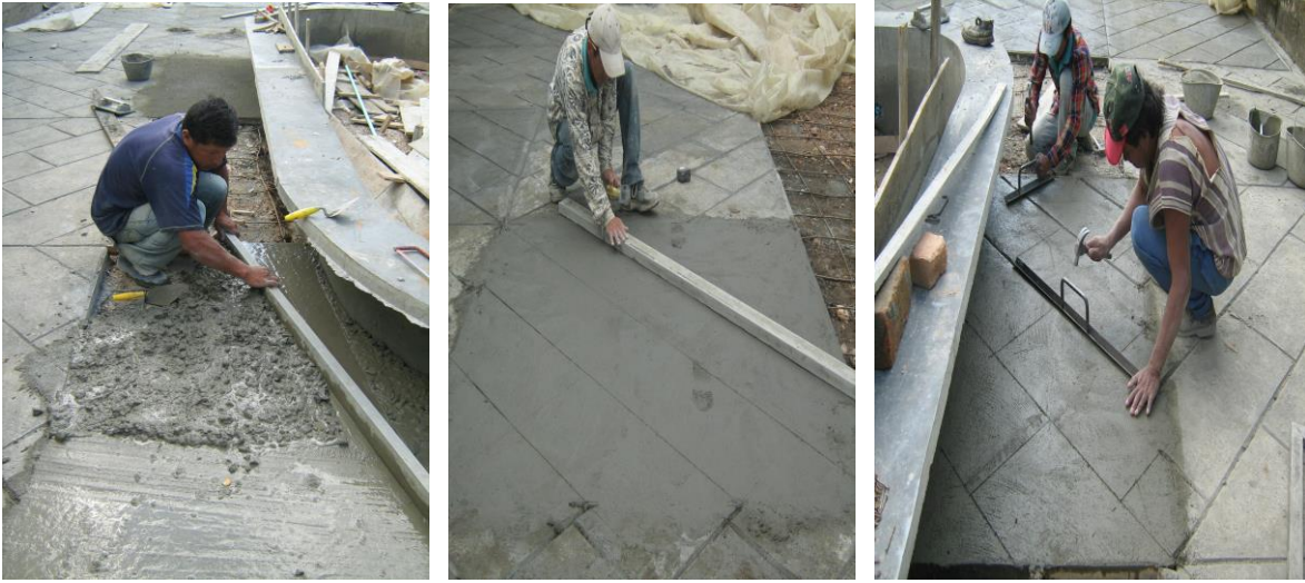
Construcción Imitacion Pavimento Articulado
