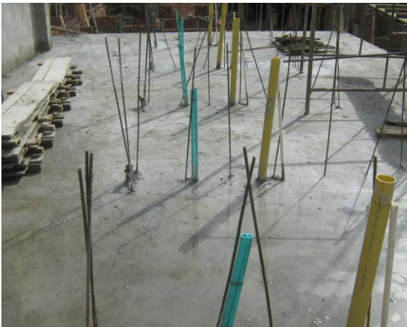
Tubería fundida en la losa
