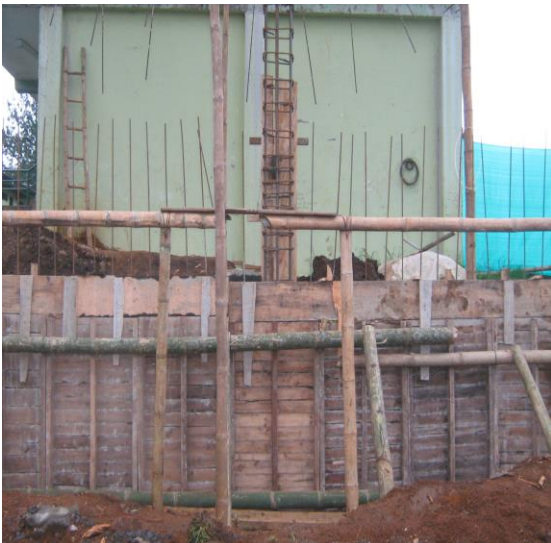
Formaleta para fundir la pantalla y la viga
