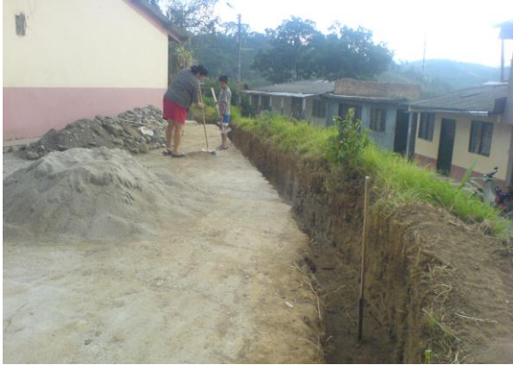
Excavacion y trazado del terreno.
