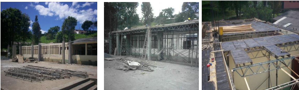
Colocación de la formaleta para la Losa Aligerada.
