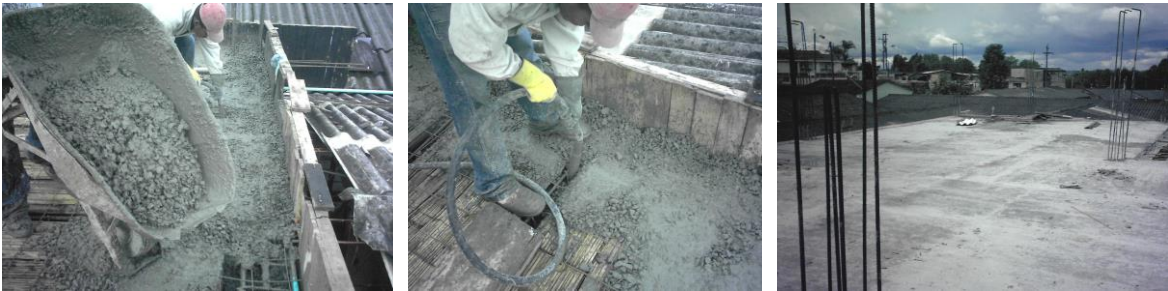
Vaciado y vibrado del concreto. Losa Fundida.
