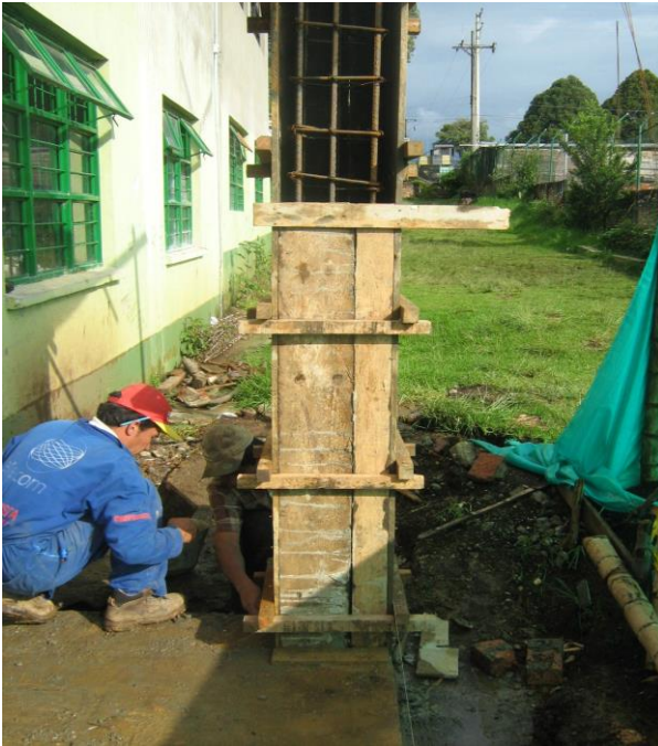
Formaleta y fundición de columna
