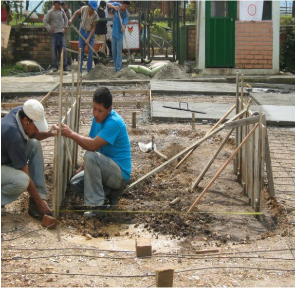
Matera Central: Pantalla e = 10 cm y Refuerzo 3/8" @15cm ambas direcciones Alfajía Reforzada, incluido 6 lagrimales para evacuación del agua.
