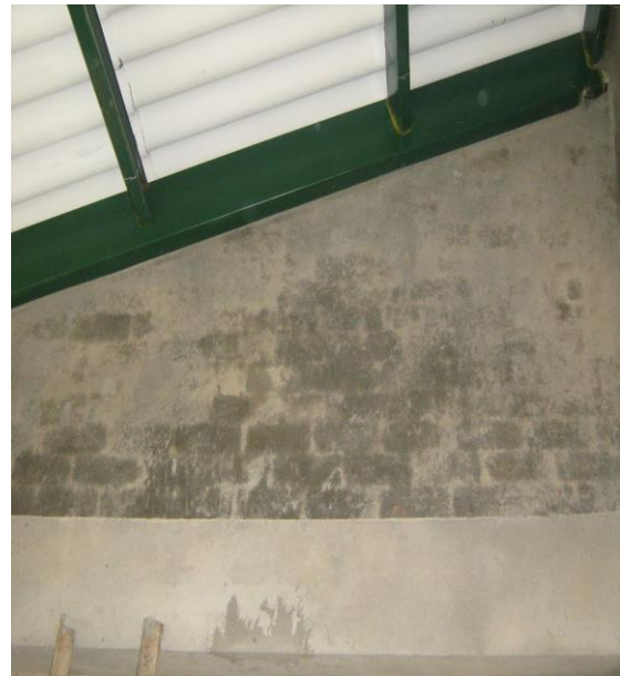
Mal curado del repello
