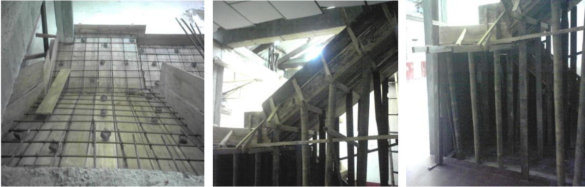
Encofrado y Parrilla de la Grada
