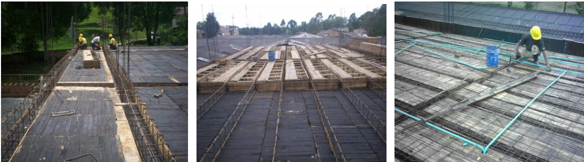
Colocación del acero figurado, casetones y tubería eléctrica.
