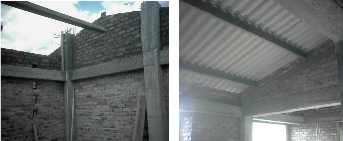
Construcción de Cubierta
