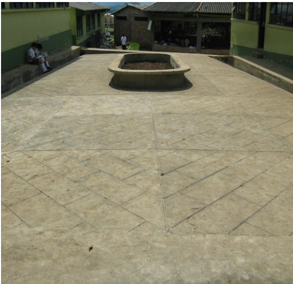
Pavimentación Terminada – Patio Principal
