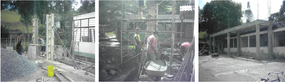
Formaleta para columnas, vaciado del concreto y retirada de la formaleta.
