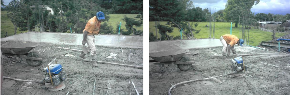
Fundición de la Losa Aligerada.
