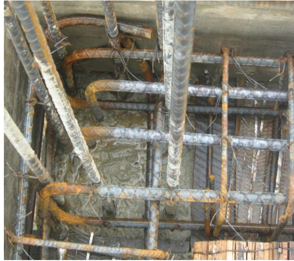
Viga exterior reforzada con 4 bastones de 2.0m
