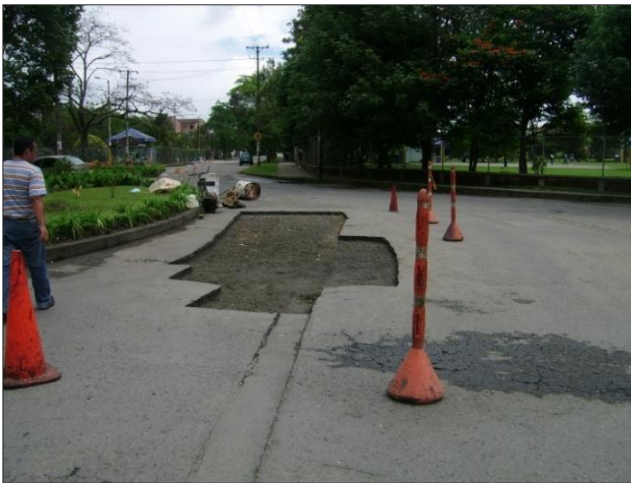
Ilustración 13. Bache listo para imprimacion. Glorieta carrera 15 con calle 18N. Villa Olimpica.
