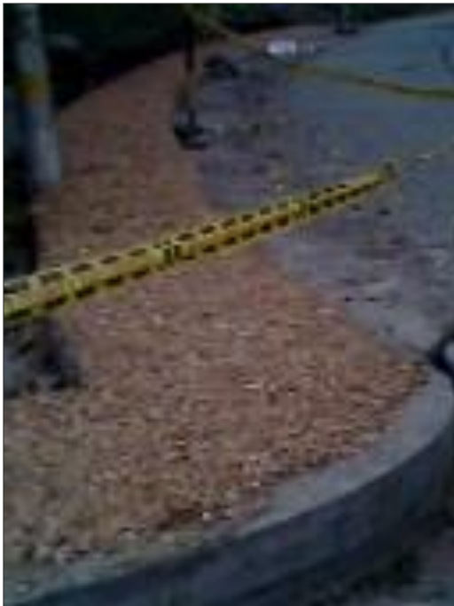
Ilustración 29 y 30. Curado de las losas de concreto con aserrín mojado para evitar la pérdida del agua de reacción del concreto.
