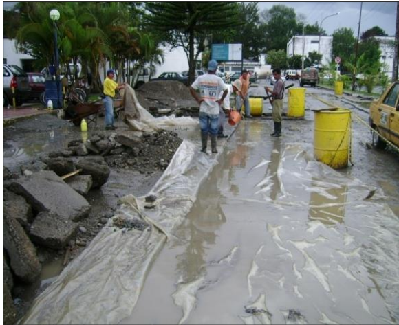
Ilustración 21. Plastico colocado para proteger del agua la excavacion realizada. Entrada principal de la clinica La Estancia.
