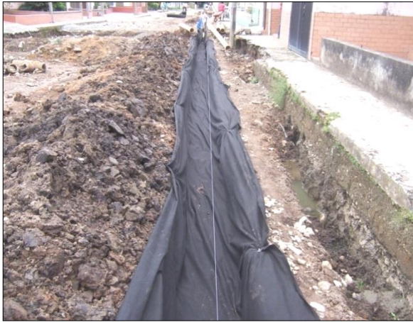
Ilustración 32. Excavacion y colocacion del Geotextil.
