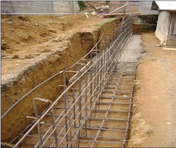
Ilustración 50. Fundición de la base del muro.
