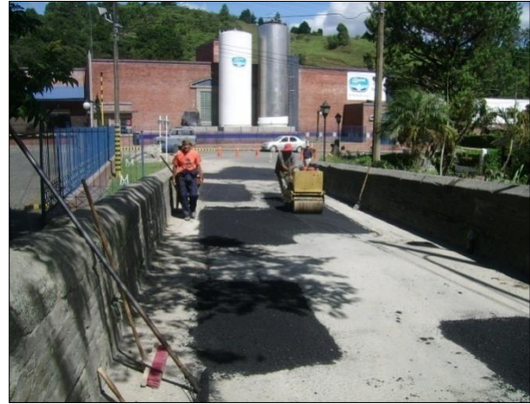
Ilustración 42 y 43. Colocación y compactación de la Mezcla Asfáltica. Tramo sobre el Puente de Cauca
