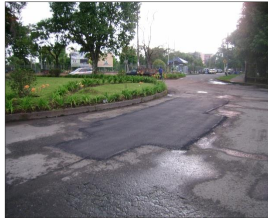
Ilustración 16. Bache terminado. Glorieta Calle 18N con carrera 15. Villa Olímpica.
