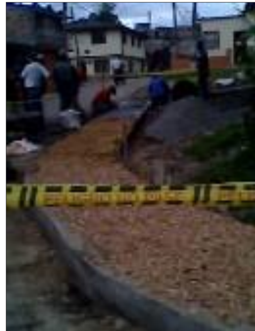
Ilustración 29 y 30. Curado de las losas de concreto con aserrín mojado para evitar la pérdida del agua de reacción del concreto.
