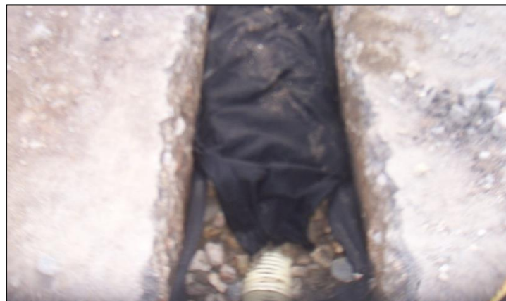
Ilustración 31. Recubrimiento con el geotextil.
