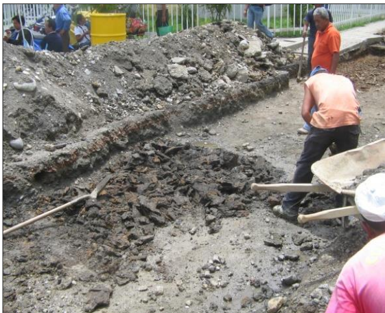
Ilustración 19. Excavacion a mano en la estructura del pavimento. Entrada principal de la clinica La Estancia.
