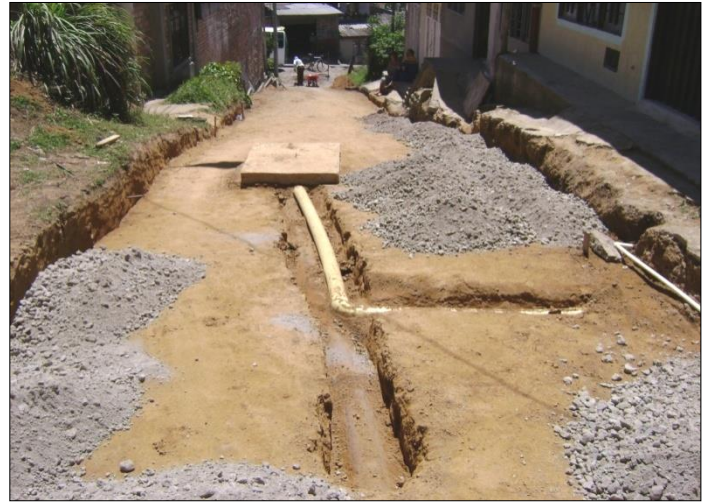
Ilustración 2. Suministro de subbase granular triturada.
