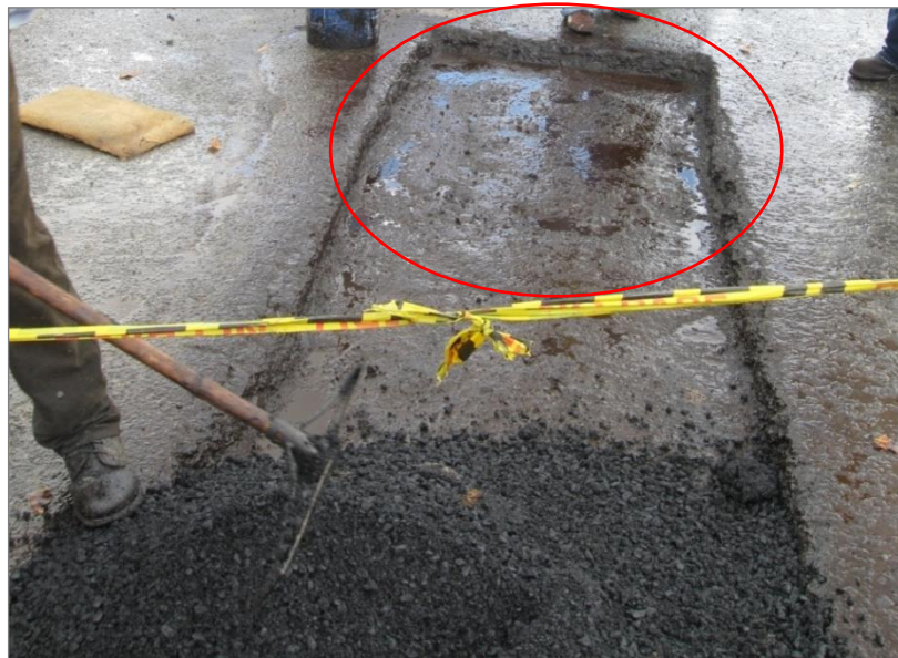
Ilustración 69. Colocacion de la mezcla asfaltica. Calle 17 con carrera 10A.
