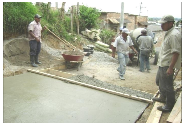
Ilustración 5 y 6. Elaboración y colocación del concreto en obra con su respectiva formaleta.
