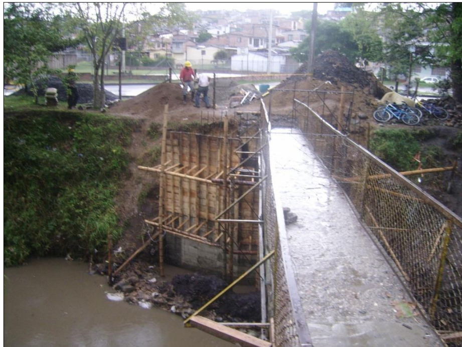
Ilustración 34. Vista exterior de la formaleta en el muro de estribo.
