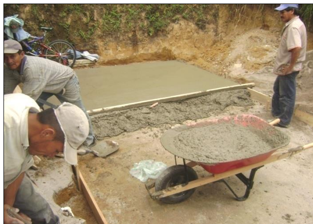
Ilustración 5 y 6. Elaboración y colocación del concreto en obra con su respectiva formaleta.
