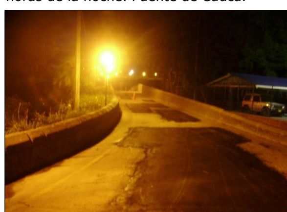
Ilustración 47. Parcheo concluido sobre el Puente de Cauca. Vista desde Lacteos.
