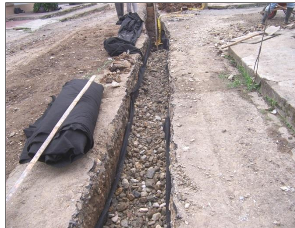
Ilustración 35. filtro listo para el recubrimiento con el geotextil.
