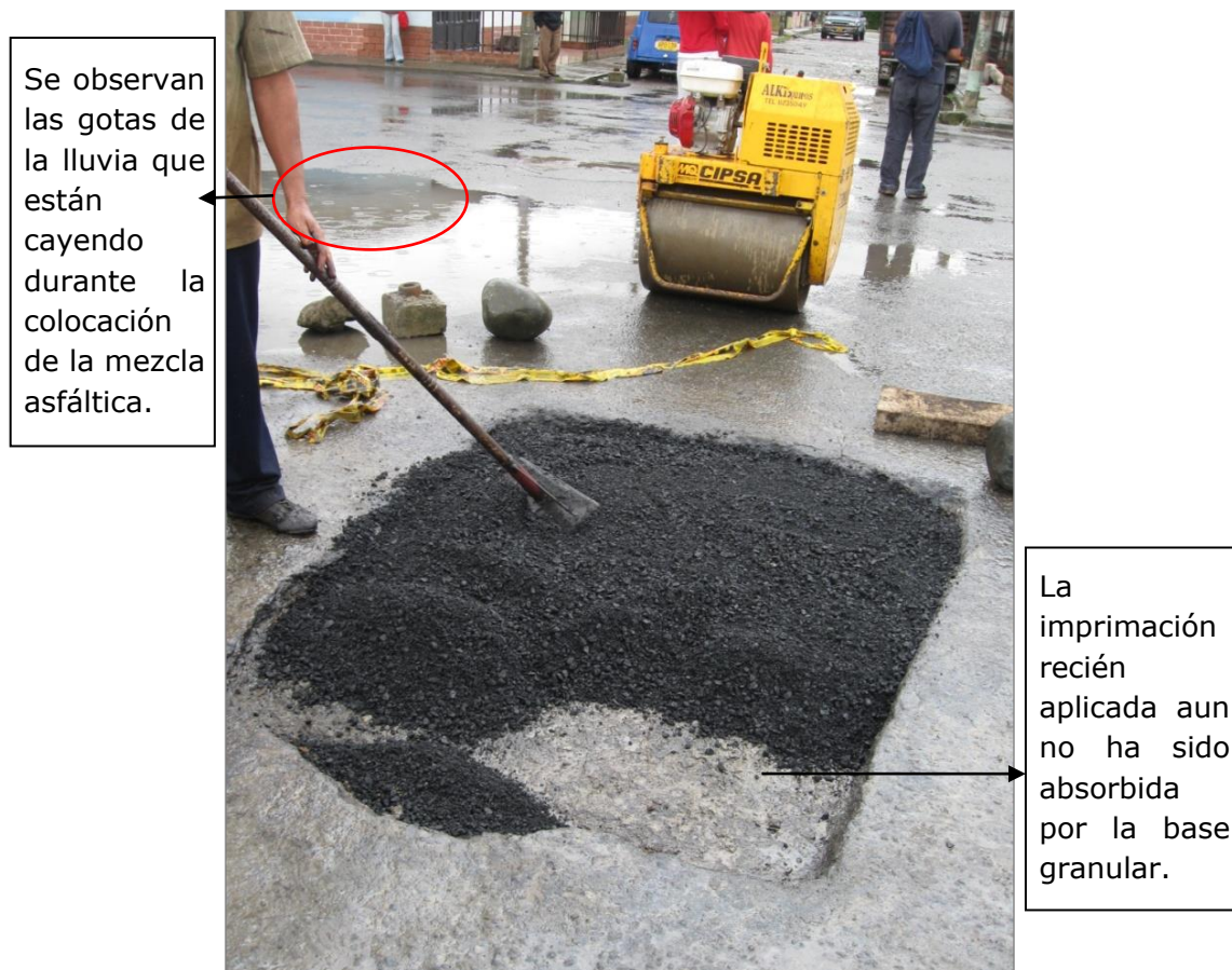
Ilustración 67. Colocacion de la mezcla asfáltica. Carrera 9 desde la calle 13 hacia la calle 17
