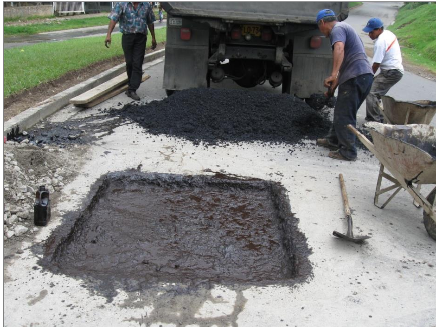
Ilustración 68. Colocacion de la mezcla asfaltica. Tramo de la Carrera 12 desde la piedra sur hacia la calle 22.
