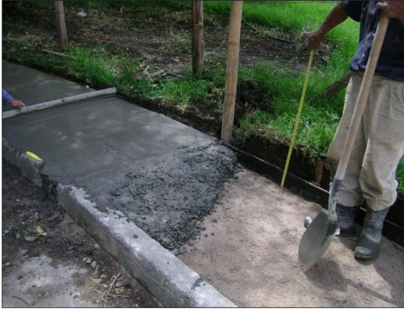
Ilustración 27. Fundición de los andenes, acabado y medición del espesor.
