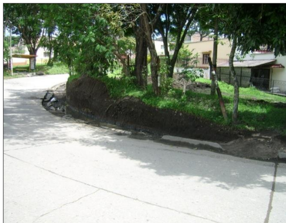
Ilustración 25 y 26. Corte de taludes para proporcionar el espacio del anden.
