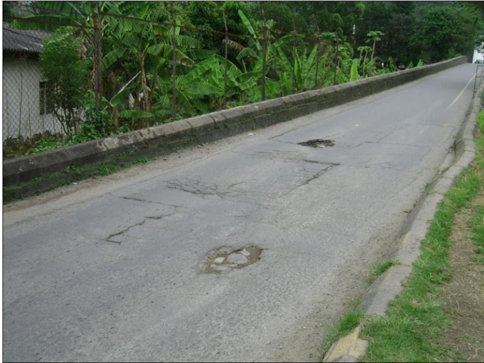
Ilustración 40. Estado inicial de la vía sobre el Puente de Cauca.
