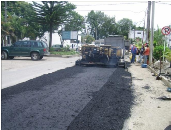
Ilustración 23 y 24. Riego de la Mezcla Asfaltica MDC-2 con Finisher, espesor 10 cm. Entrada principal clinica La Estancia.
