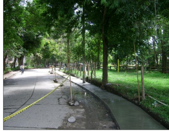
Ilustración 28. Anden recién terminado con señalización.
