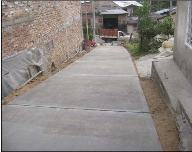
Ilustración 7. Concreto terminado, vista desde la parte superior de la vía.
