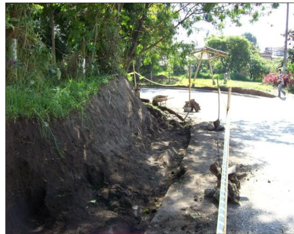
Ilustración 25 y 26. Corte de taludes para proporcionar el espacio del anden.
