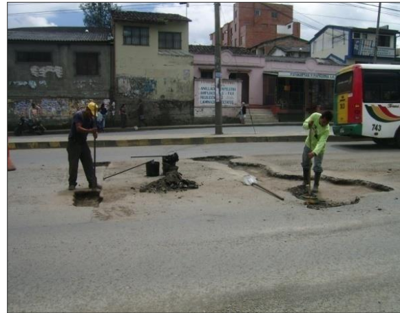
Ilustración 20. Definición de baches y barrido previo a la imprimación. Carrera 6 frente al parqueadero de la Facultad de Medicina de la Universidad del Cauca
