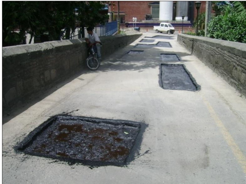
Ilustración 41. Baches definidos e imprimados. Puente de Cauca
