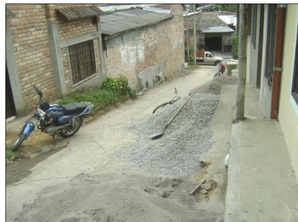
Ilustración 4. Materiales para la elaboración del concreto puestos en obra.
