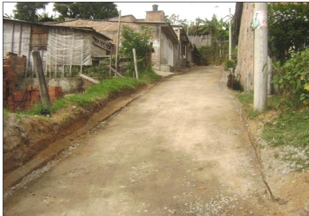
Ilustración 3. Subbase granular extendida y compactada.
