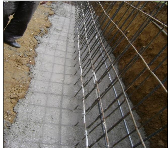
Ilustración 51. Base fundida y lista para la fundición del muro.
