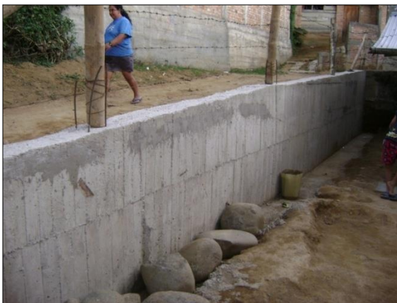
Ilustración 54. Muro de Contencion Terminado.
