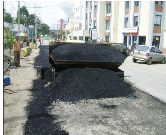
Ilustración 23 y 24. Riego de la Mezcla Asfaltica MDC-2 con Finisher, espesor 10 cm. Entrada principal clinica La Estancia.
