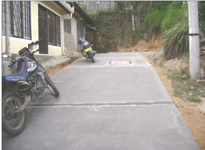
Ilustración 8. Concreto terminado, vista desde la parte inferior de la vía.
