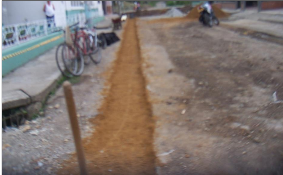
Ilustración 32. Filtro terminado y cubierto con tierra amarilla compactada.
