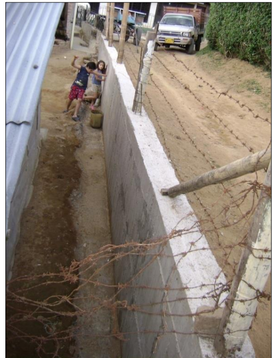
Ilustración 53. Muro de Contencion Terminado.
