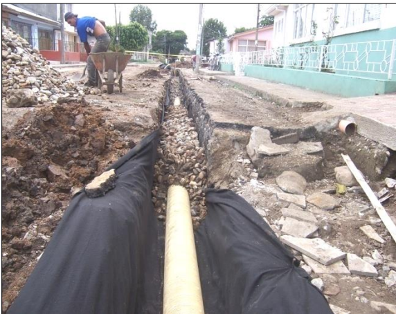
Ilustración 34. Colocación del material granular de filtro.
