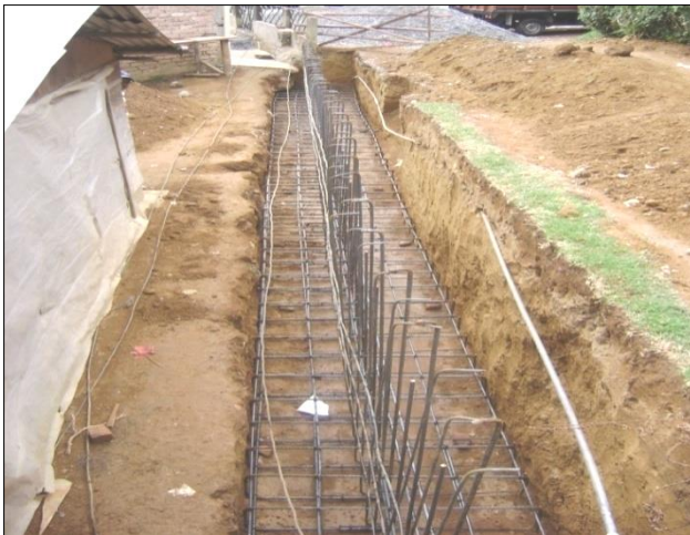
Ilustración 48. Estructura de acero lista para la fundición de la base.
