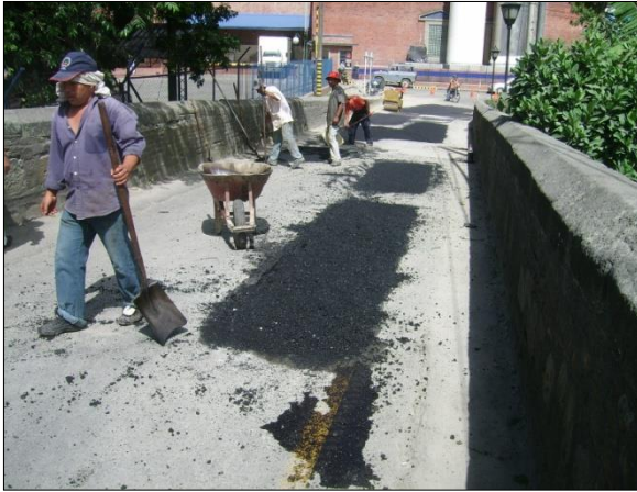
Ilustración 42 y 43. Colocación y compactación de la Mezcla Asfáltica. Tramo sobre el Puente de Cauca
