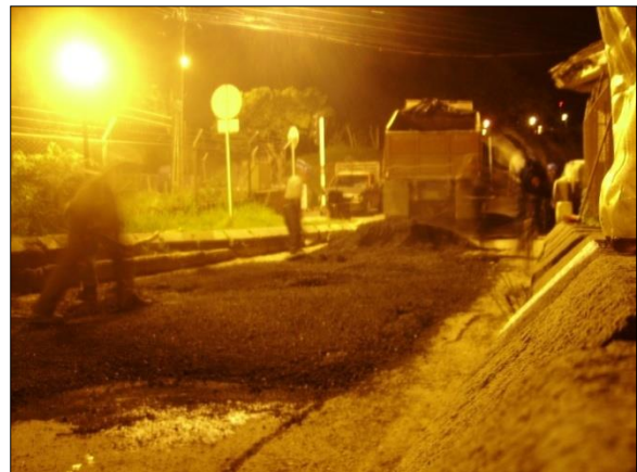
Ilustración 45. Trabajos de riego y compactación de la mezcla asfáltica en horas de la noche. Puente de Cauca.
