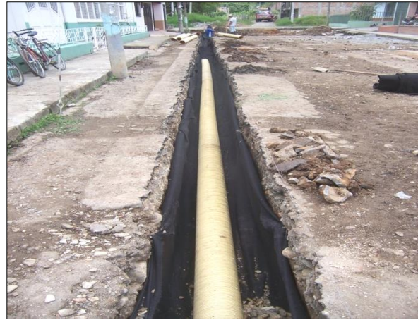
Ilustración 33. Geotextil y tubería perforada PVC D=8"
