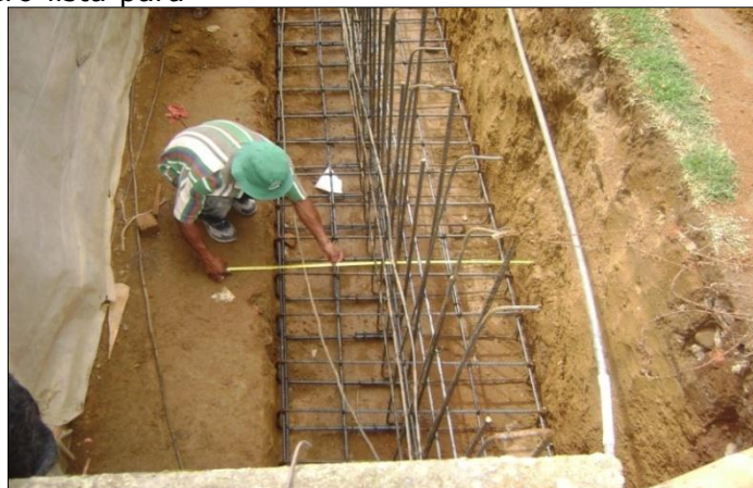
Ilustración 49. Medición de la base del muro.
