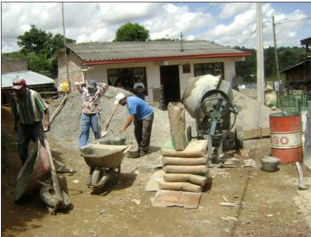
Ilustración 52. Elaboracion del concreto en el sitio de la obra.
