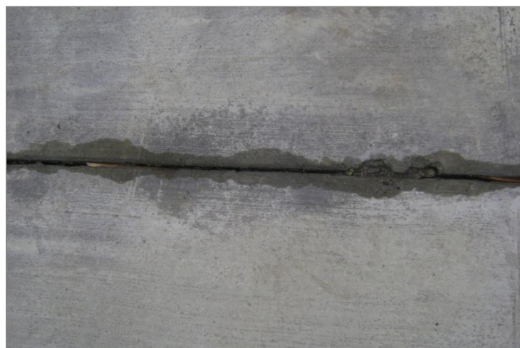
Ilustración 59. Ejemplo de Pavimento Rigido sin sello de Juntas. Calle 8 entre carreras 12 y 13
