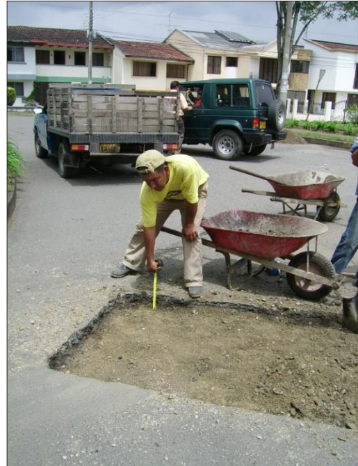
Ilustración 12. Medicion del espesor de la capa asfáltica. Glorieta carrera 15 con calle 18N. Villa Olimpica.
